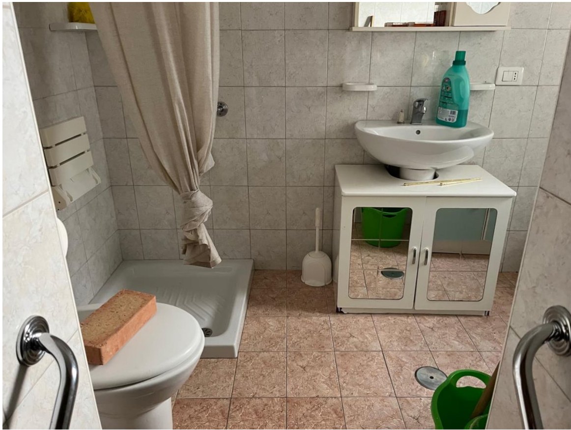
Foto 15 – bagno al piano terra
