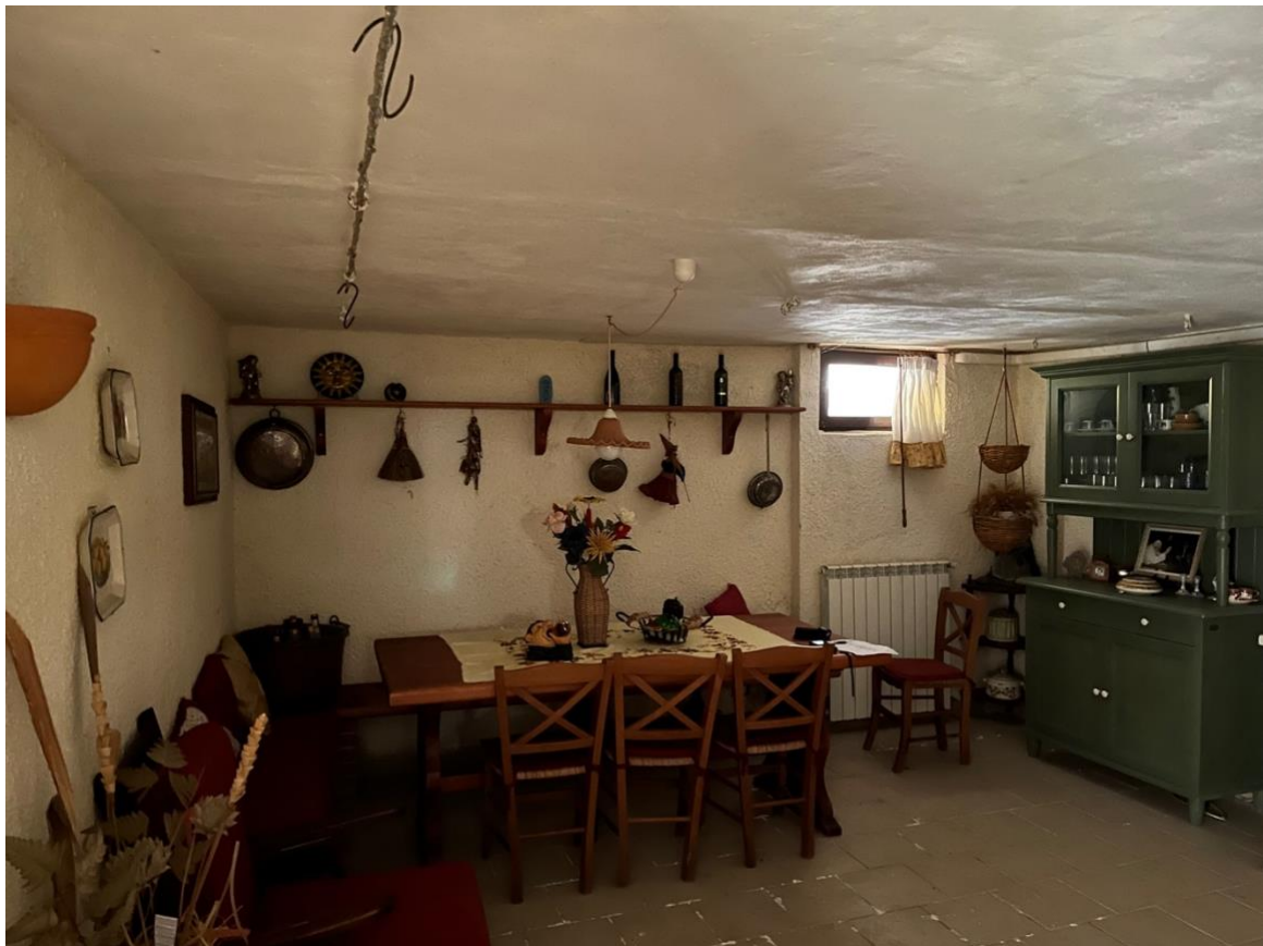
Foto 44– locale cantina (impropriamente adibito a tavernetta) al piano seminterrato
