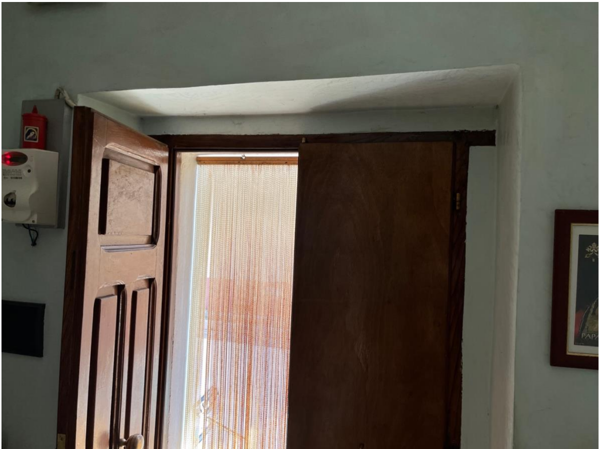
Foto 11 – ingresso del fabbricato con particolare del contatore energia elettrica
