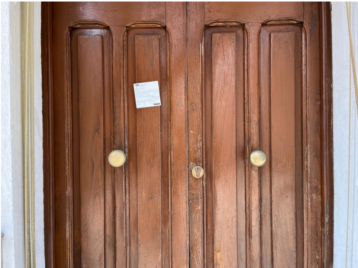
Foto 8 – dettaglio del portone d'ingresso del fabbricato
