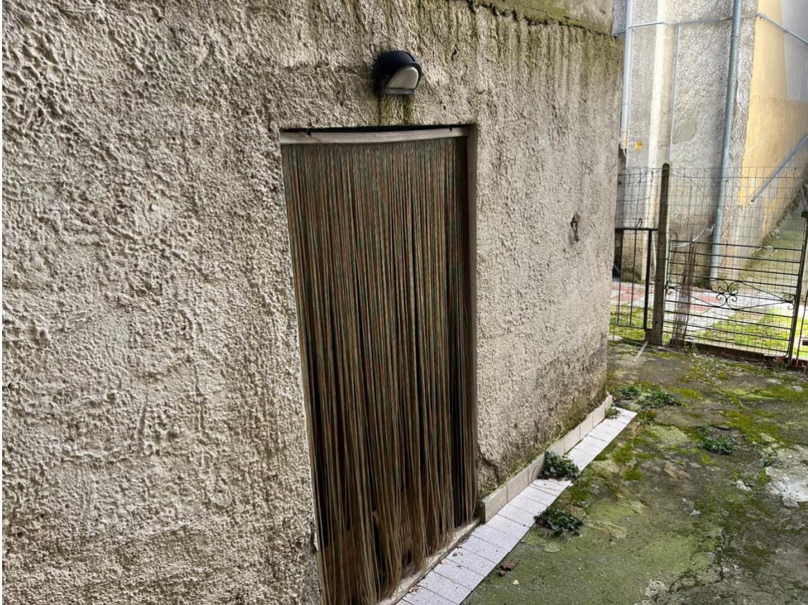
Foto 43 – porta di accesso alla cantinetta posta al piano seminterrato
