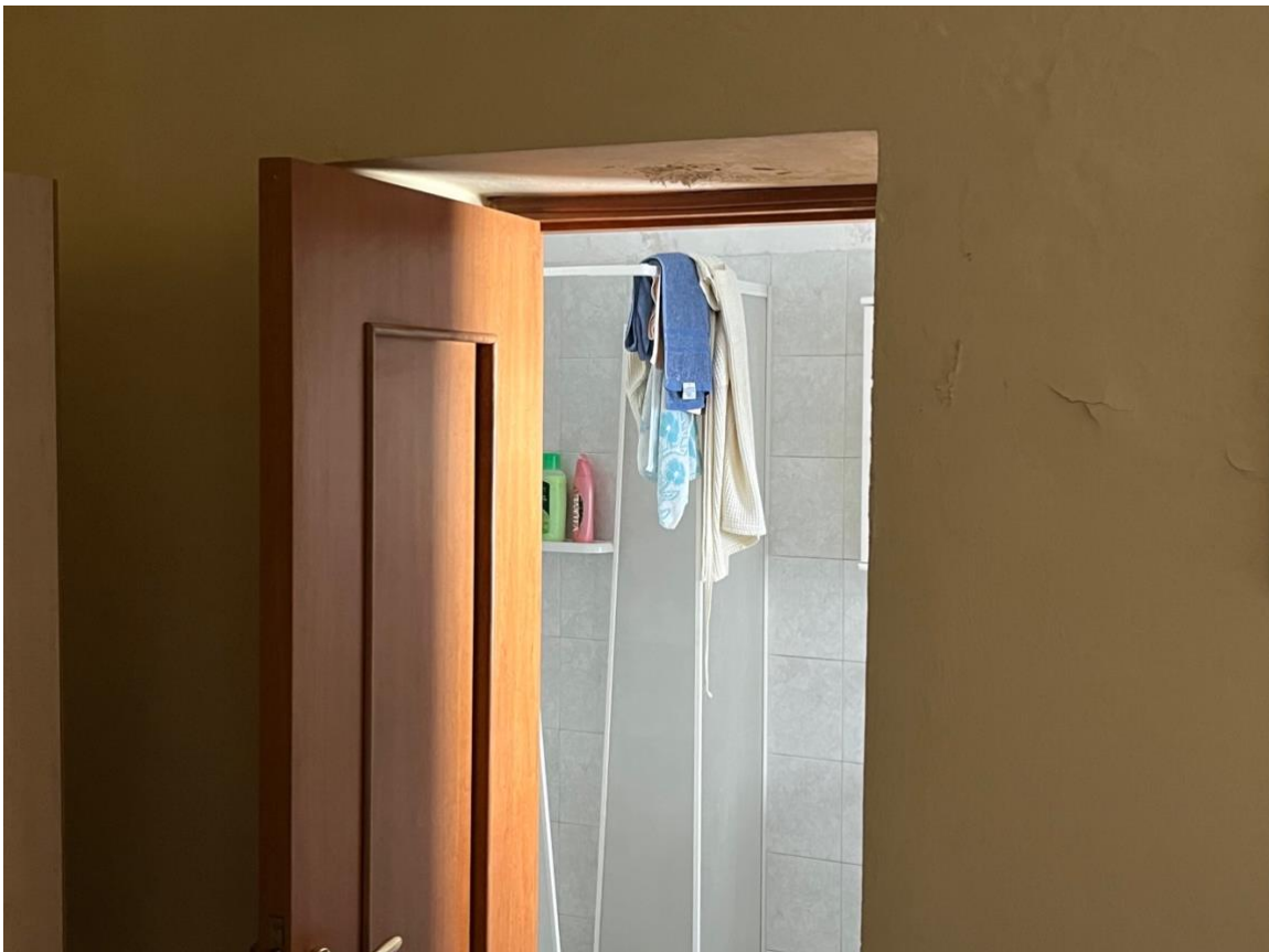
Foto 32 – bagno al piano primo
