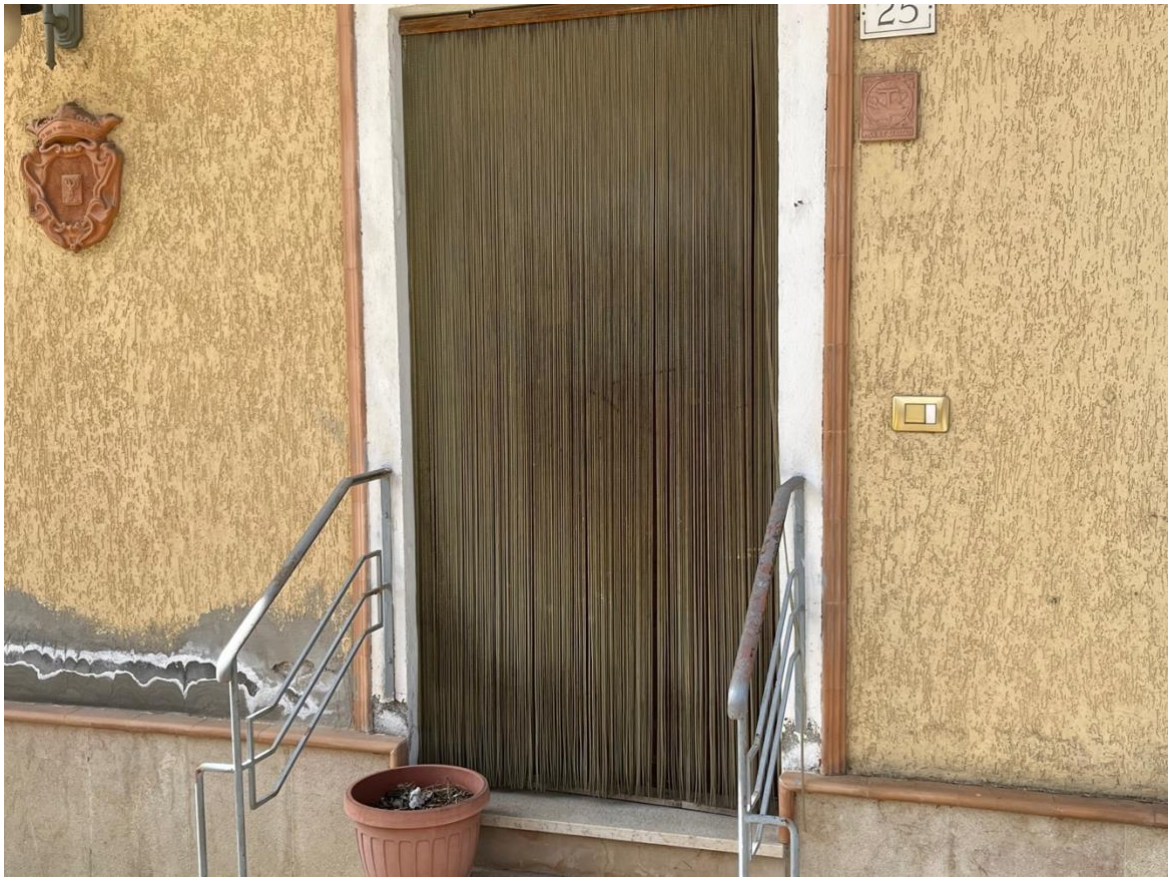
Foto 7 – portone d'ingresso del fabbricato
