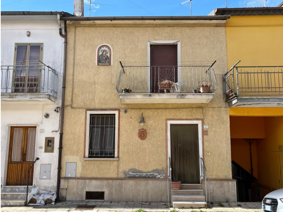
Foto 1 – esterno del fabbricato fronte strada
