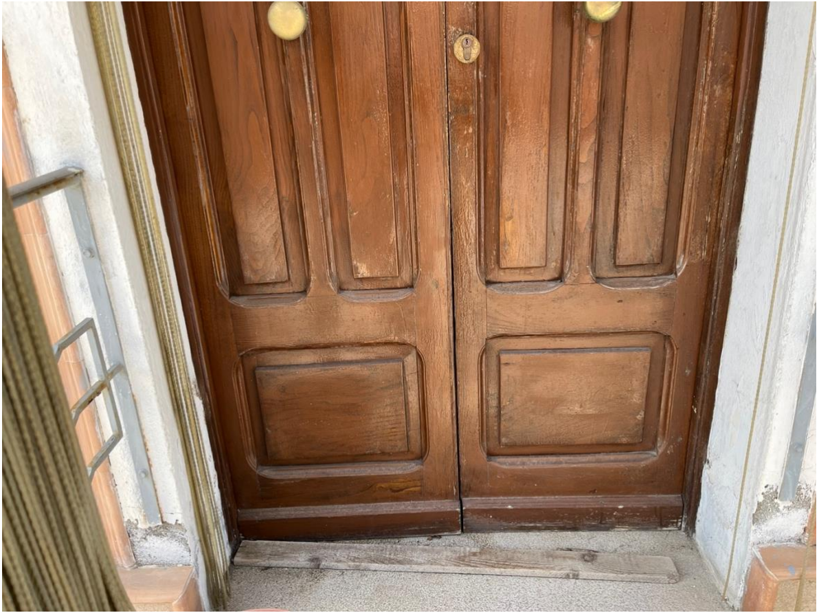
Foto 9 – dettaglio del portone d'ingresso del fabbricato
