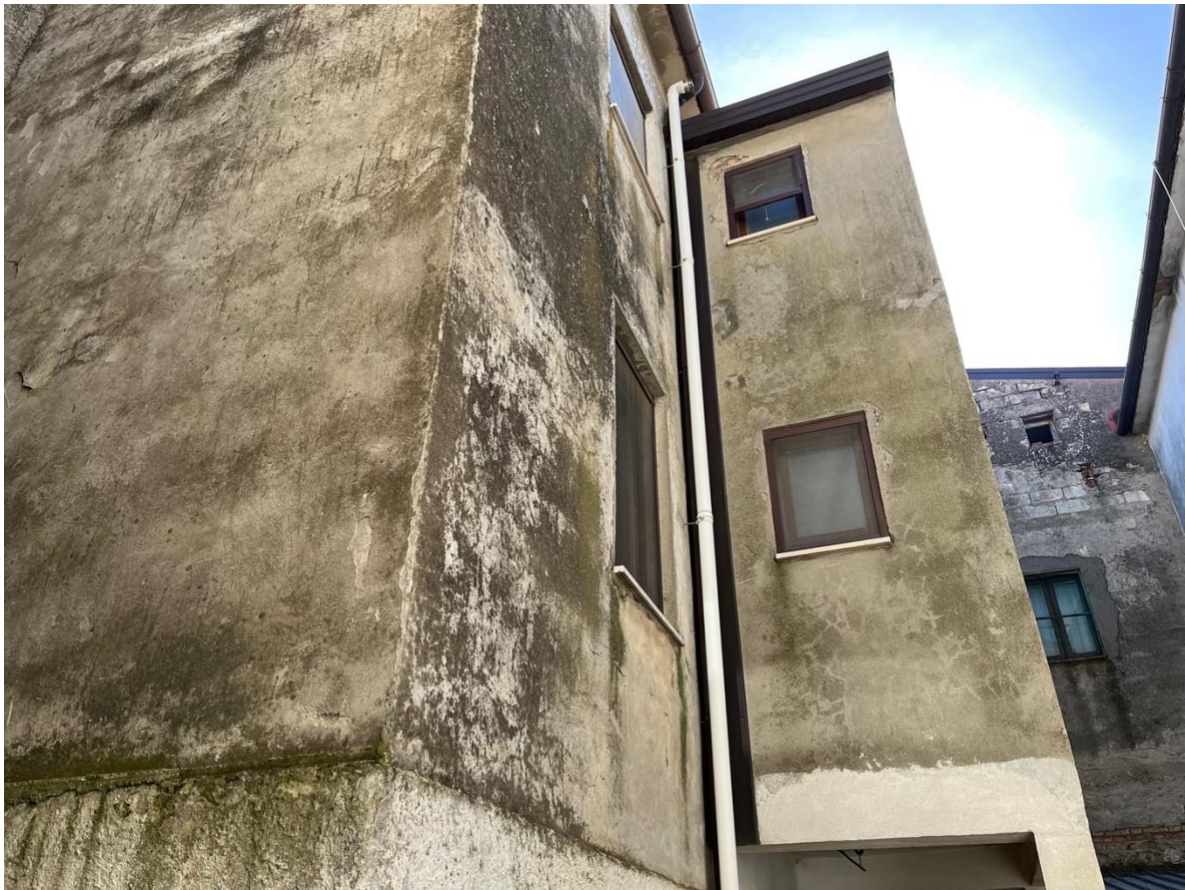
Foto 5 – esterno del fabbricato visto dal retro
