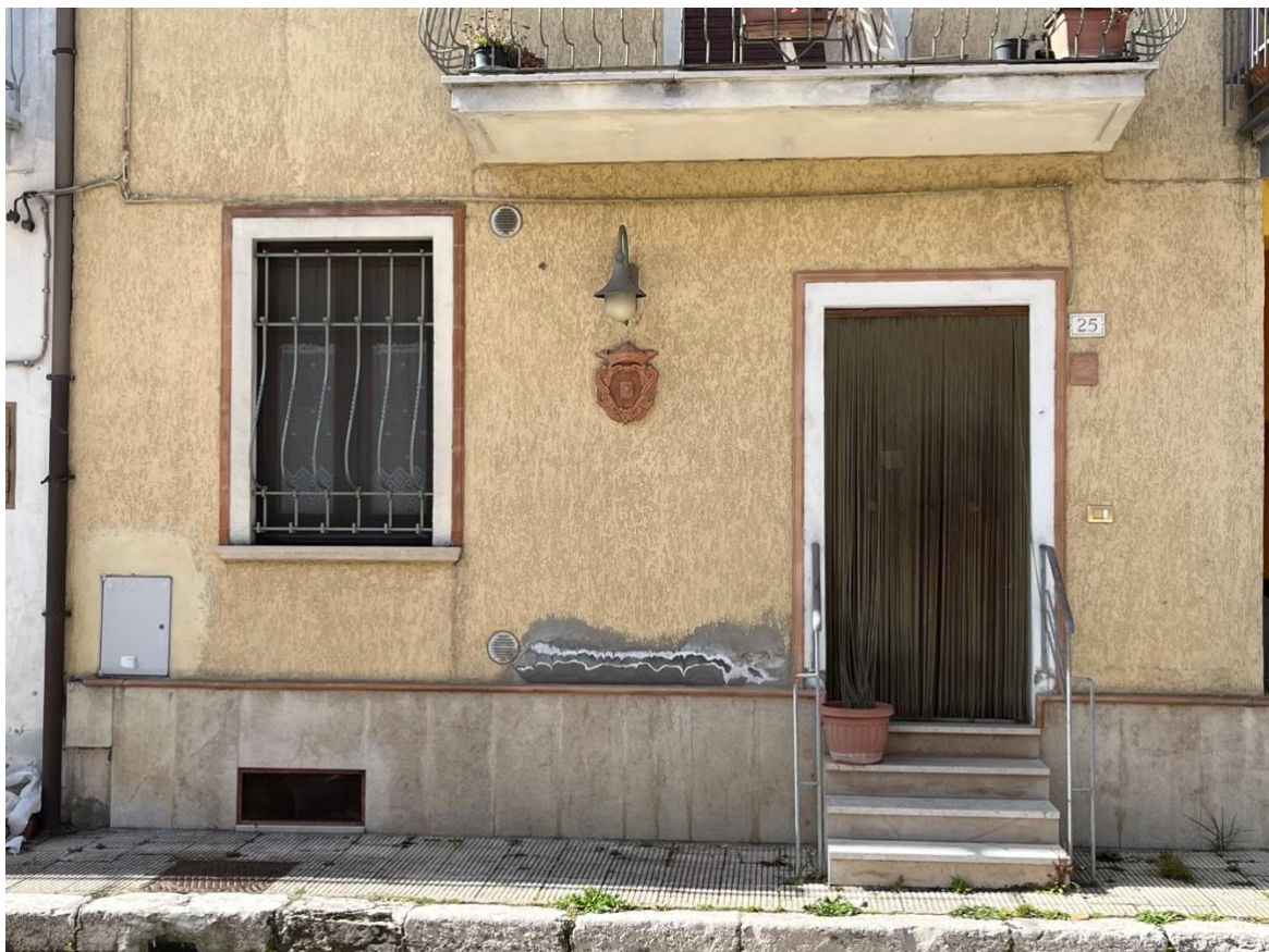
Foto 2 – esterno del fabbricato, piano terra
