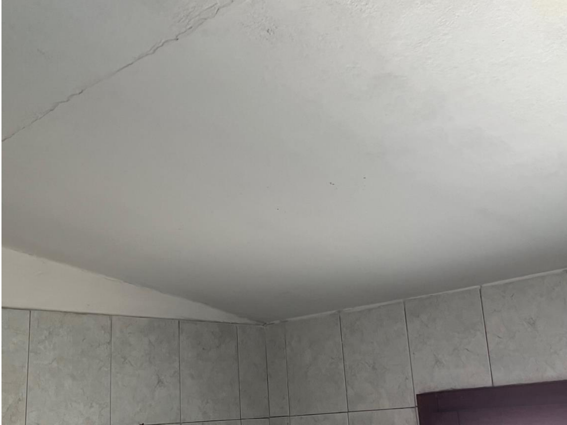
Foto 37 – particolare del tetto a falde nel bagno al piano primo nel punto più basso (altezza 2,02 m)
