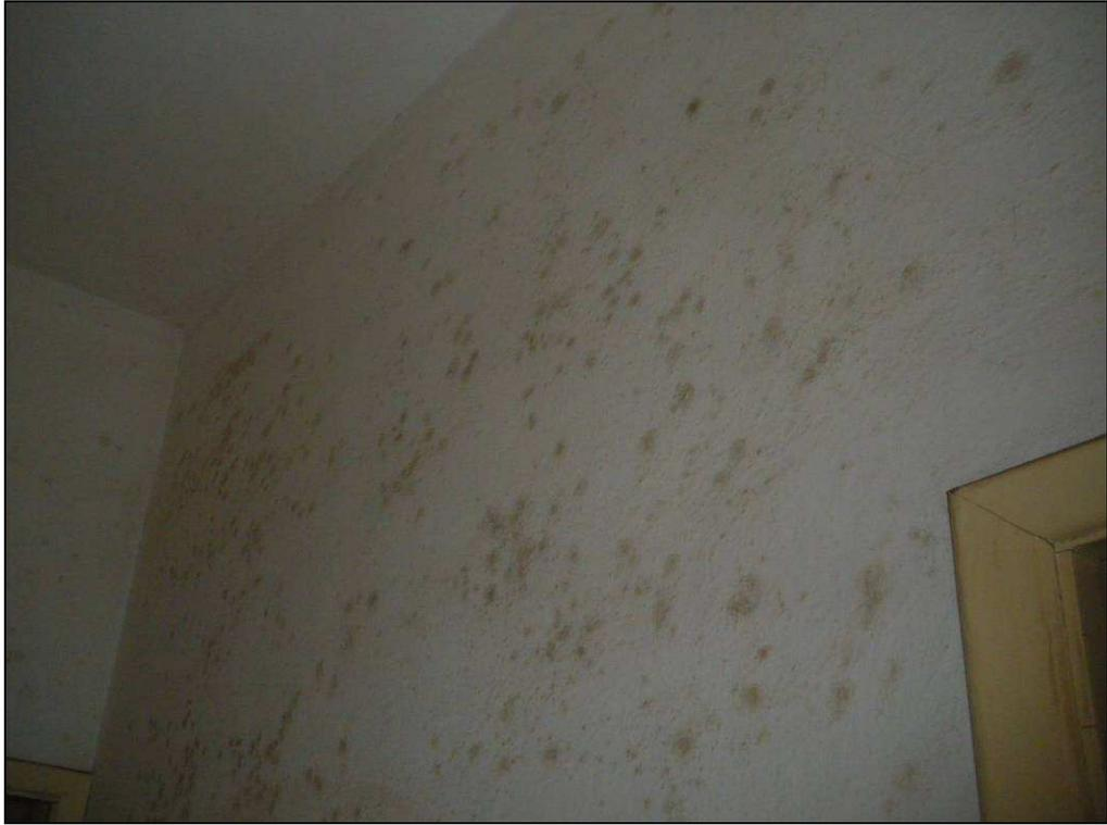
Foto n. 40: particolare dell'umidità nel corridoio
