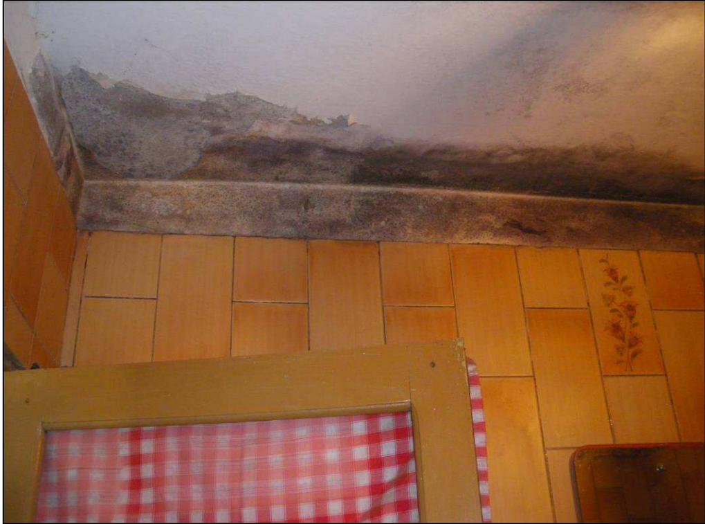
Foto n. 32: particolare tracce umidità e distacco intonaco nel bagno
