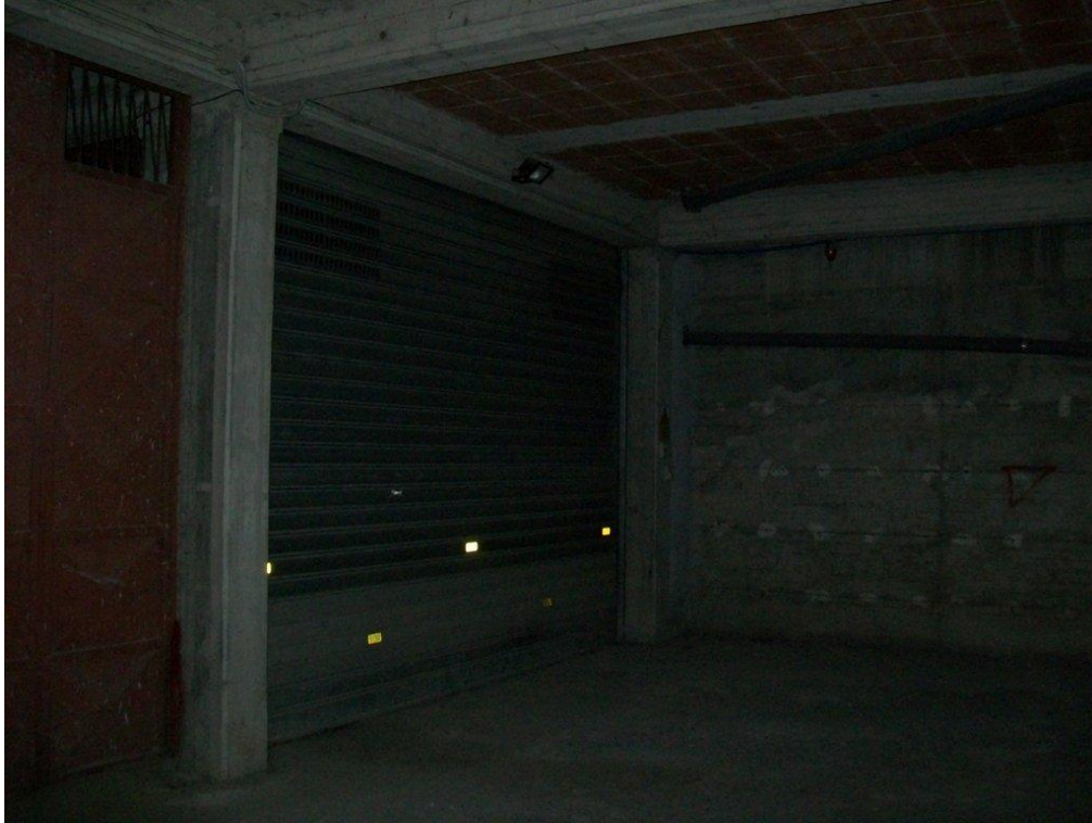
Foto n.4 Vista della saracinesca di ingresso al vano garage.
