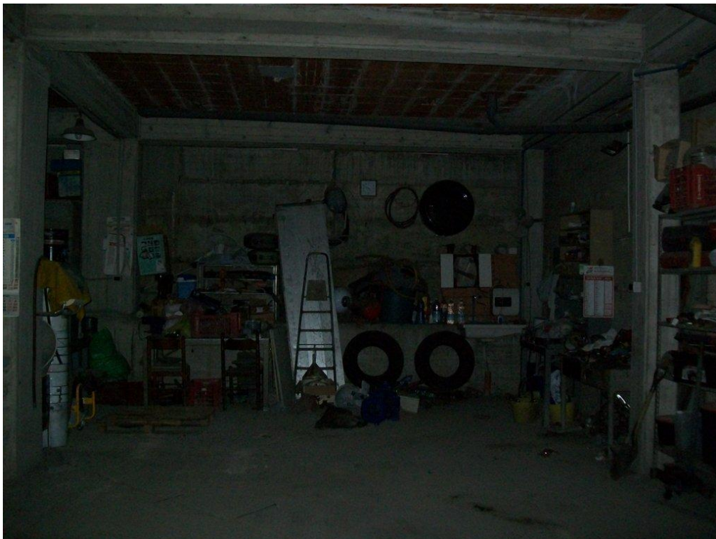
Foto n.5 Vista del vano garage.
