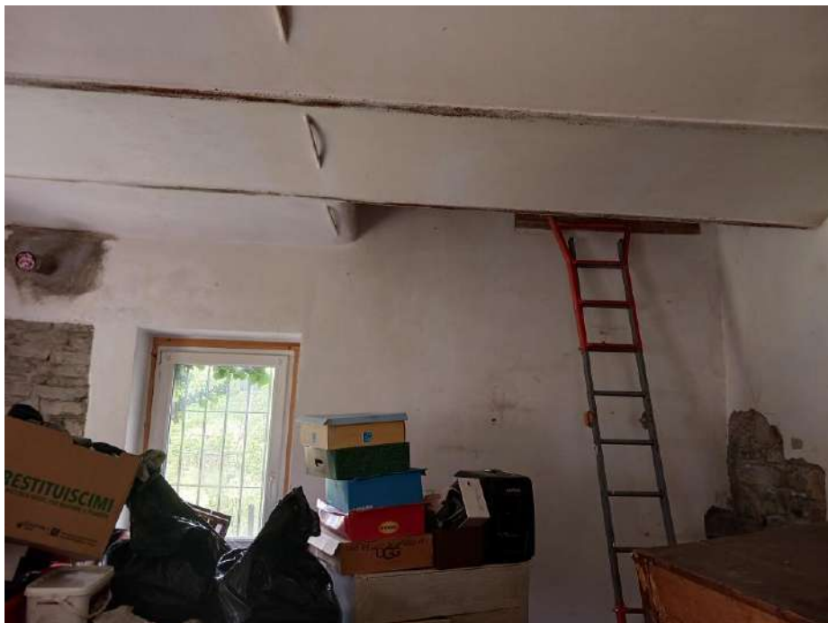
FORO DI ACCESSO AL PIANO PRIMO
