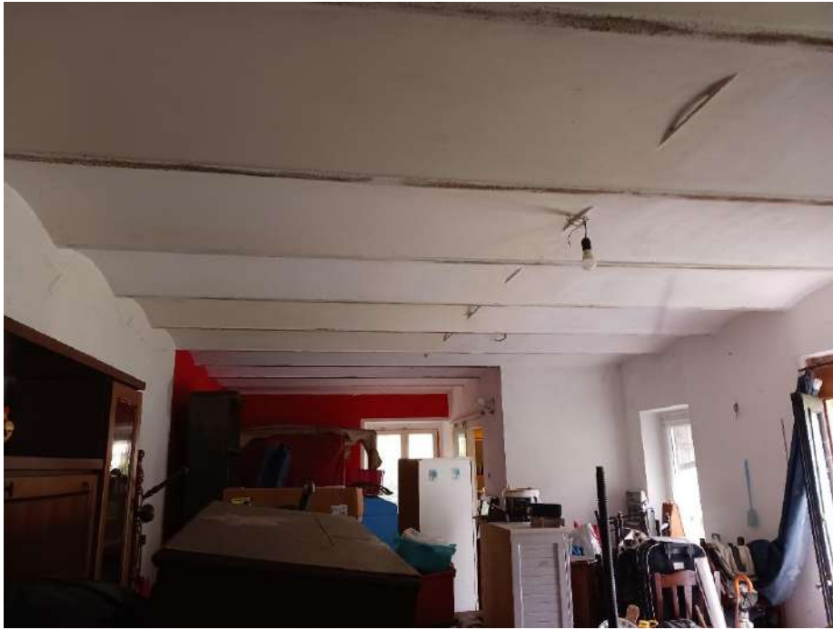
VISTA INTERNA DEL PIANO TERRENO LOCALE DEPOSITO
