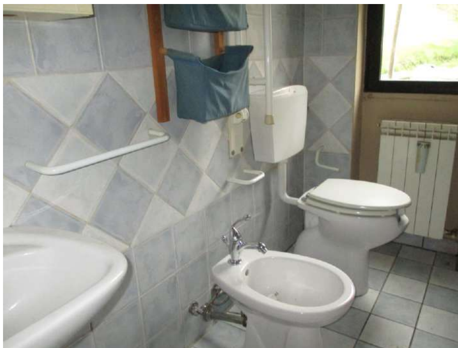
BAGNO AL PIANO PRIMO
