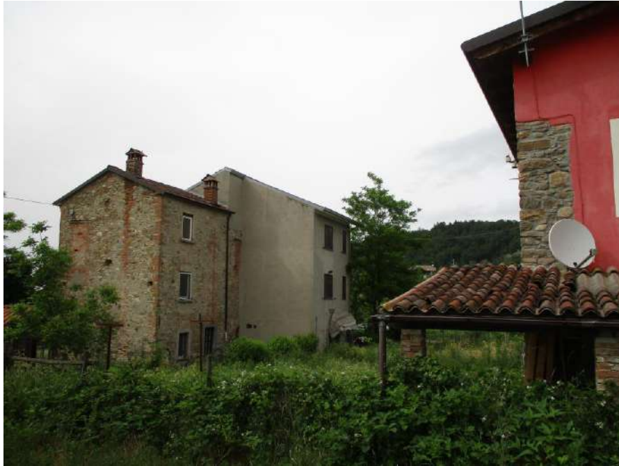
VISTA DEL FABBRICATO RESIDENZIALE E DEL RUSTICO-DEPOSITO
