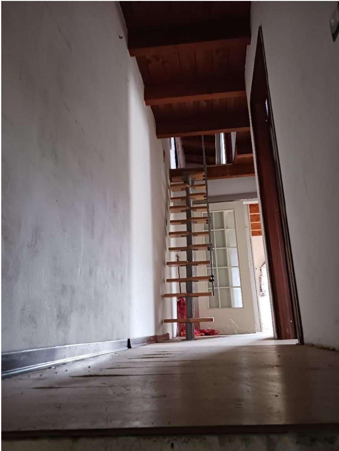
VISTA INTERNA DEL PIANO PRIMO E SOPPALCO LOCALE DEPOSITO
