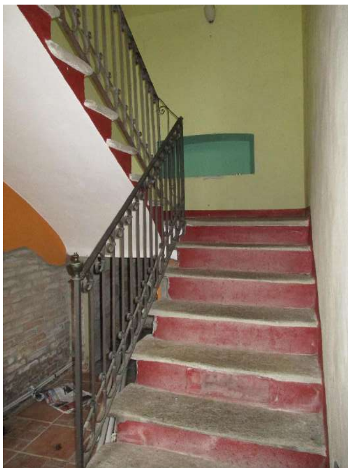
INGRESSO – VANO SCALA
