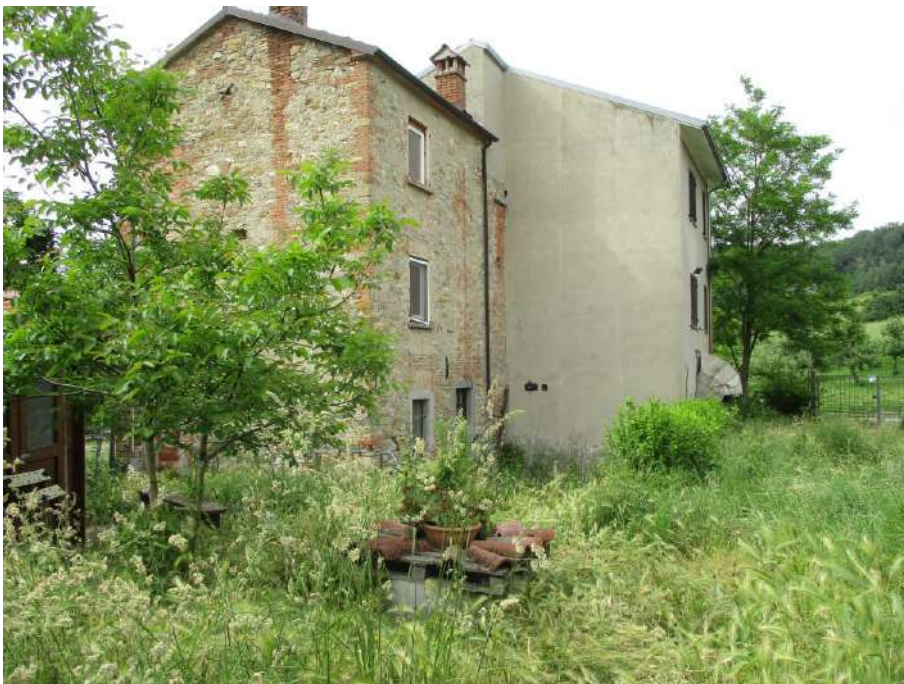
VISTA DAL TERRENO DI PERTINENZA (POZZO)
