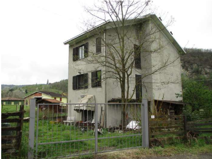
VISTA DELL'ACCESSO CARRAIO
