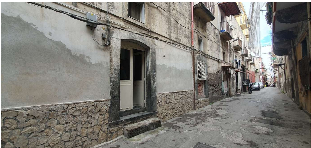
Fotografia 1 – Ingresso dalla via A. Costa.
