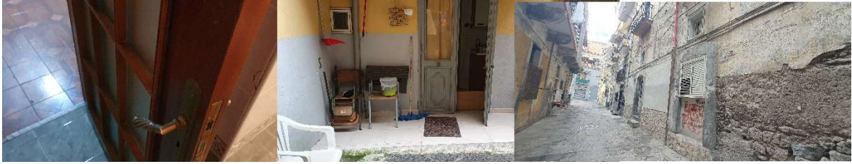
Fotografia 4 – Porte e infissi.
