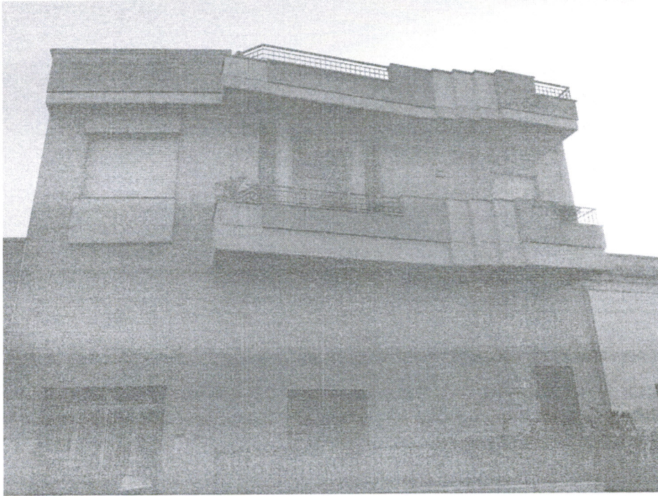
Prospetto su Piazza dei caduti
