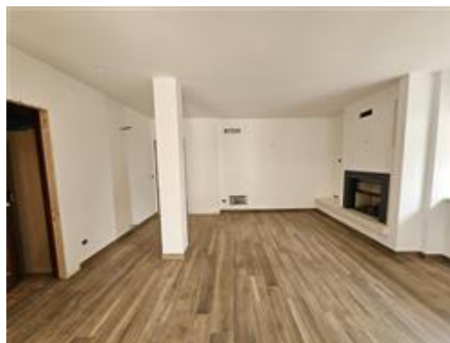
Appartamento in corso di realizzazione al piano terra
