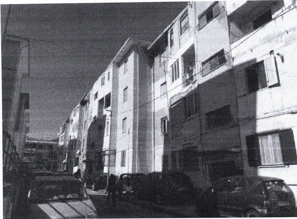
Via A. Duro Minissale, fabbricato oggetto di causa
