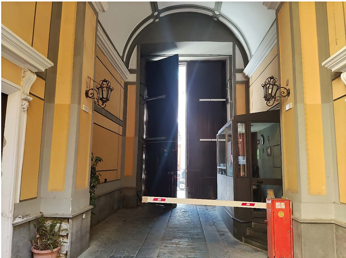
Foto n. 4 – Androne fabbricato (vista opposta)
