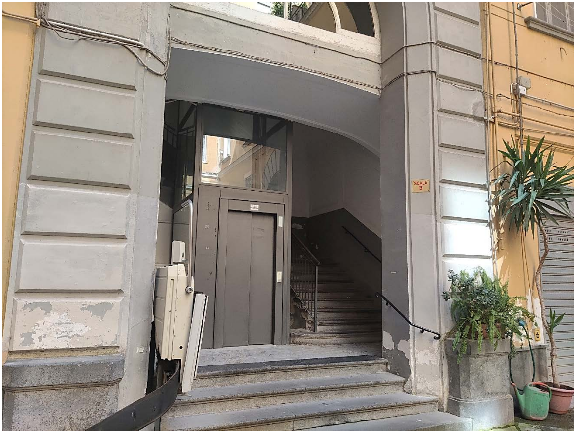
Foto n. 5 – Accesso scala B del fabbricato
