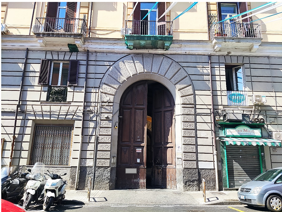
Foto n. 1 – Portone d'ingresso fabbricato C.so V. Emanuele n. 211
