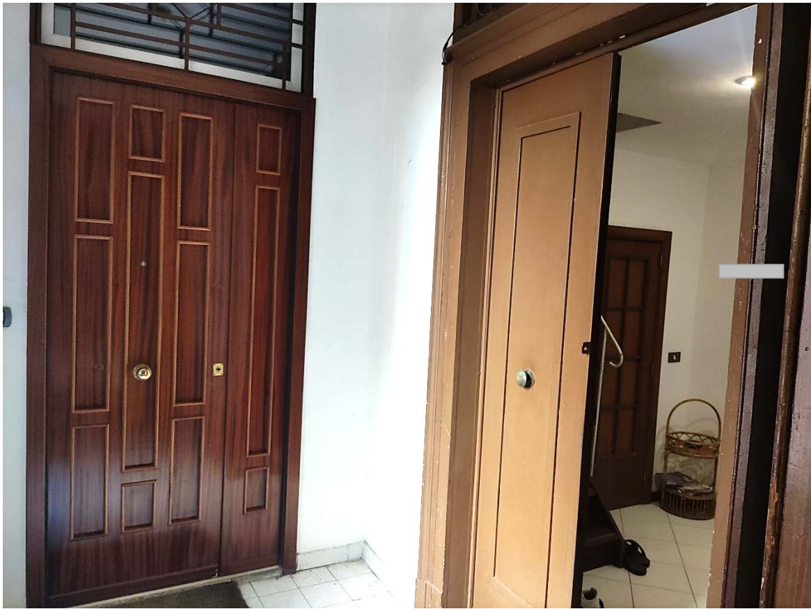
Foto n. 7 – Porta d'ingresso appartamento da saletta comune con altra u.i.
