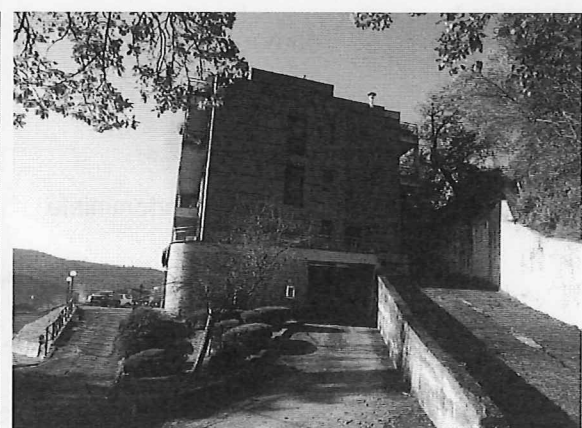
Foto 3 = ingresso corsia garages - lato NE
