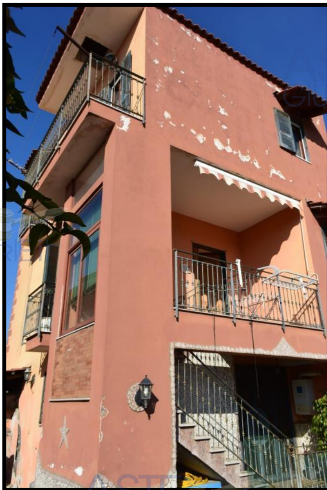
Figura 5 – vista edificio lato sud
