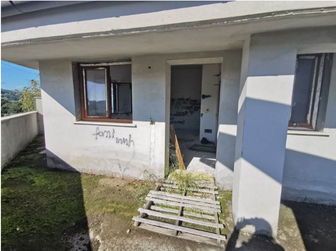
Immobile sito in Orte distinto al catasto al fg 27 part.IIa 953, piano primo, Appartamento 2:
