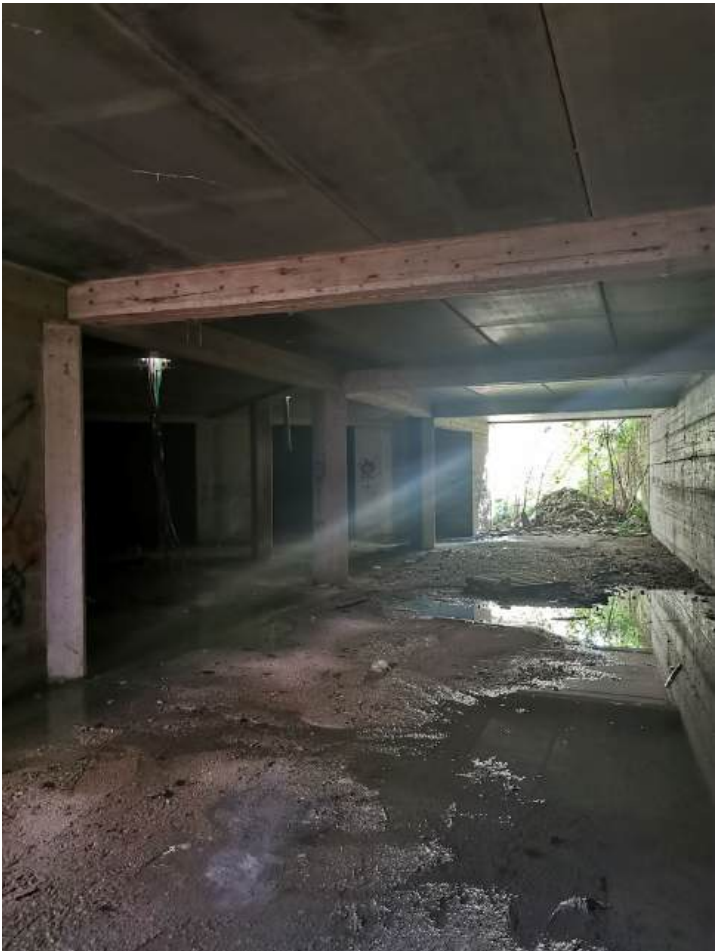
Immobile sito in Orte distinto al catasto al fg 27 part.IIa 953, piano interrato:
