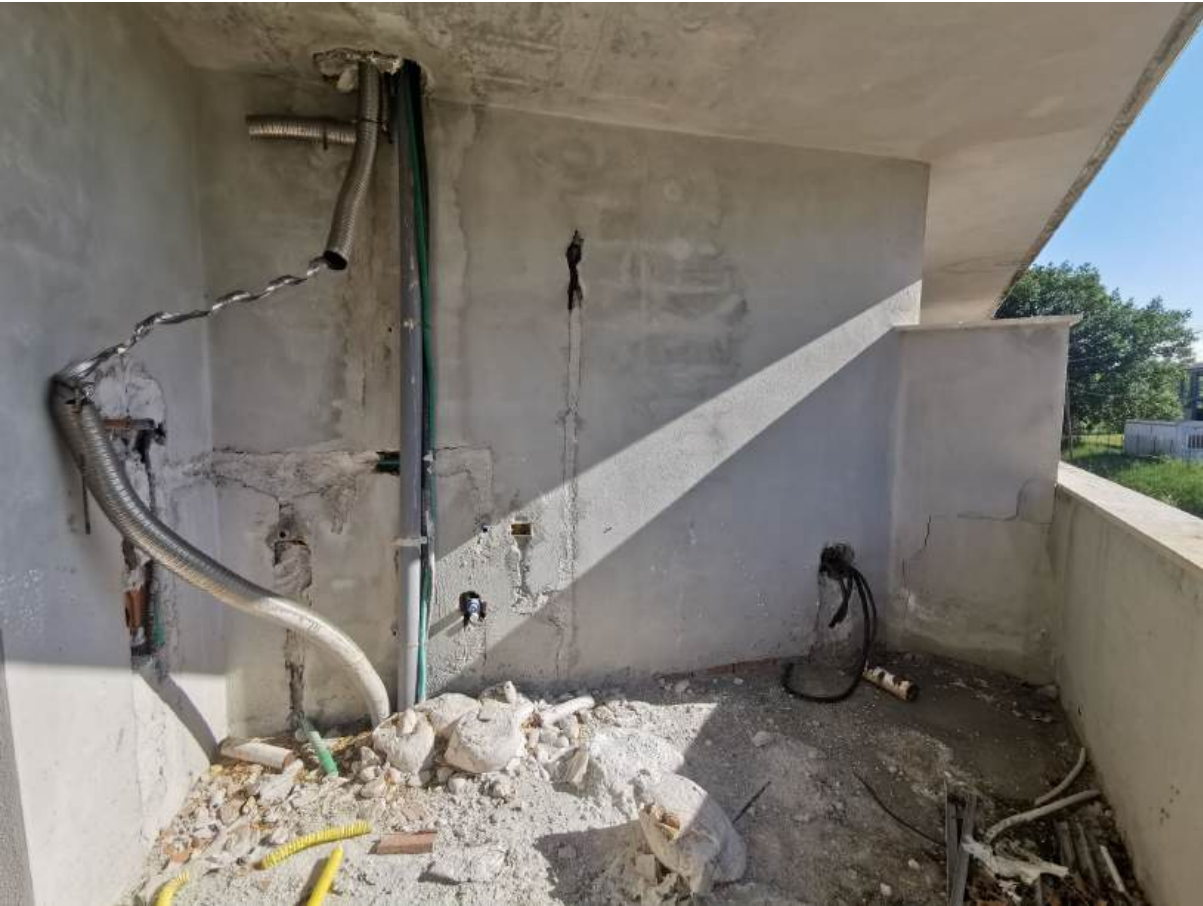
Immobile sito in Orte distinto al catasto al fg 27 part.IIa 953, piano primo, Appartamento 1:
