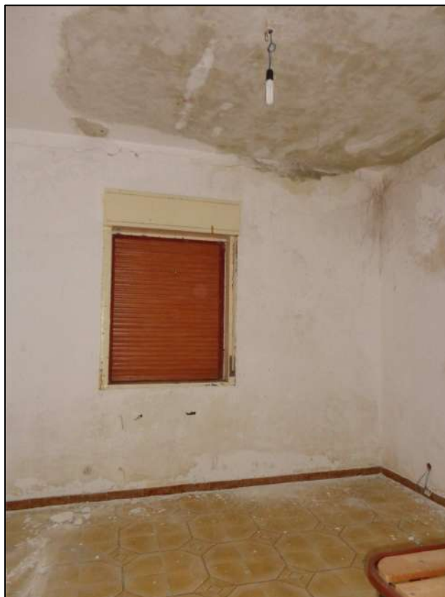
Camera nord con apertura esterna.
