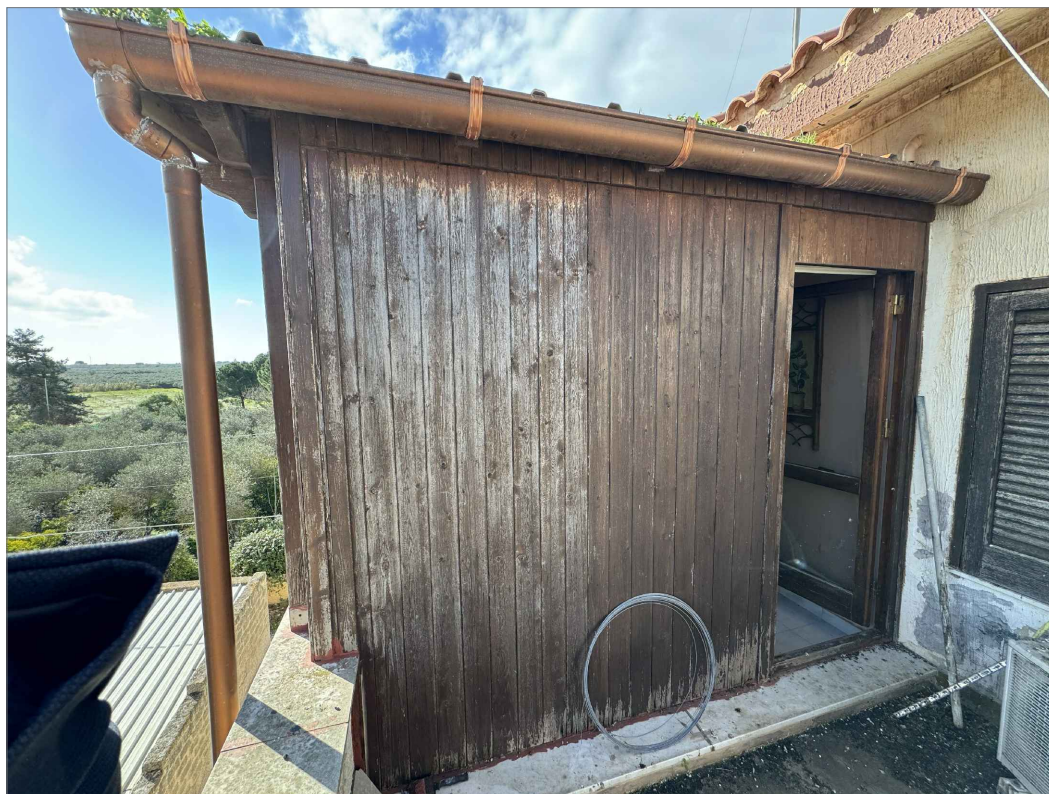
Foto N.10 - terrazzo piano secondo
