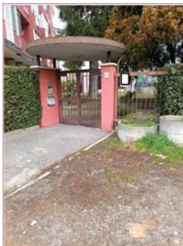
Ingresso Pedonale Condominio
