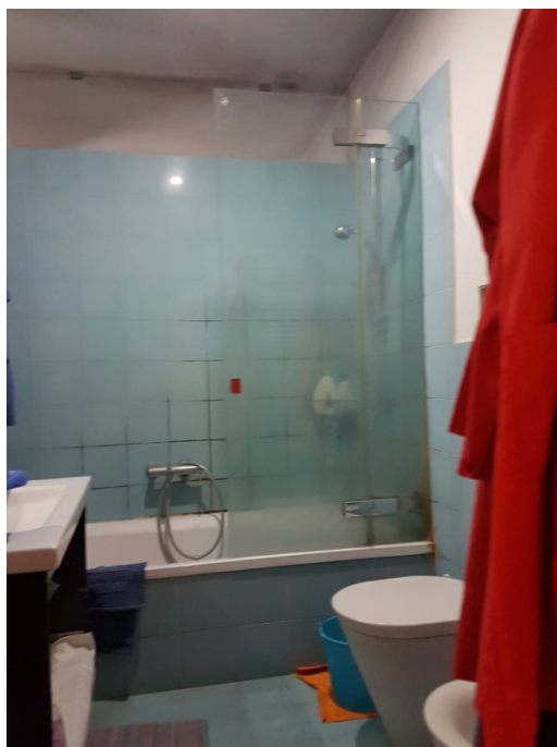
Foto 20 – Piano 1° - Servizio igienico comune
