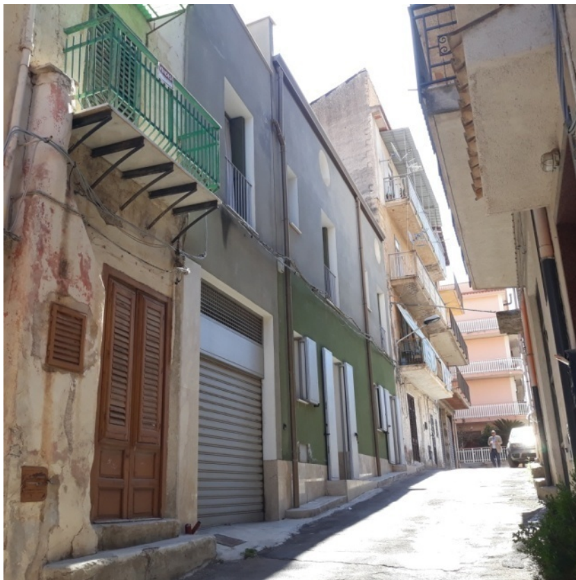
Foto 6 – Accesso da Via Amore- saracinesca dell’ambiente adibito a deposito /garage
