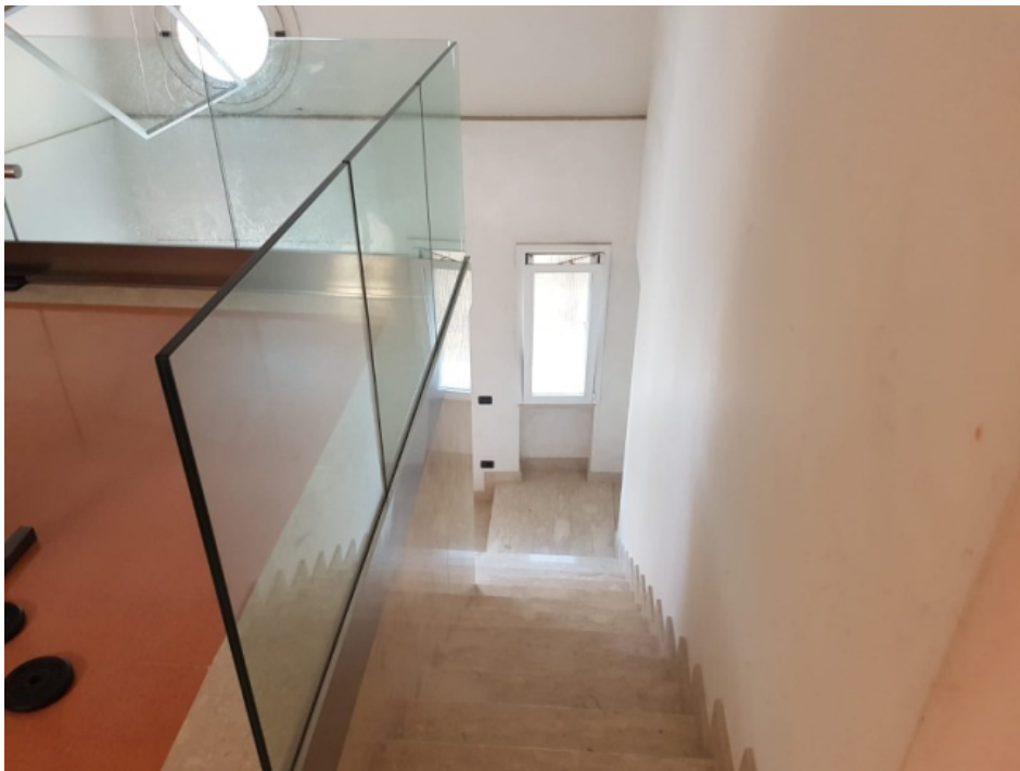
Foto 24– Scala di collegamento con il Piano 2°
