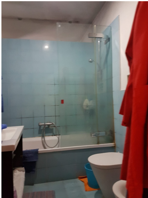
Foto 20 – Piano 1° - Servizio igienico comune
