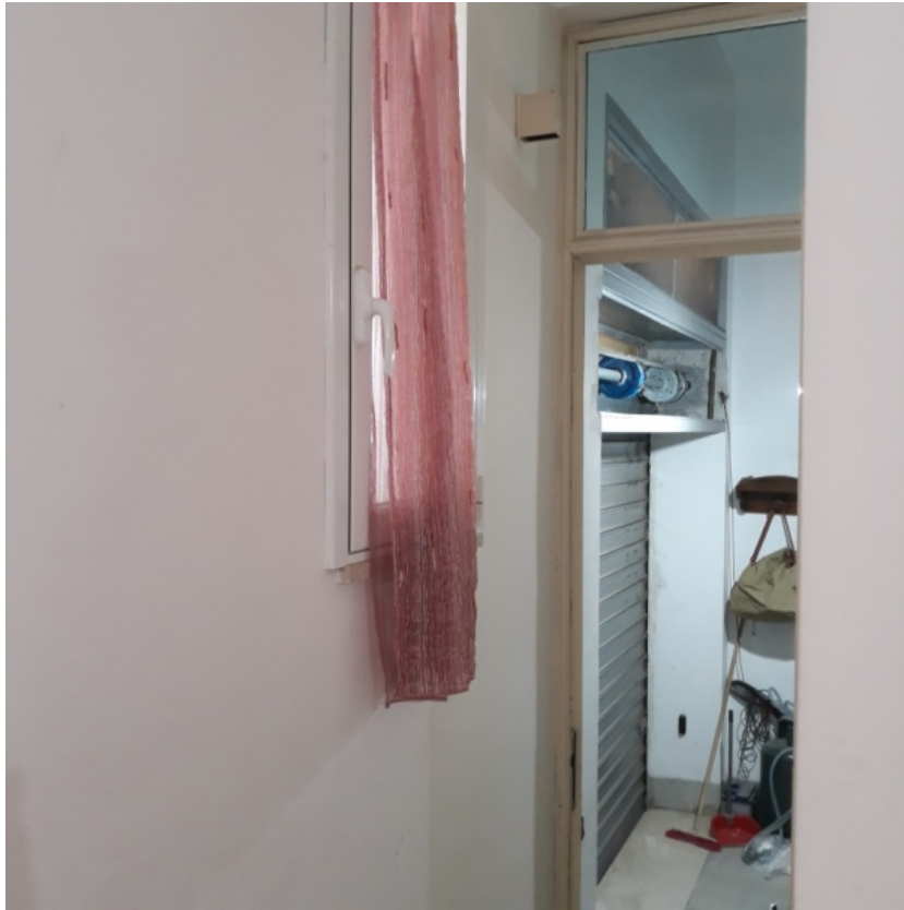
Foto 7 – Collegamento interno tra il soggiorno e il locale deposito / garage
