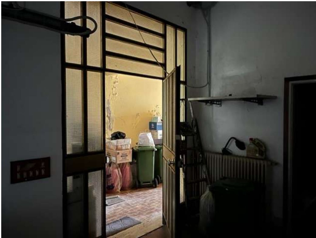
Fotografia 19 – Vista della porta collegamento altro laboratorio
