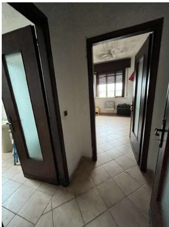
Fotografia 13- Vista del locale bagno
