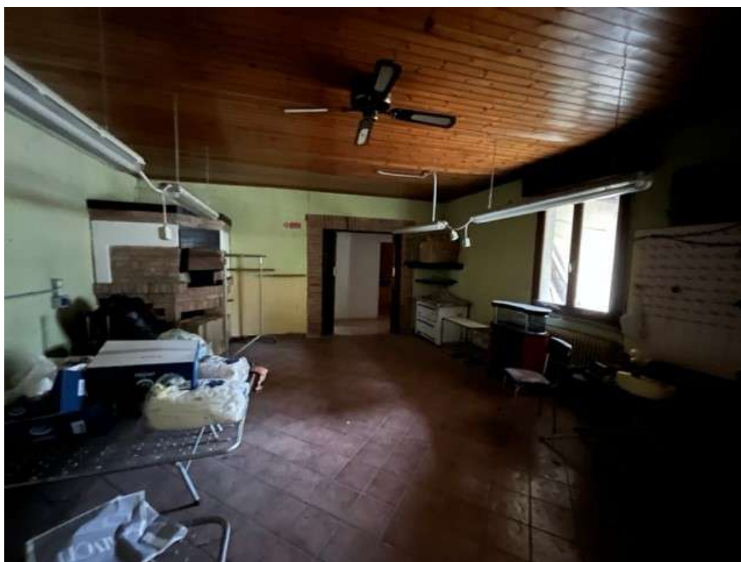
Fotografia 26 – Vista di altro locale laboratorio
