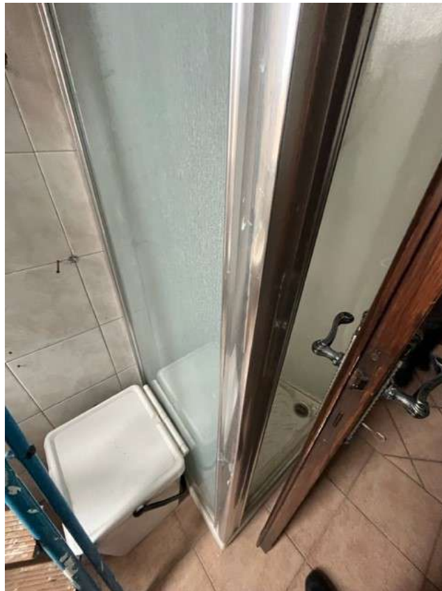
Fotografia 12– Vista del locale bagno
