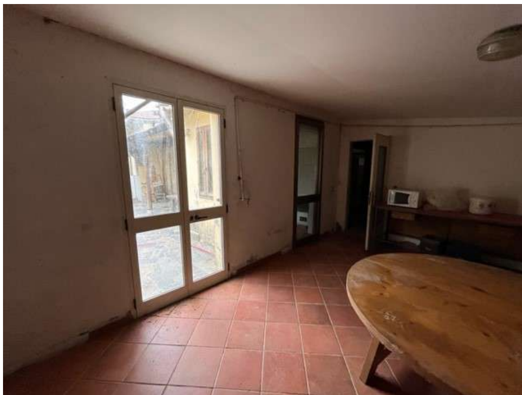
Fotografia 32 – Vista di locale laboratorio
