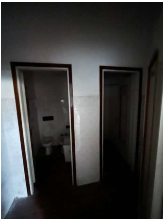
Fotografia 25 – Vista del locale bagno
