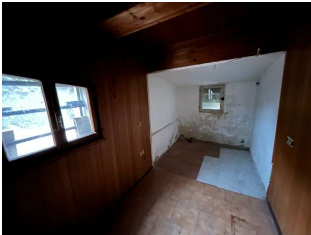
Fotografia 29 – Vista del locale ripostiglio
