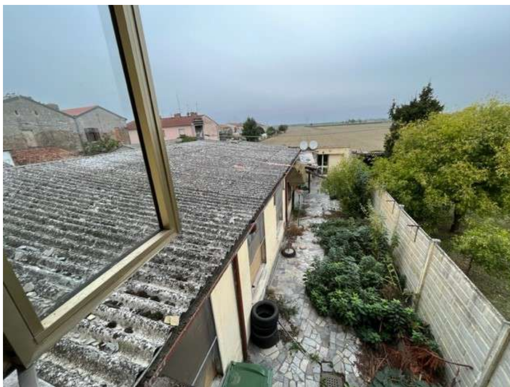
Fotografia 36 – Vista della copertura in Eternit del laboratorio
