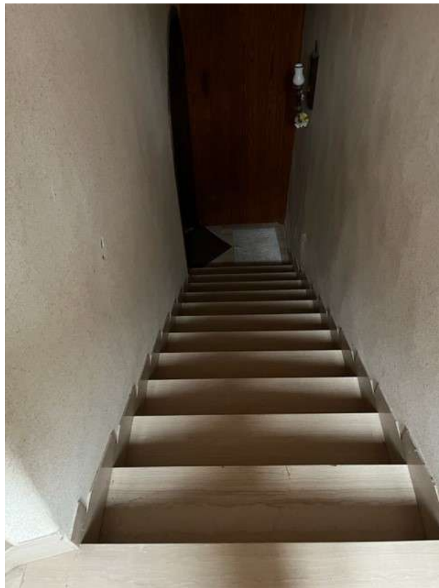
Fotografia 8 - Vista del vano scale comune
