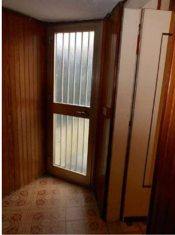
Fotografia 7- Vista della porta sul cortile comune
