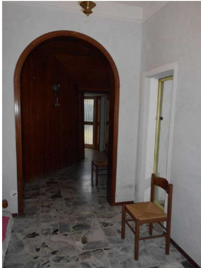
Fotografia 5 – Vista locale ingresso comune
