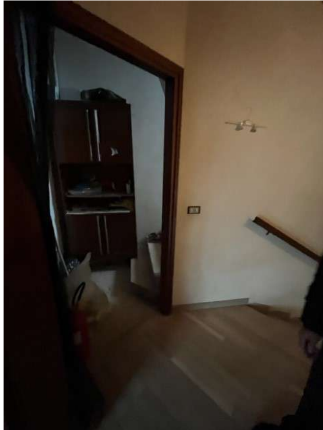
Fotografia 8 – Vista della scala che porta al piano secondo dal pianerottolo piano primo
