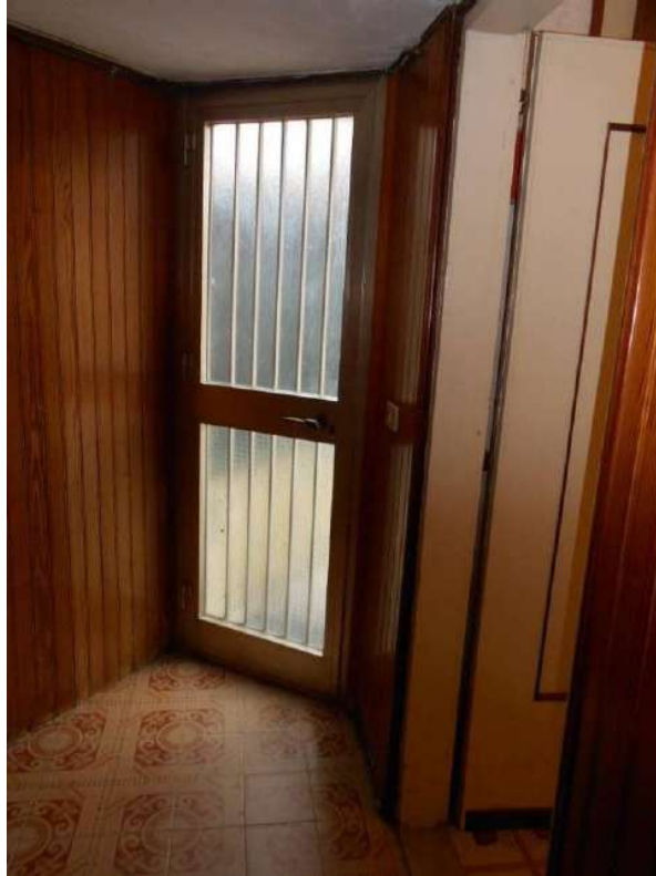
Fotografia 7- Vista della porta sul cortile comune
