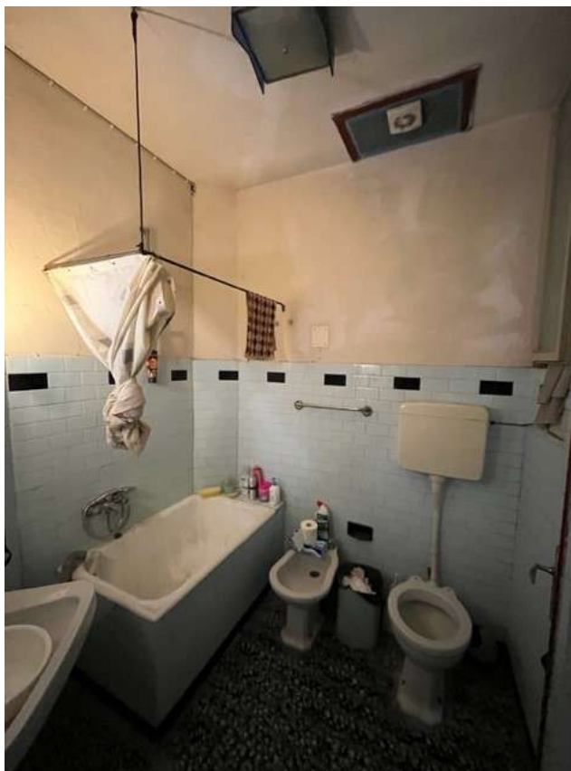
Fotografia 13- Vista del locale bagno
