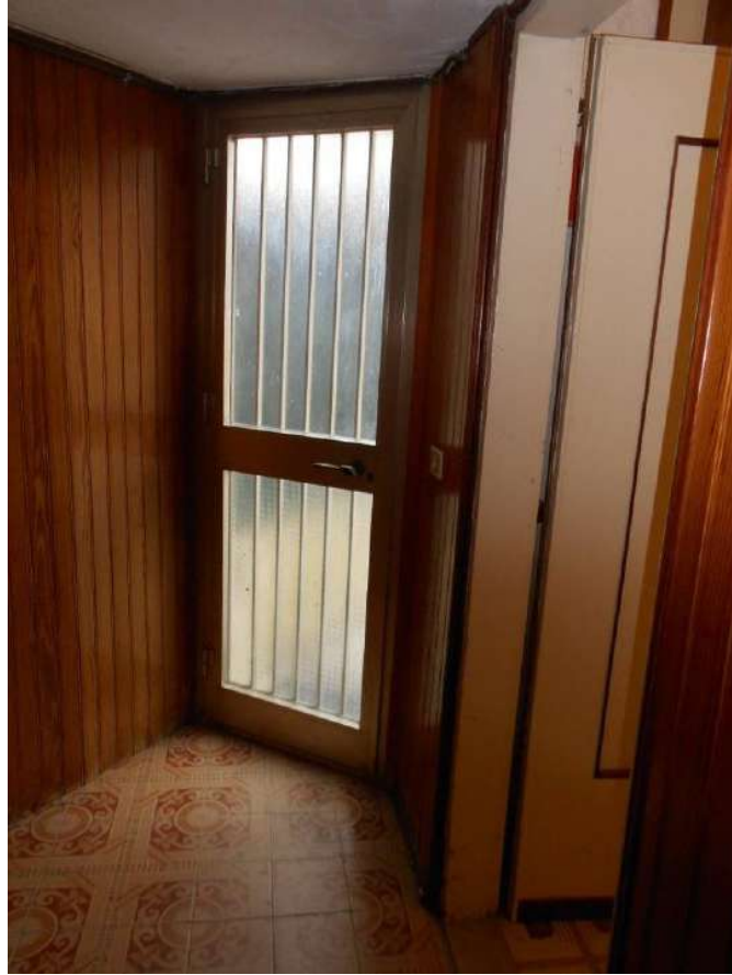
Fotografia 7- Vista della porta di ingresso unità e porta sul cortile
