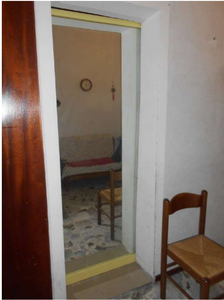
Fotografia 15 – Vista porta esistente di accesso al locale letto dall'ingresso
