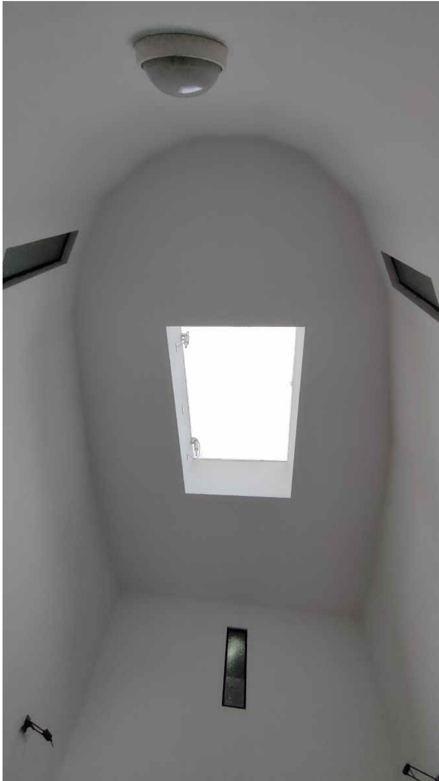
foto n.83- Soffitto con lucernaio Locale n.22 - sala riunioni.
