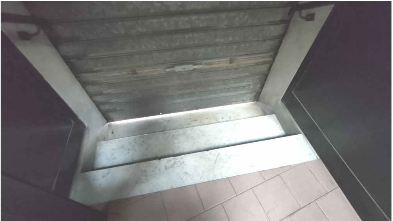
foto n. 23- Dettaglio scalini di un accesso e di una saracinesca
