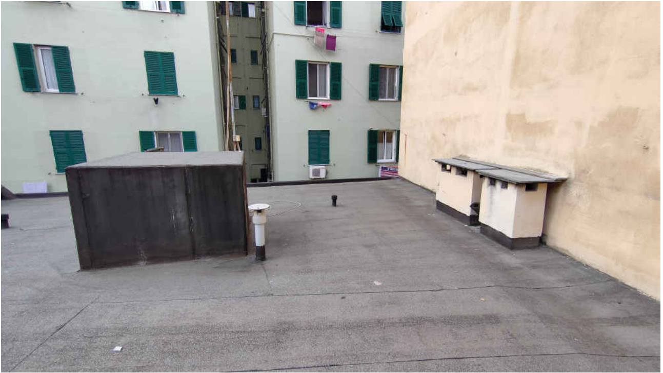
foto n.132 – Terrazzo di copertura
