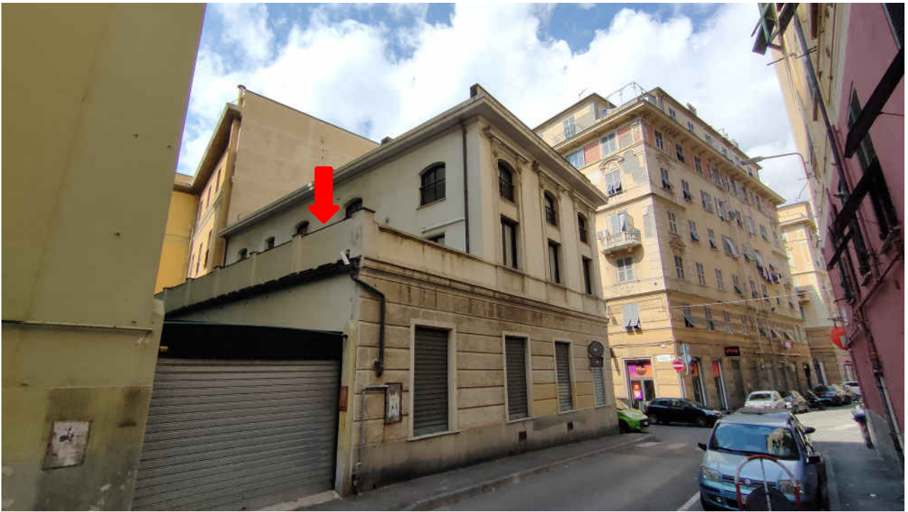
foto n. 2- Facciata edificio su via Malfettani. In evidenza il terrazzo dell'immobile
