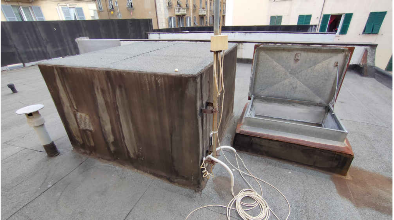
foto n.126- A destra botola di arrivo scala retrattile , a sinistra vano corsa ascensore (ascensore non presente)
