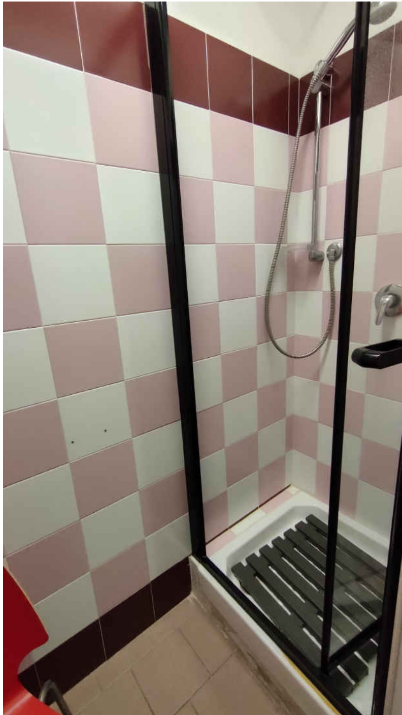
foto n.99- Locale 28- vano con doccia.
