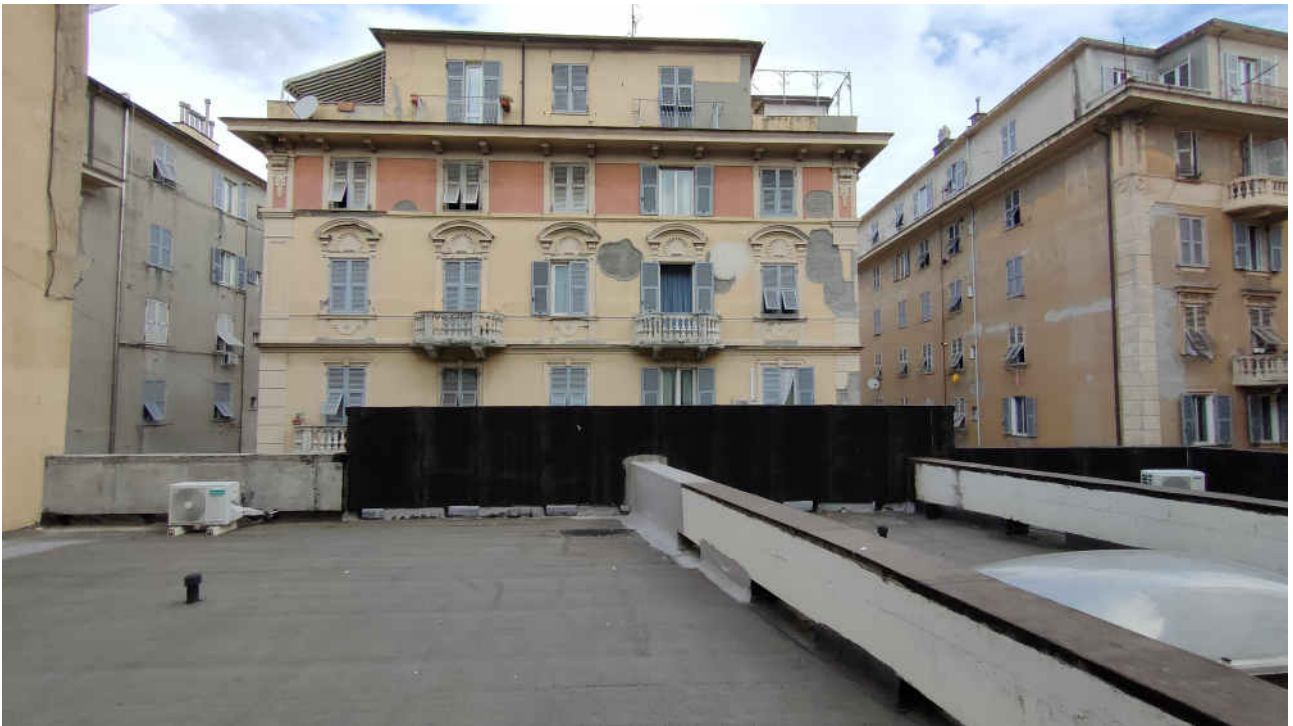
foto n.129 – Terrazzo di copertura
