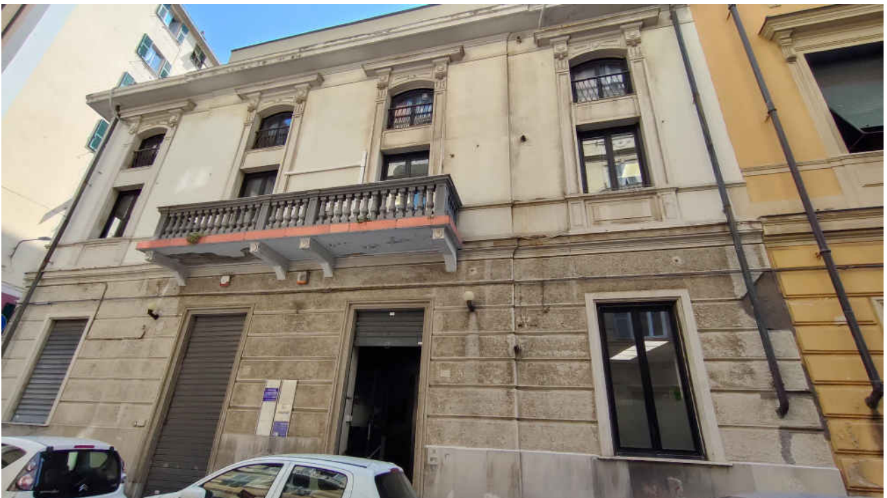
foto n. 3- Facciata edificio su via Dattilo.
