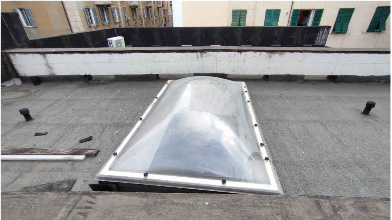
foto n.130 – Lucernaio sala riunioni
