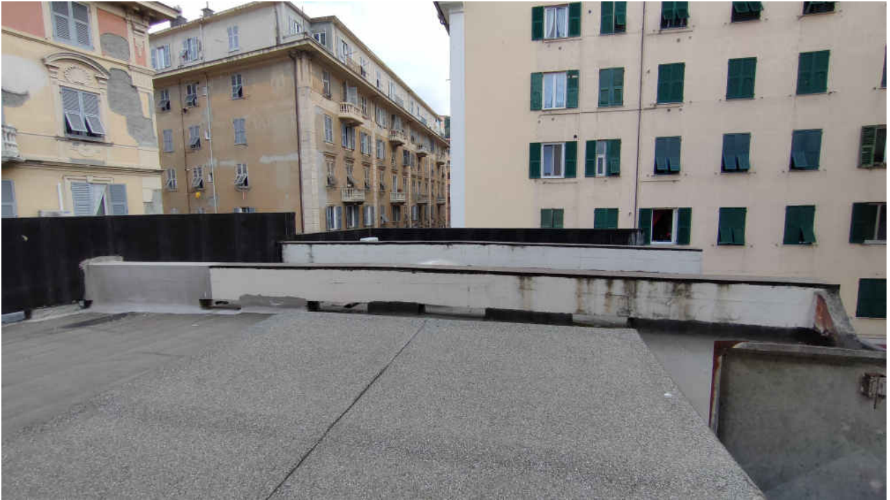
foto n.128 – Terrazzo di copertura
