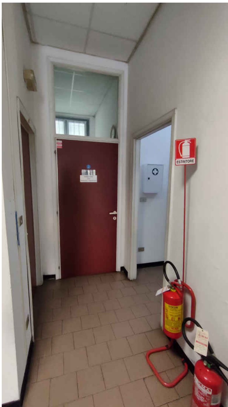
foto n. 20- Vano d'ingresso. Sulla sinistra porta di accesso al vano scala di collegamento con il piano fondi.
