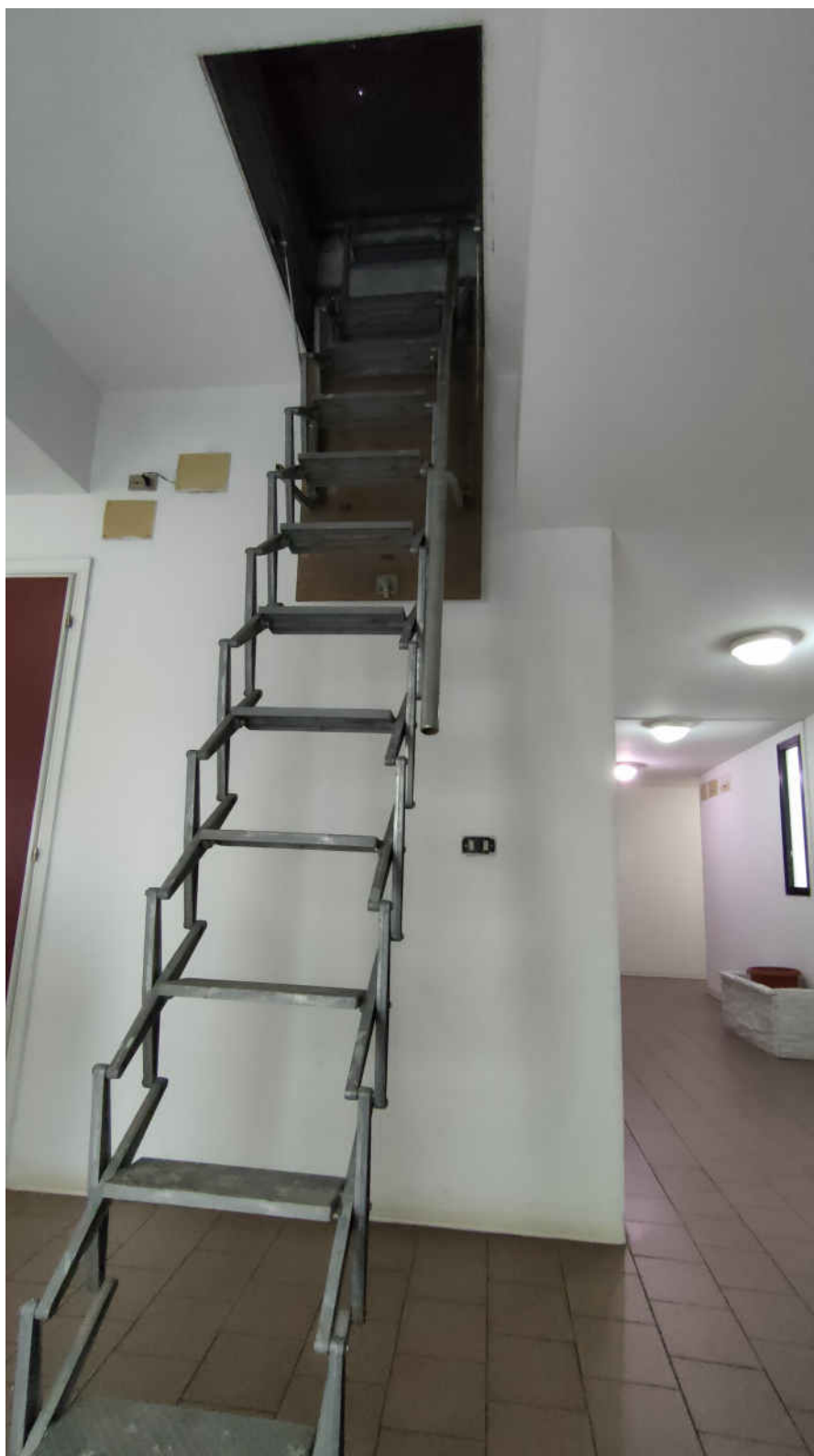
foto n.125- Scala retrattile per accedere alla copertura (locale 27)
