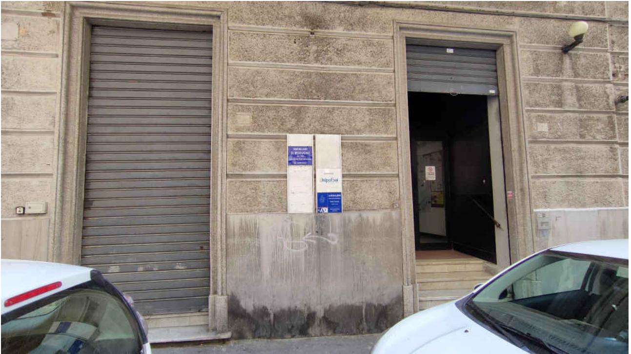
foto n. 11- Dettaglio accessi civi 7 e 9 rossi su via Dattilo .
