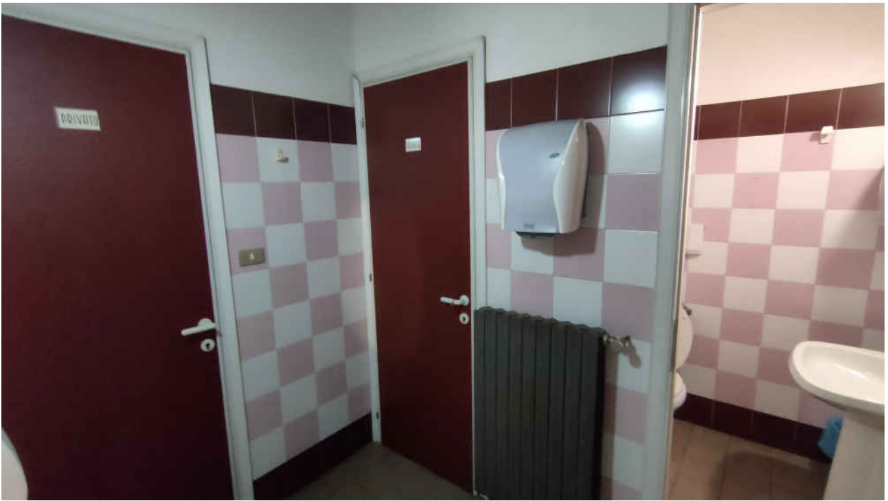
foto n.68- Locale servizi igienici n. 17 sulla planimetria di rilievo.
