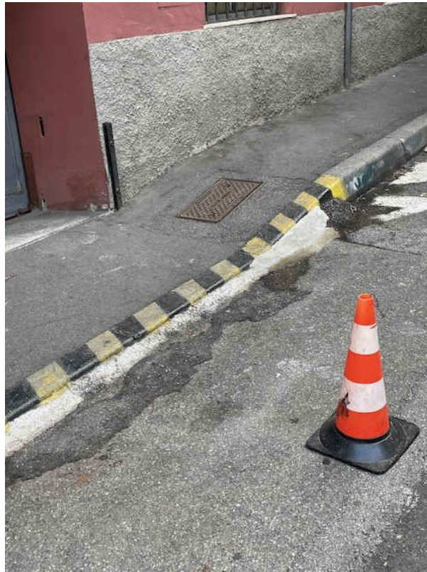
foto n. 14- Tombino su via Malfettani con contatore acqua
