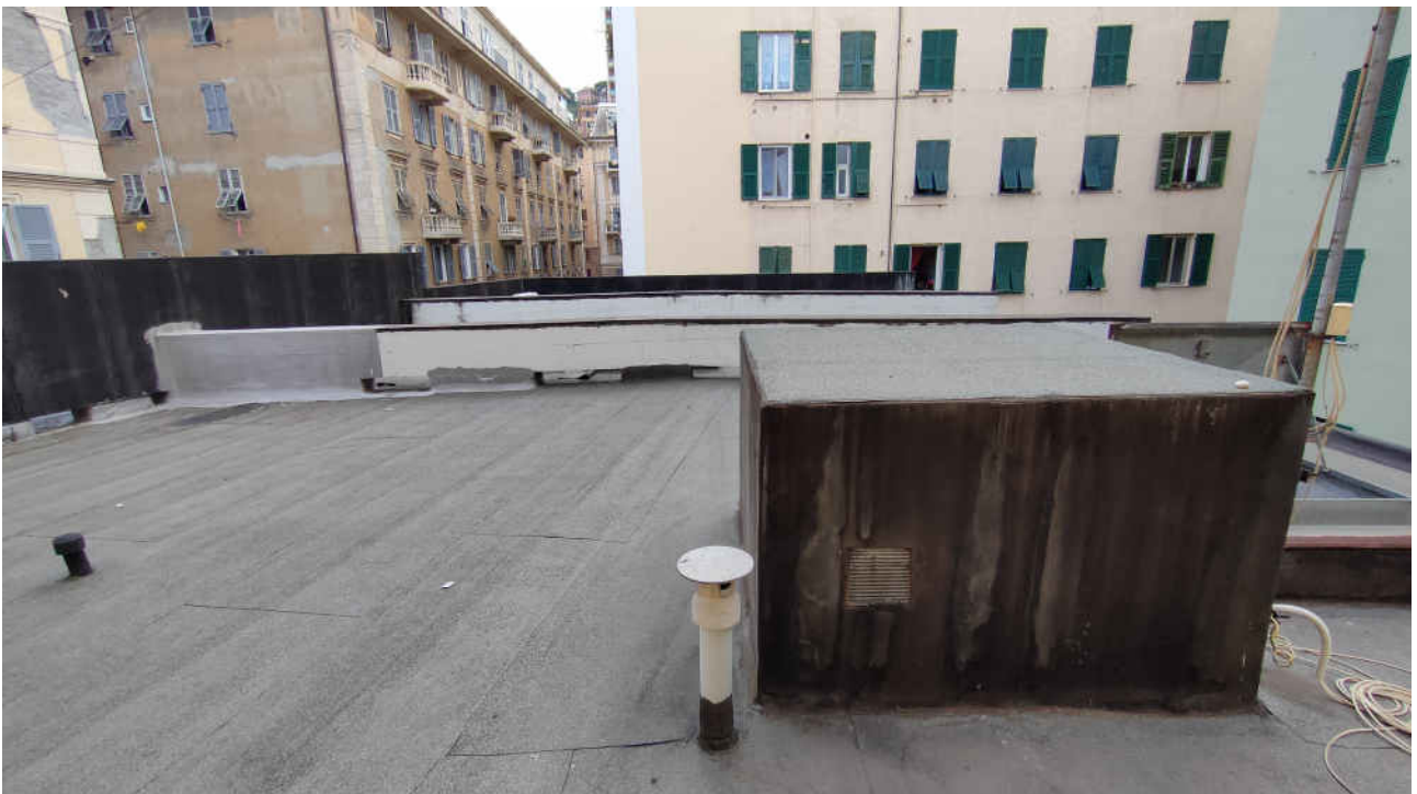
foto n.127 – Terrazzo di copertura
