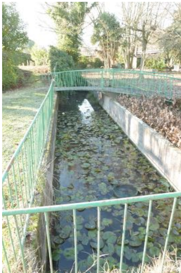
FOTO 28 - Particolare delle vasche.
