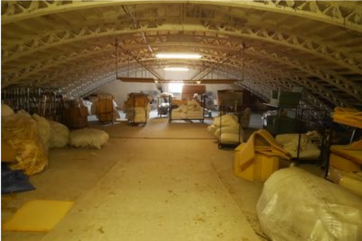
FOTO 25 - Corpo principale. Piano terzo. Il magazzino sotto la copertura curva.
