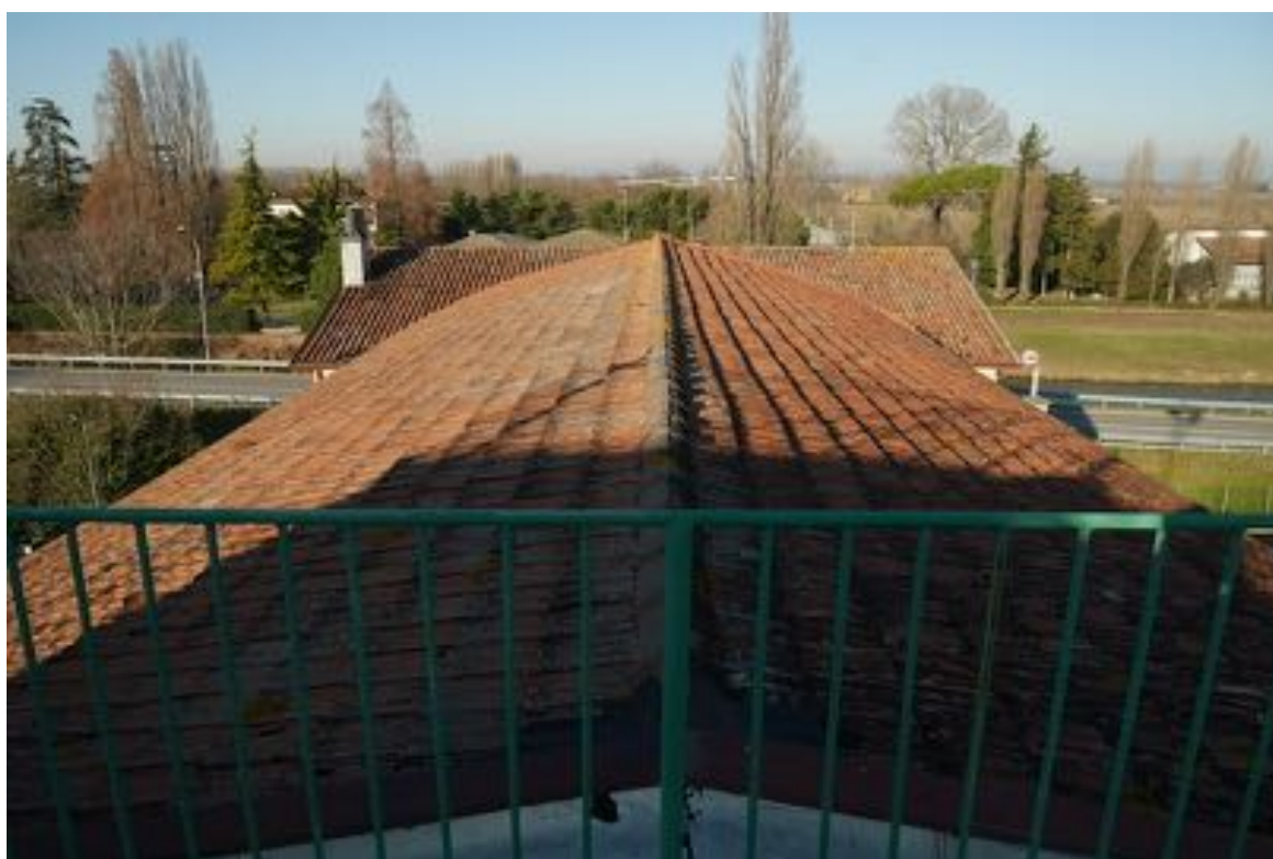
FOTO 8 - Le coperture curve e a falde del corpo principale viste dalla copertura piana dello stesso corpo.
