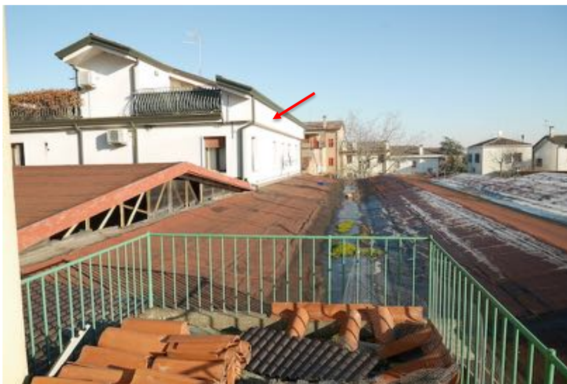
FOTO 18 - Corpo principale. Piano primo. Vista da una delle terrazze della copertura del corpo capannone e di una delle proprietà di terzi (con freccia rossa).
