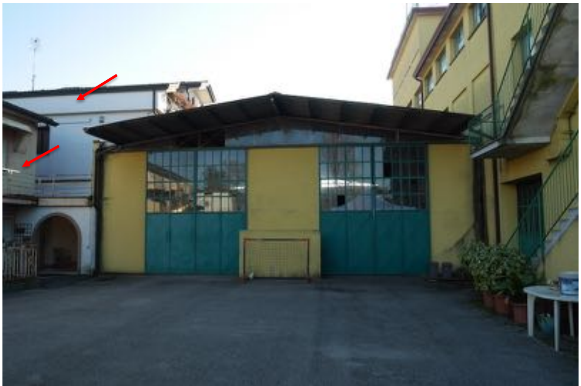
FOTO 6 - Il corpo capannone di un piano fuori terra, ripreso dallo scoperto comune. Sulla sinistra, con frecce rosse, i fabbricati di proprietà di terzi.
