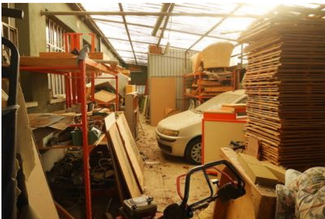
FOTO 17 - Corpo principale. Piano terra. Uno dei locali realizzati senza autorizzazione, in aderenza al lato sud, accessibili sia dall'interno del corpo principale che dallo scoperto esclusivo.
