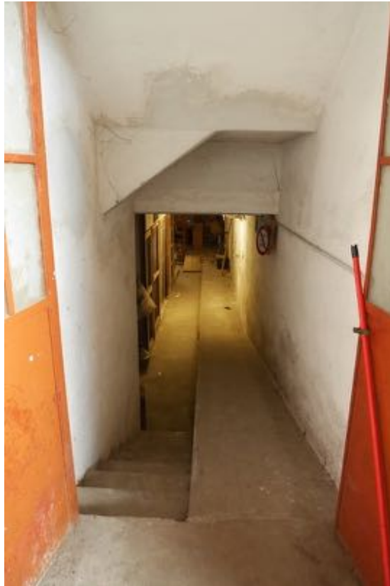
FOTO 13 - Il locale seminterrato accessibile dal corpo capannone. Detto locale si trova sotto la proprietà di terzi.
