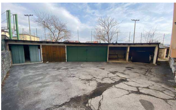
Vista esterna da sud autorimesse
