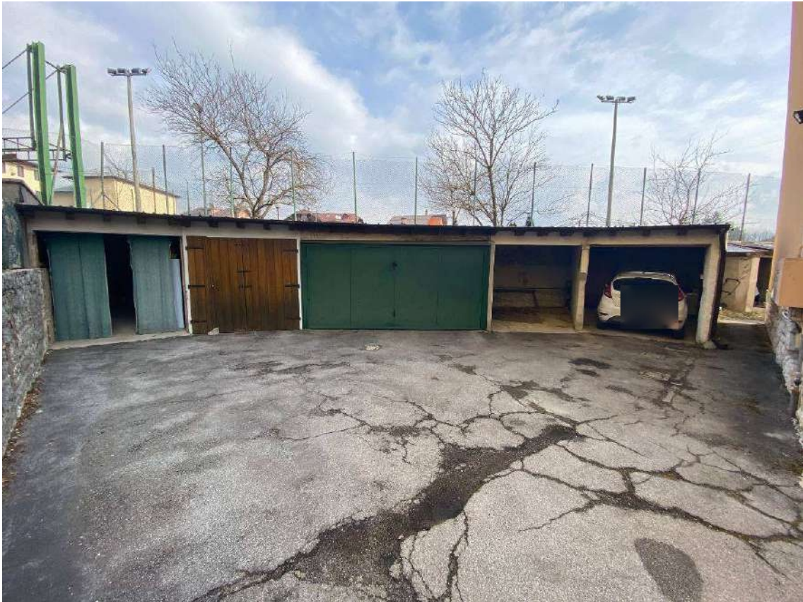
VISTA ESTERNA DA SUD AUTORIMESSE
