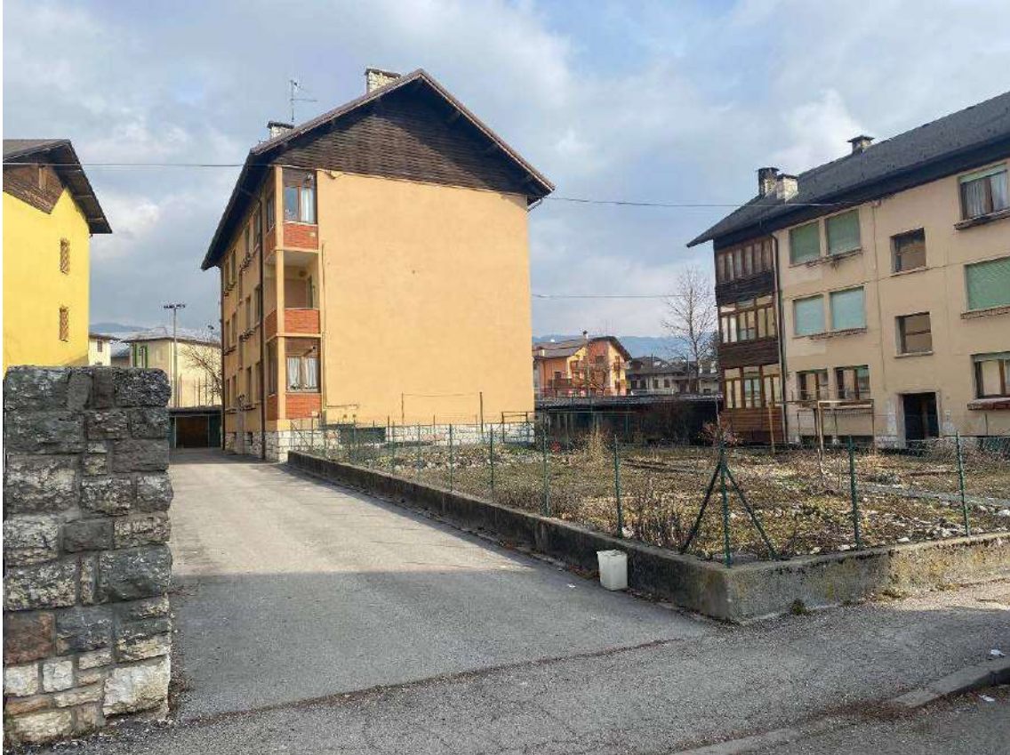
VISTA ESTERNA DA SUD
