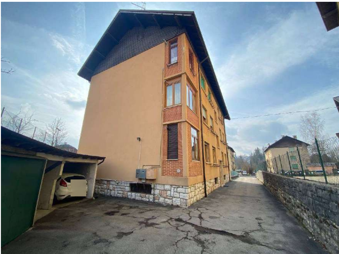
VISTA ESTERNA DA NORD-OVEST
