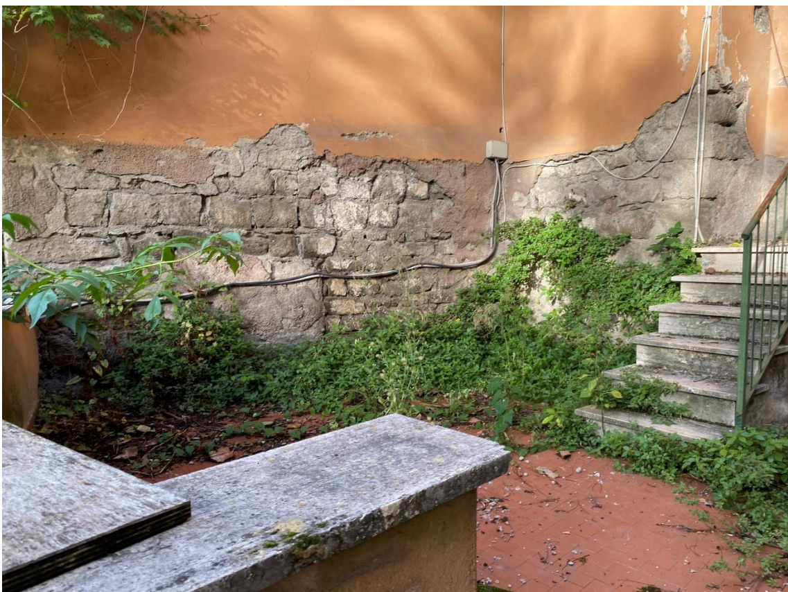
Foto 38 _ Vista esterna_terrazzo (particella 105)
