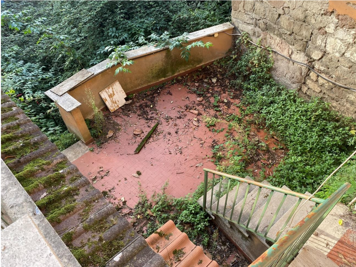
Foto 37 _ Vista esterna_terrazzo (particella 105)
