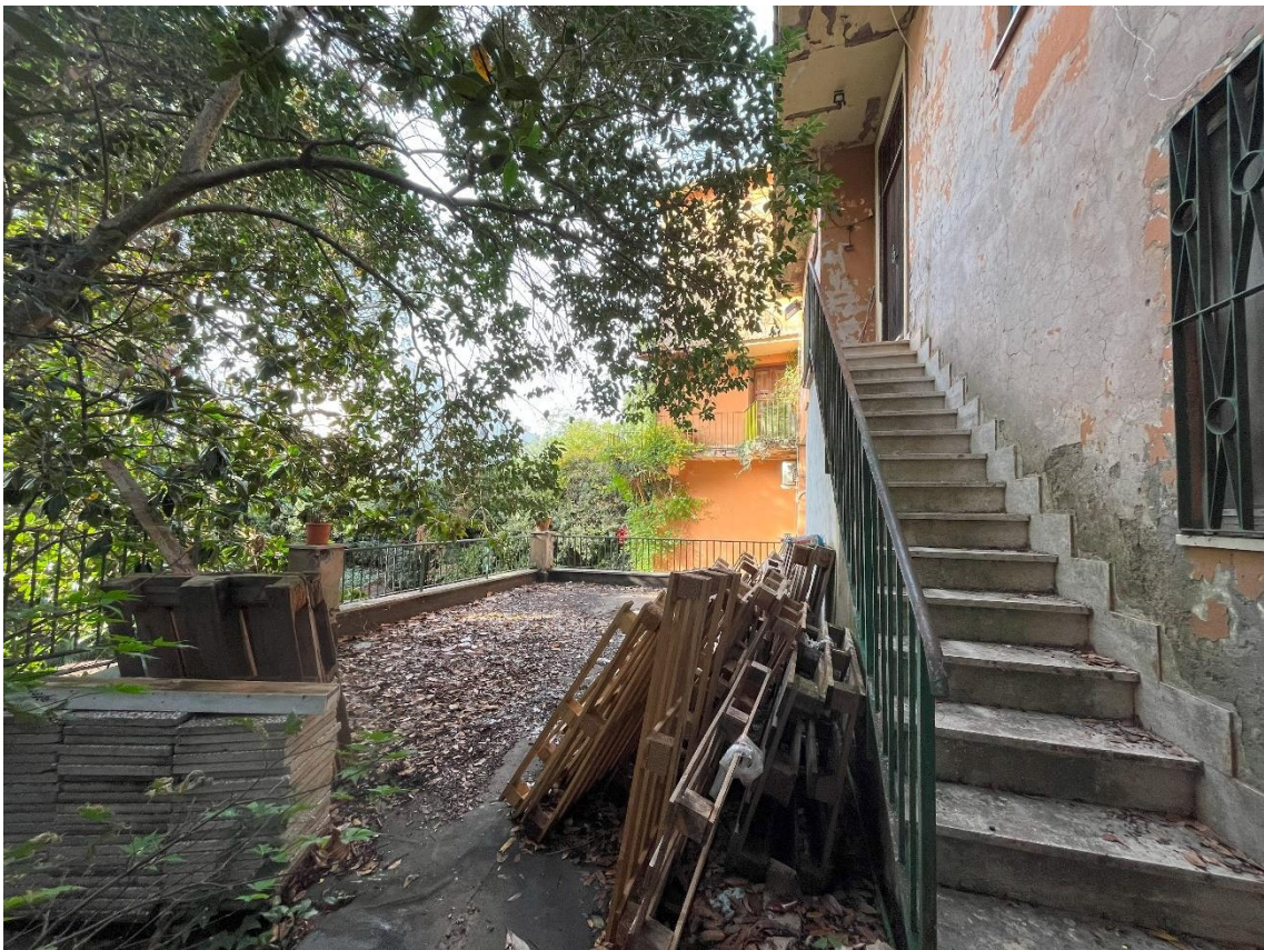
Foto 26 _ Vista esterna_scala di accesso al Sub 502
