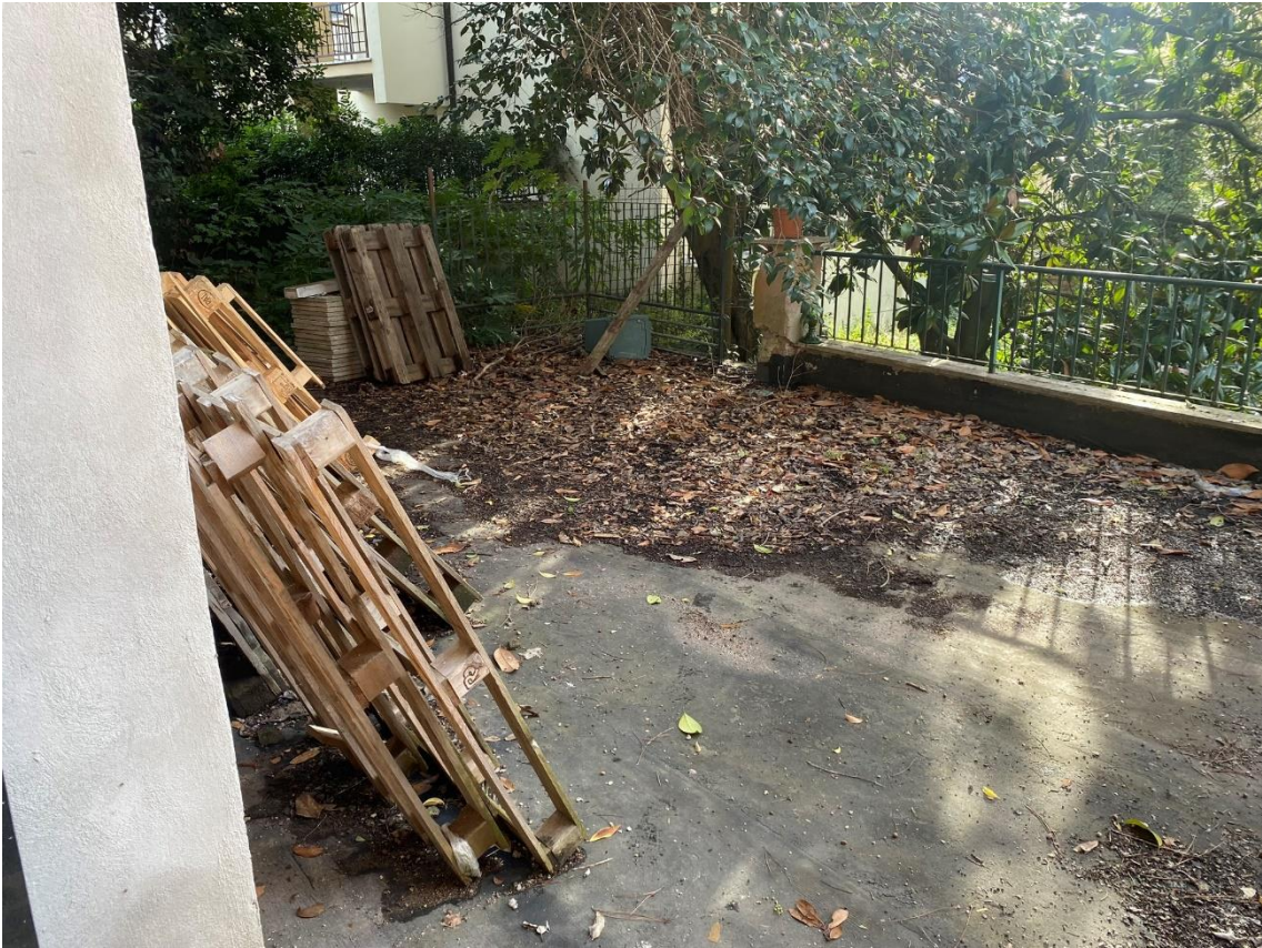
Foto 35 _ Vista esterna_terrazzo (particella 105)
