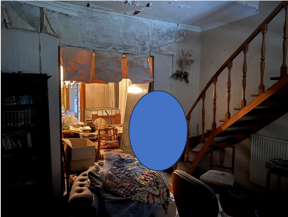
Foto 19 _ Vista interna_scala di collegamento tra i subalterni 502 e 503
