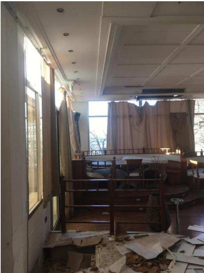
PARTICOLARE INTERNO (DEMOLIZIONE PAVIMENTO PER VERIFICA PERDITA TUBAZIONI)
