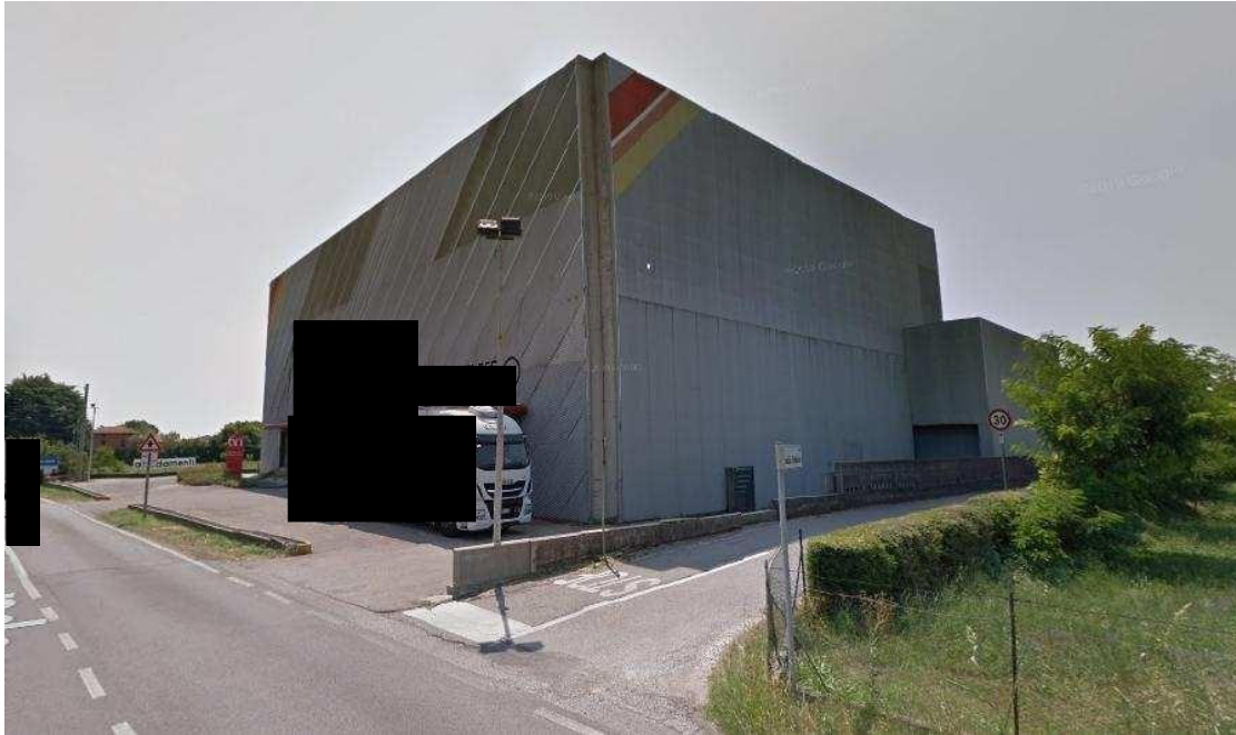
COMPLESSO COMMERCIALE DA VIA EUROPA
