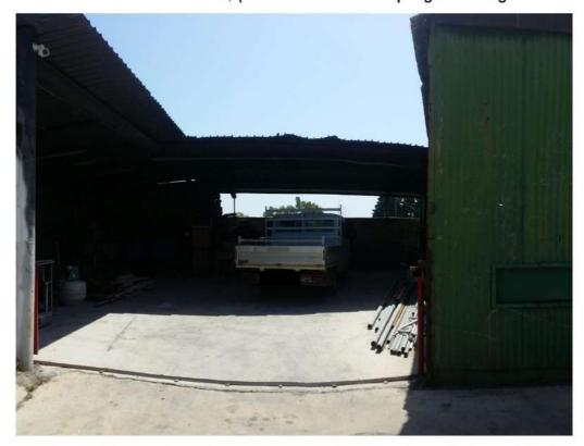
Corpo F : realizzato in aderenza all'angolo con i confini nord ed ovest, presenta una struttura portante in muratura, il tetto con pannelli modulari di termo copertura ed all'interno rifinito al civile con
