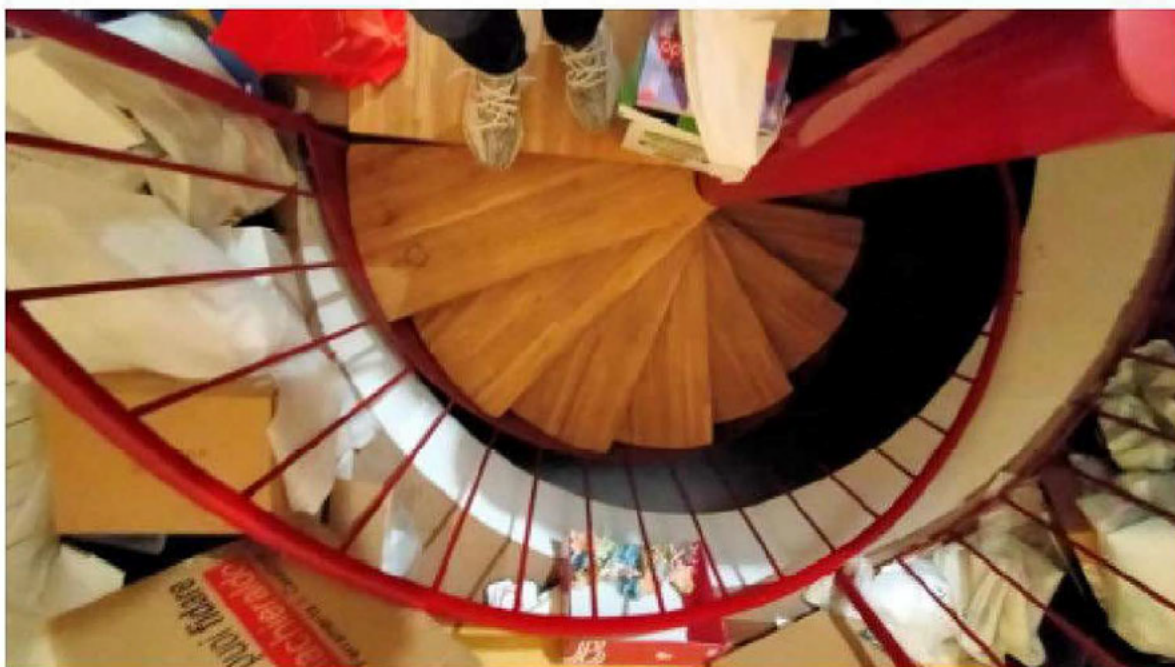
FOTO 9: Vista scala interna a collegamento p.t e S1
