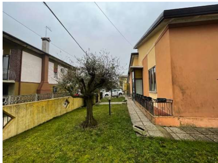
Prospetto Sud-Est dell'edificio (casa singola con autorimessa e area scoperta)
