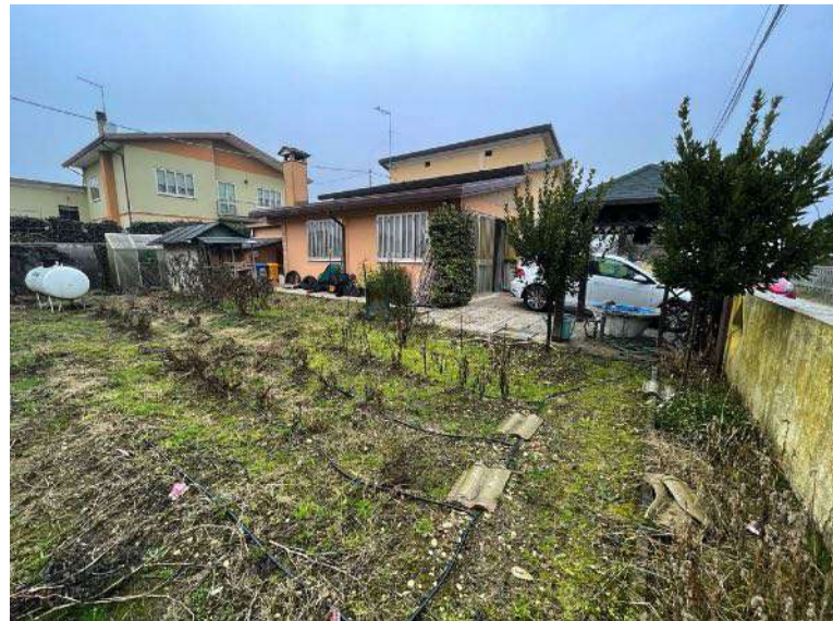
Prospetto Sud-Ovest dell'edificio (casa singola con autorimessa e area scoperta)
