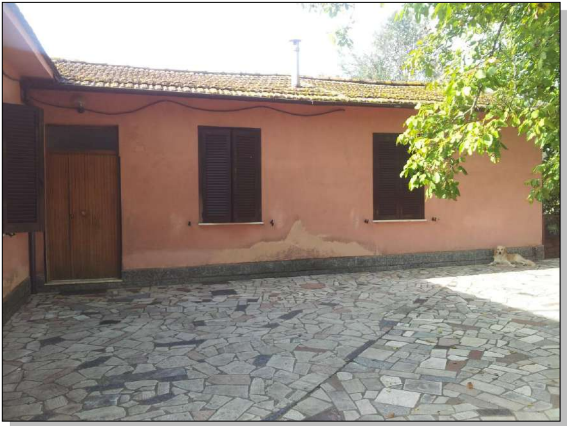
Foto 3 – Vista esterna lato sud-ovest
