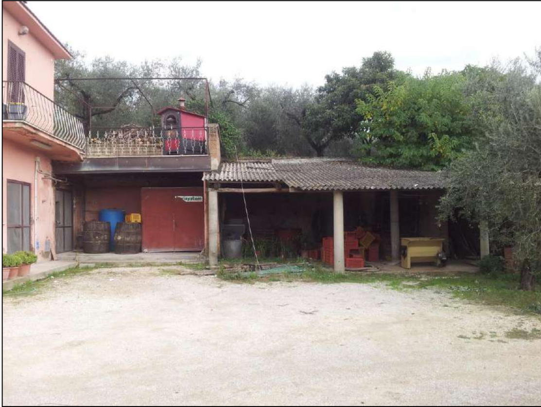
Foto 5 – Vista esterna tettoie annesse – sub.5
