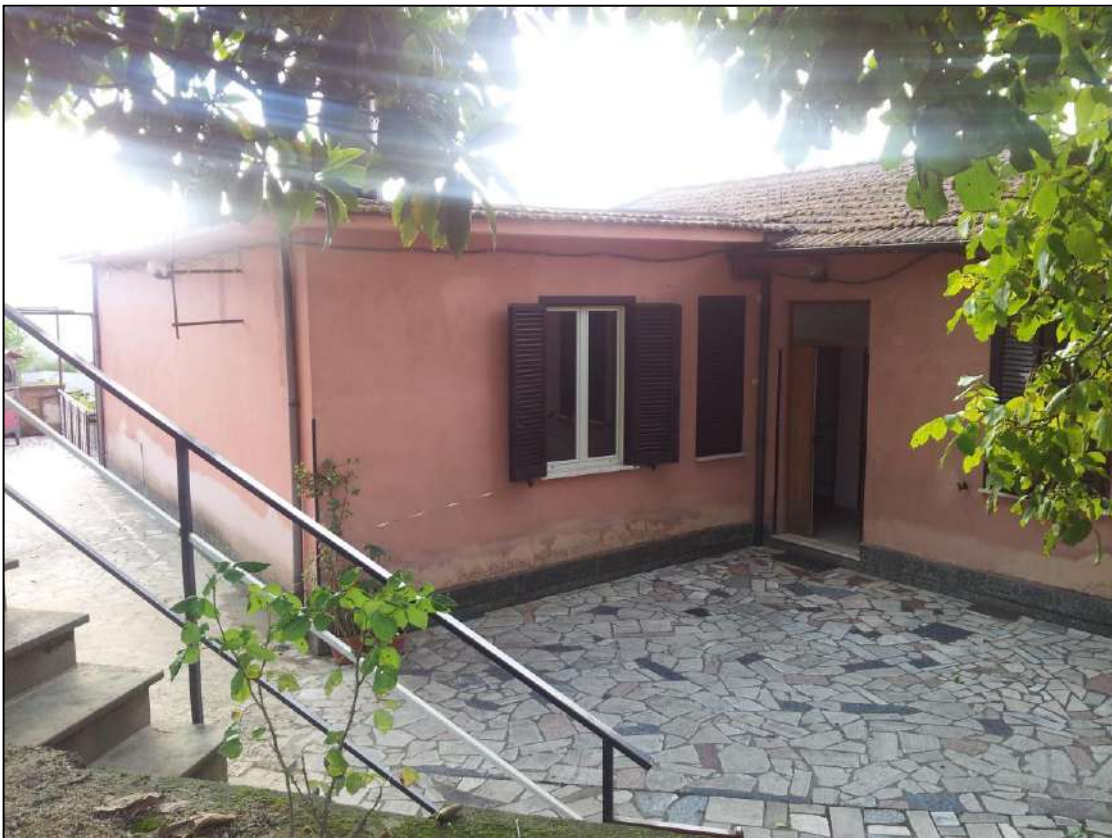
Foto 2 – Vista esterna lati sud-ovest
