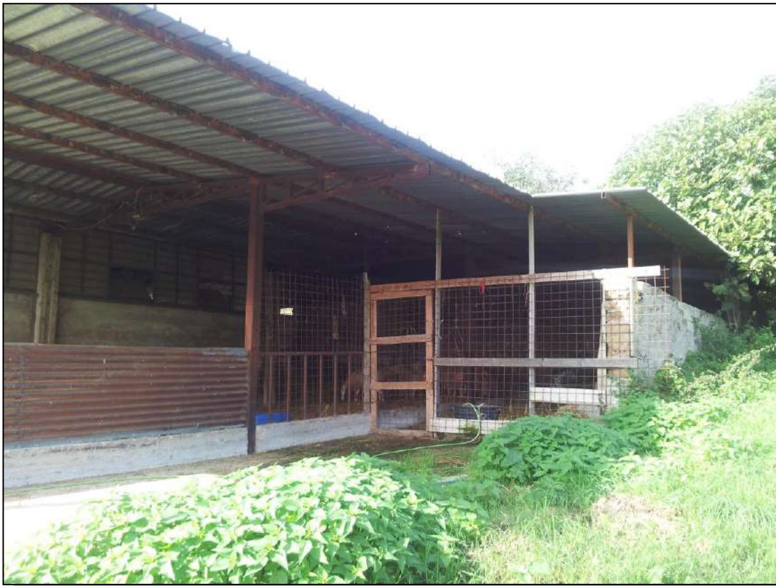
Foto 23 - Vista Tettoia ricovero animali – lato nord-est
