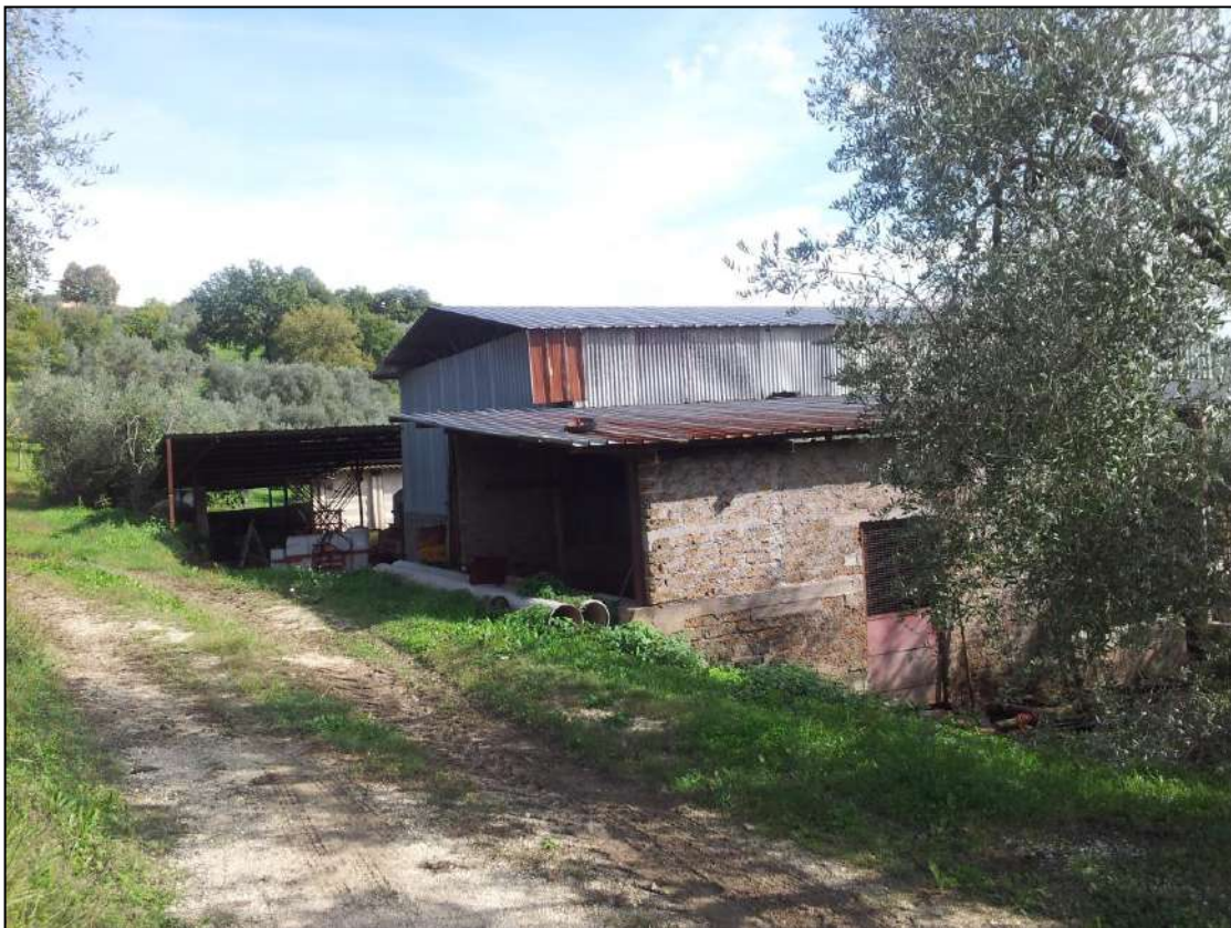
Foto 20 – Vista Porcilaia – lato ovest
