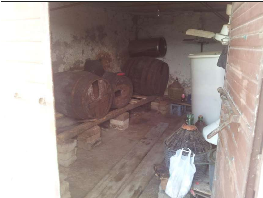
Foto 14 – Vista interna cantina piano seminterrato
