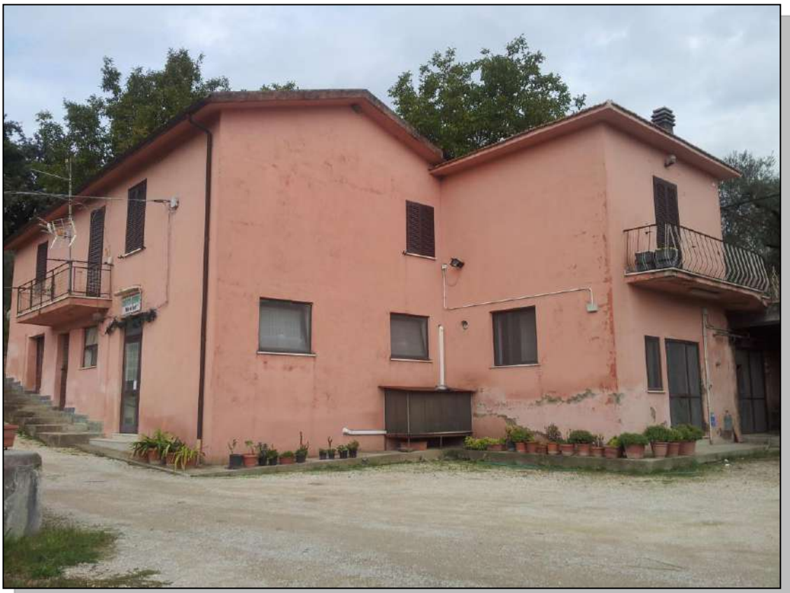
Foto 4 – Vista esterna – lati nord
