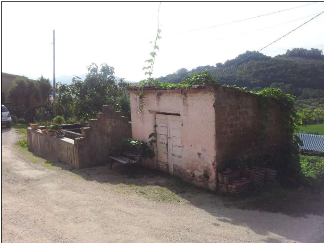
Foto 6 – Vista esterna ripostiglio e fontanile
