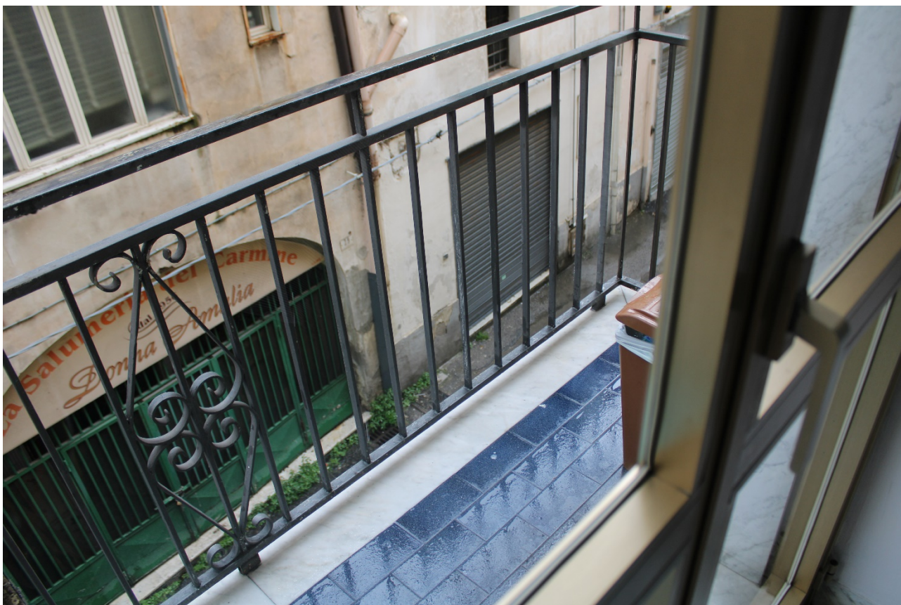
FOTO N° 12: Balcone su Via Carmine
