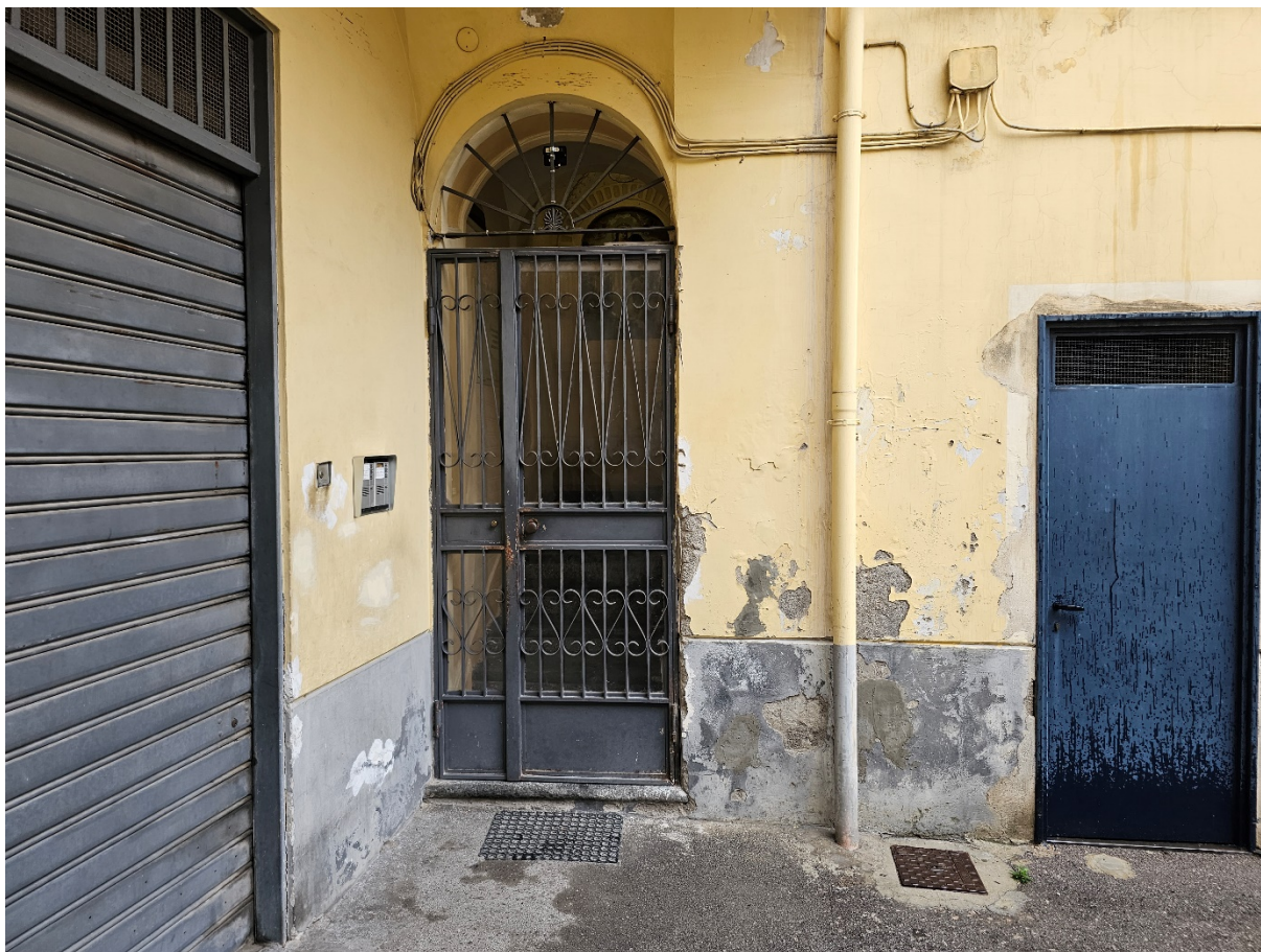
FOTO N° 03: Appartamento in Pagani (SA), via Carmine n° 32
