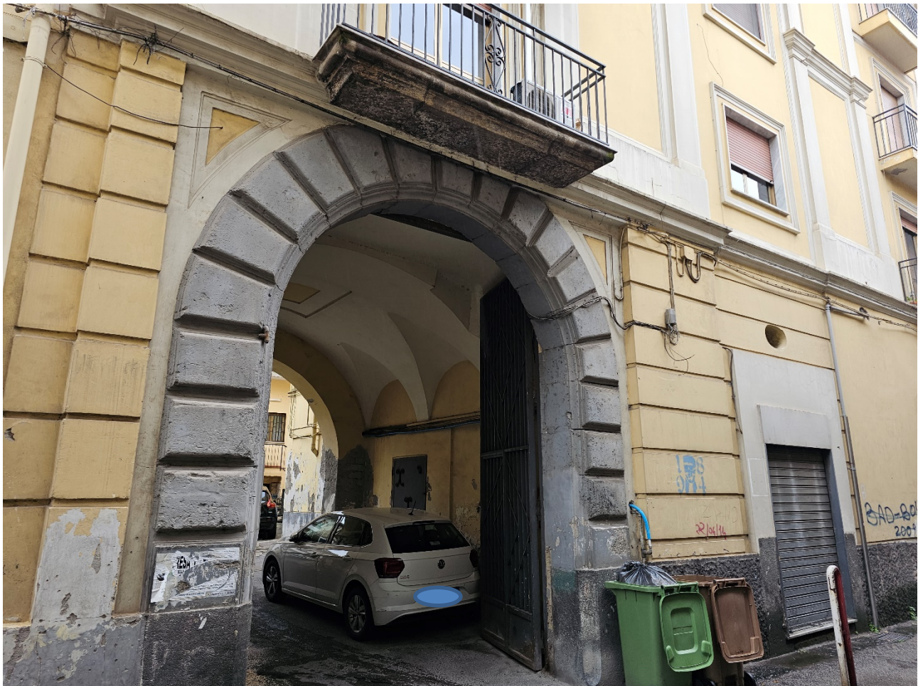
FOTO N° 02: Appartamento in Pagani (SA), via Carmine n° 32
