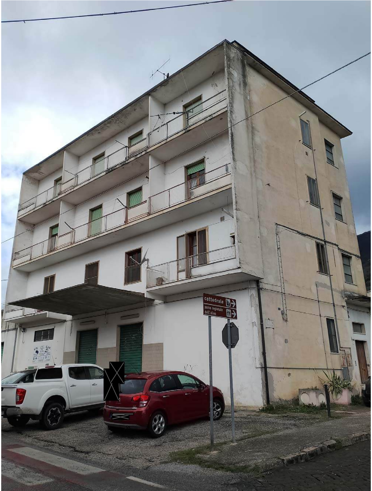
Foto 53B– Vista esterna
