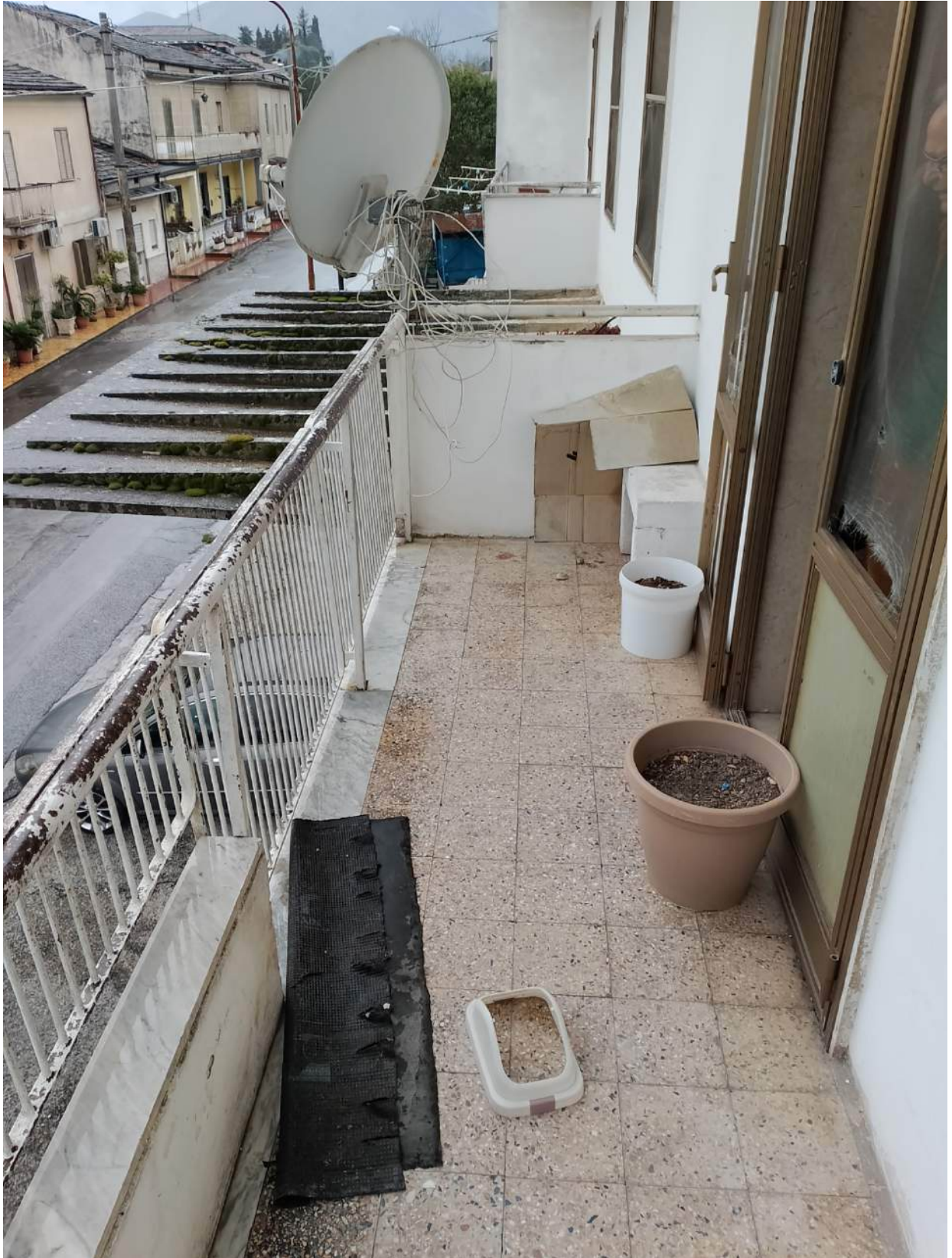
Foto 94 – Vista Interna – balcone
