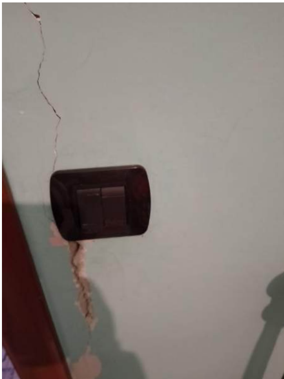
Foto 76, 77 – Vista Interna – lesioni e infiltrazioni
