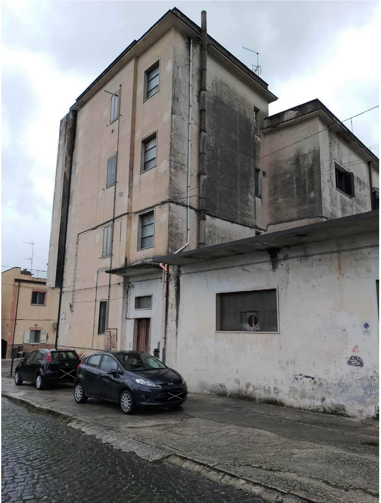
Foto 18B - Vista esterna
