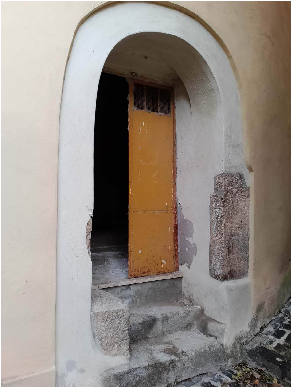
Foto 134 – Vista esterna – portone ingresso
