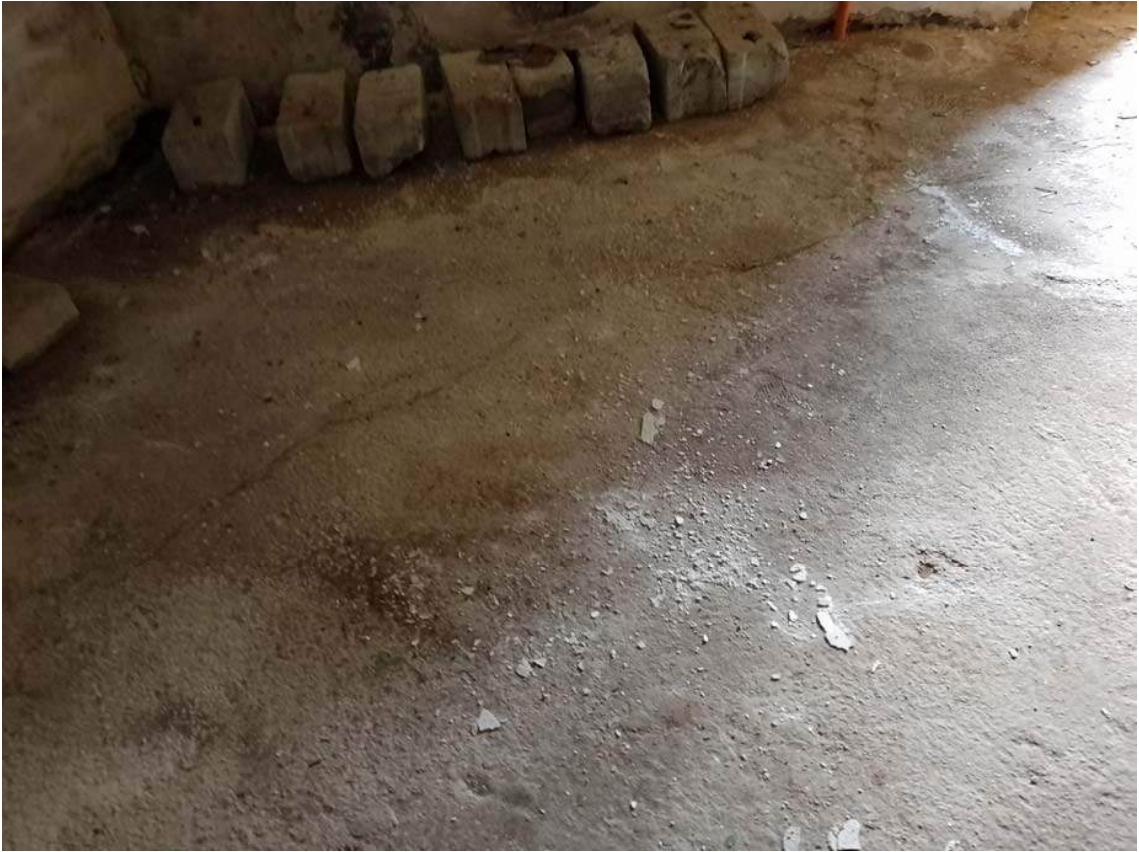
Foto 141 – Vista Interna – pavimentazione interna
