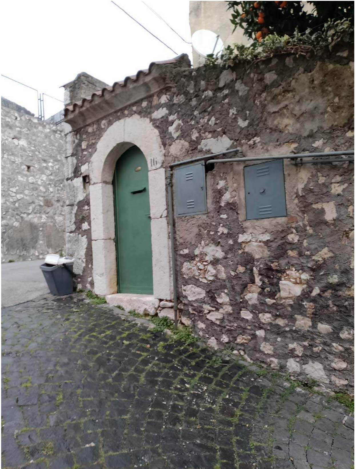
Foto 99A - Vista esterna – ingresso via Lucenteforte
