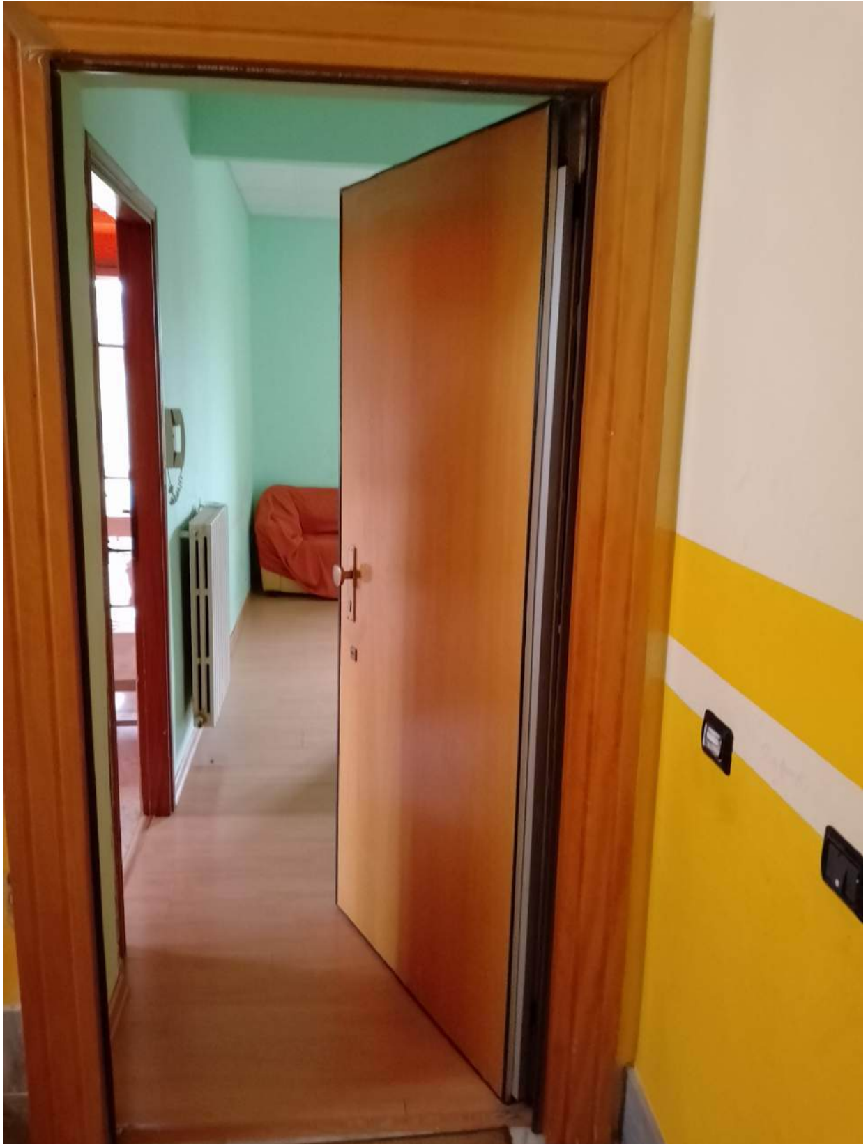
Foto 80 – Vista Interna – portone ingresso
