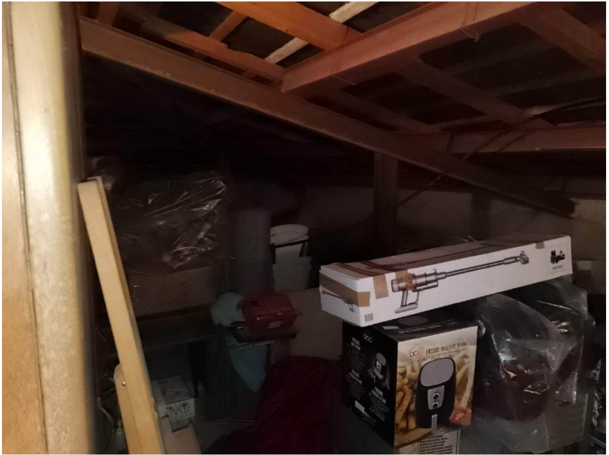
Foto 115 – Vista Interna – sottotetto
