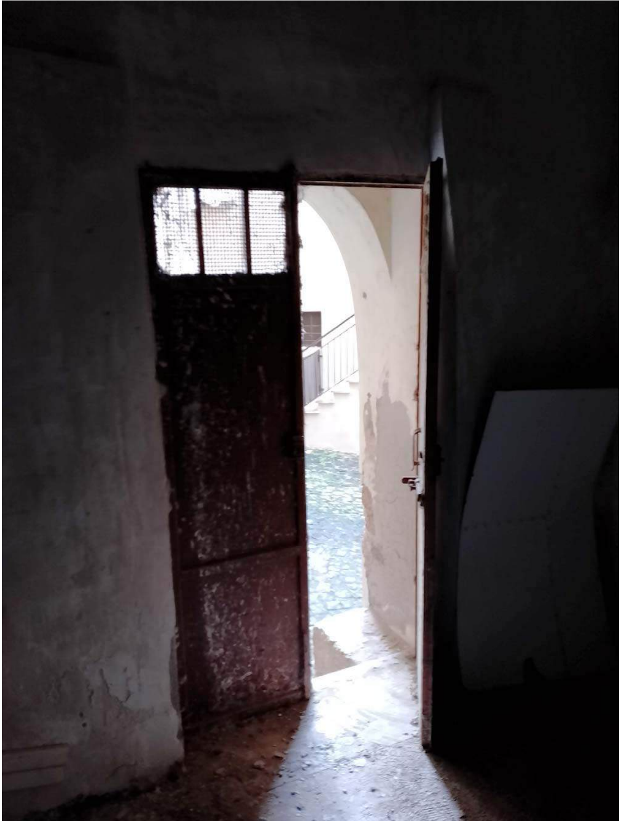
Foto 135 – Vista Interna – portone ingresso
