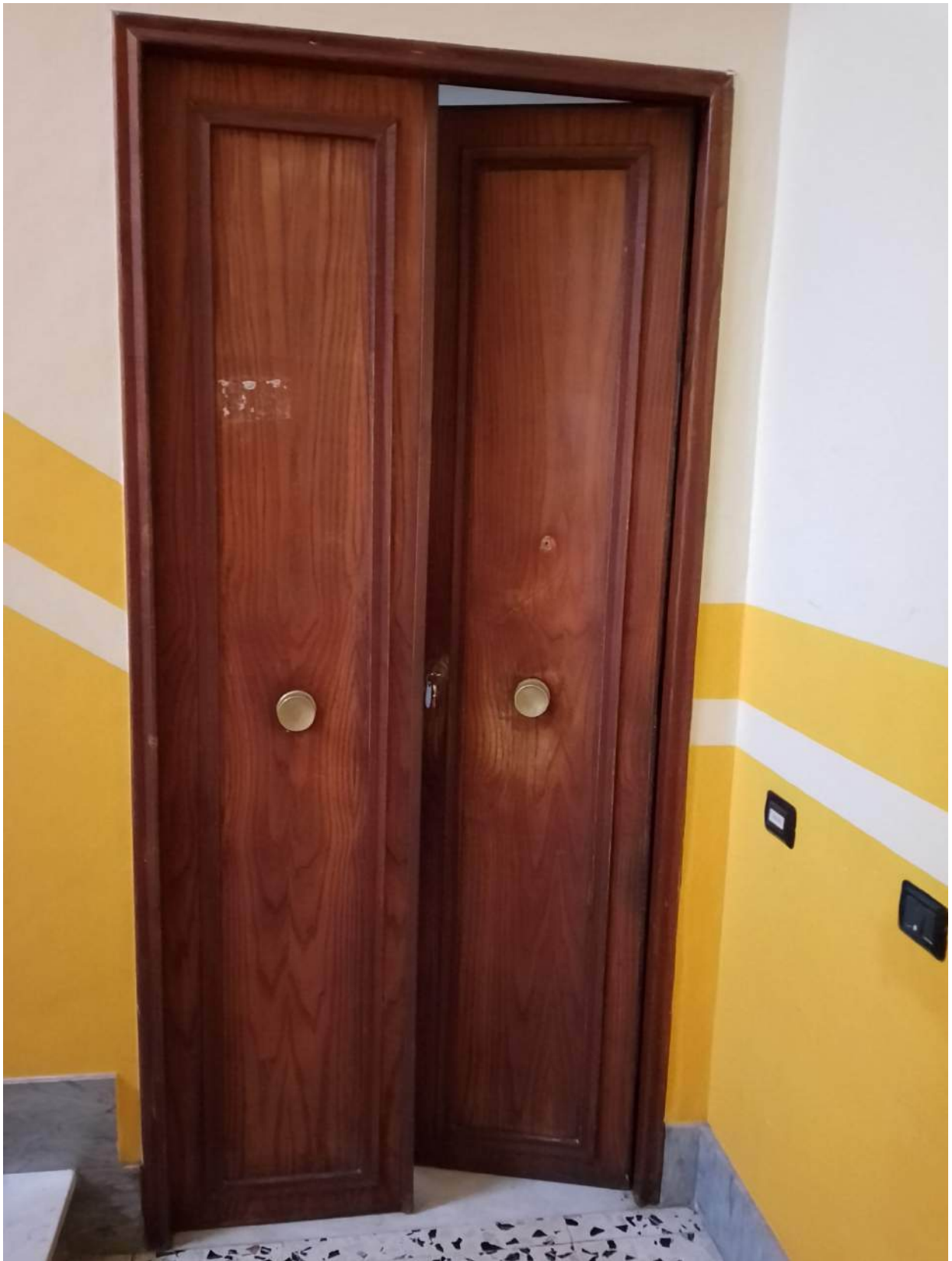
Foto 39 – Portone di ingresso
