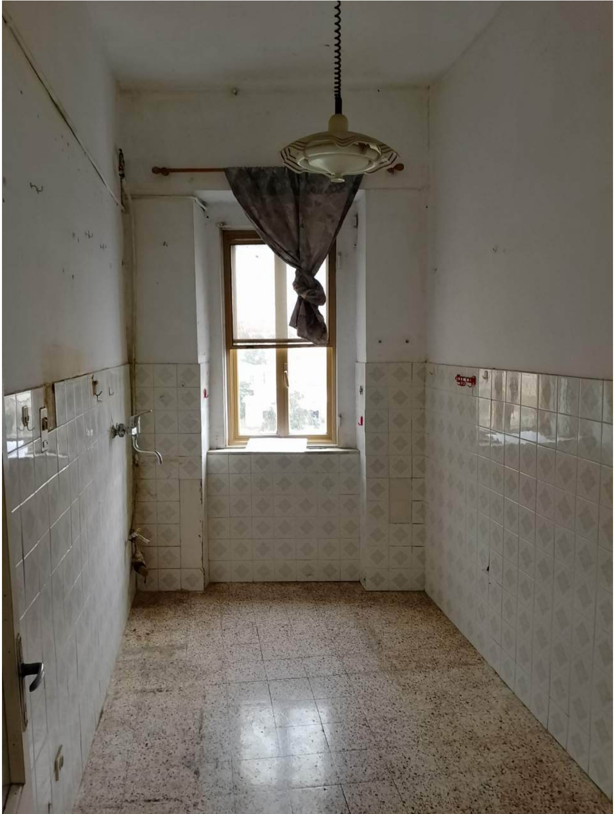
Foto 40 – Vista interna – cucina
