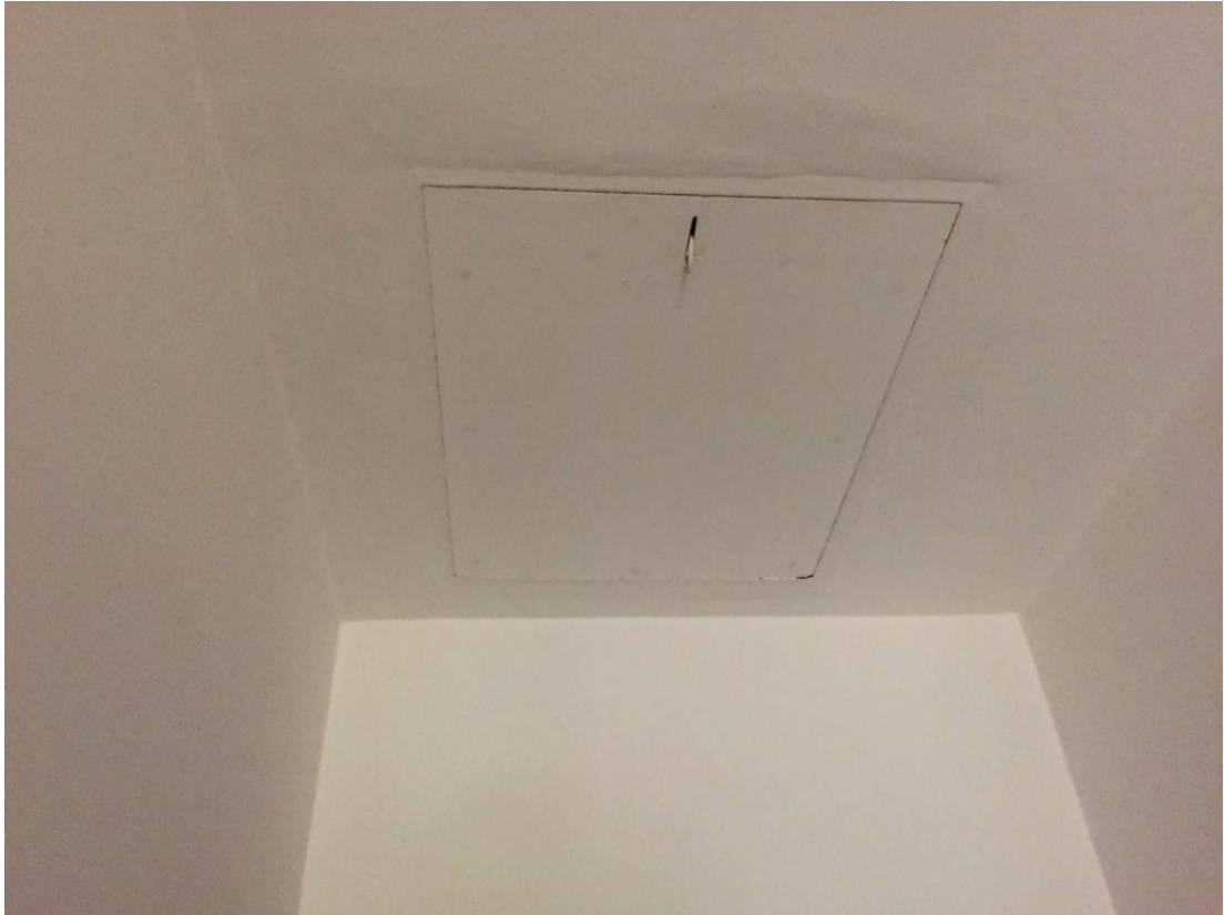
Foto 11 – Botola di accesso al Piano Sottotetto
