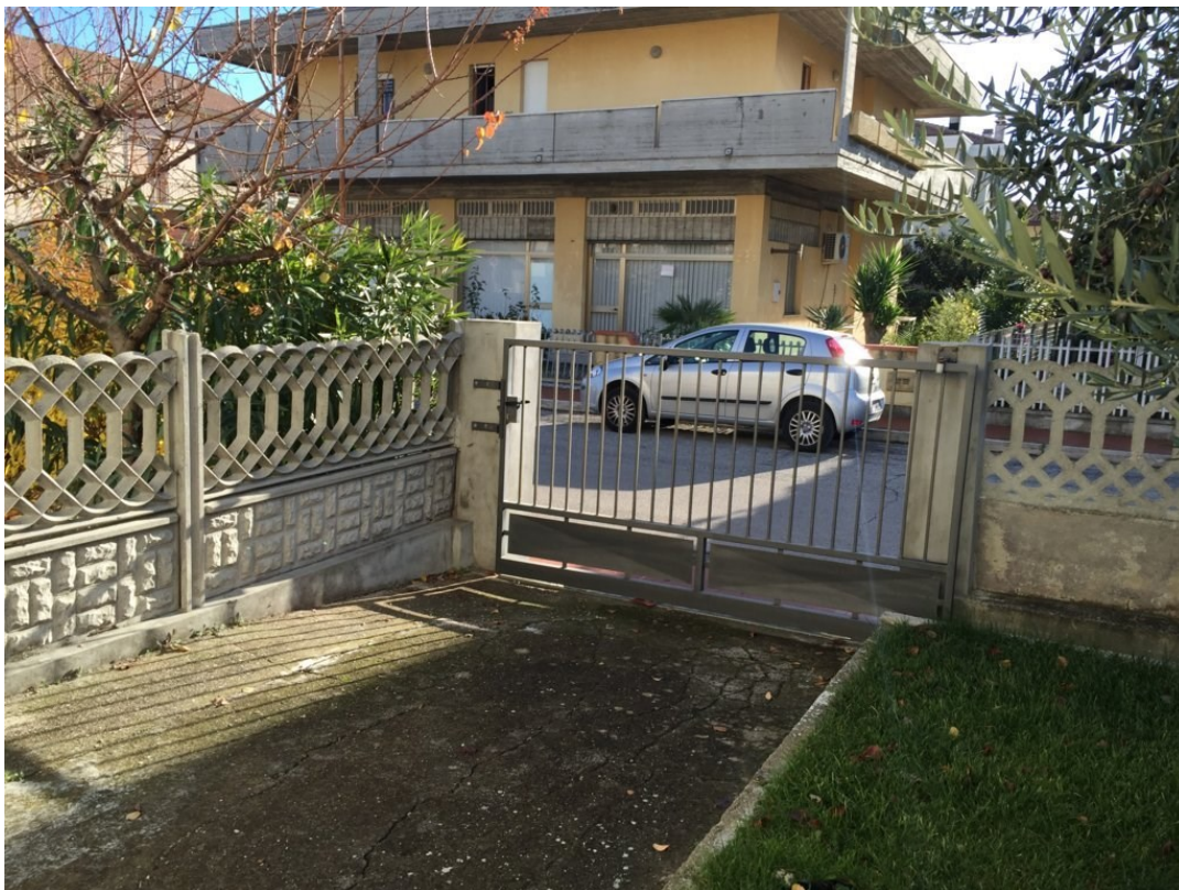
Foto 16 – Particolare accesso carrabile Piano Terra
