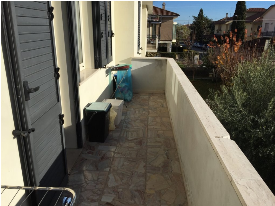
Foto 12 – Balcone lato sud Piano Primo
