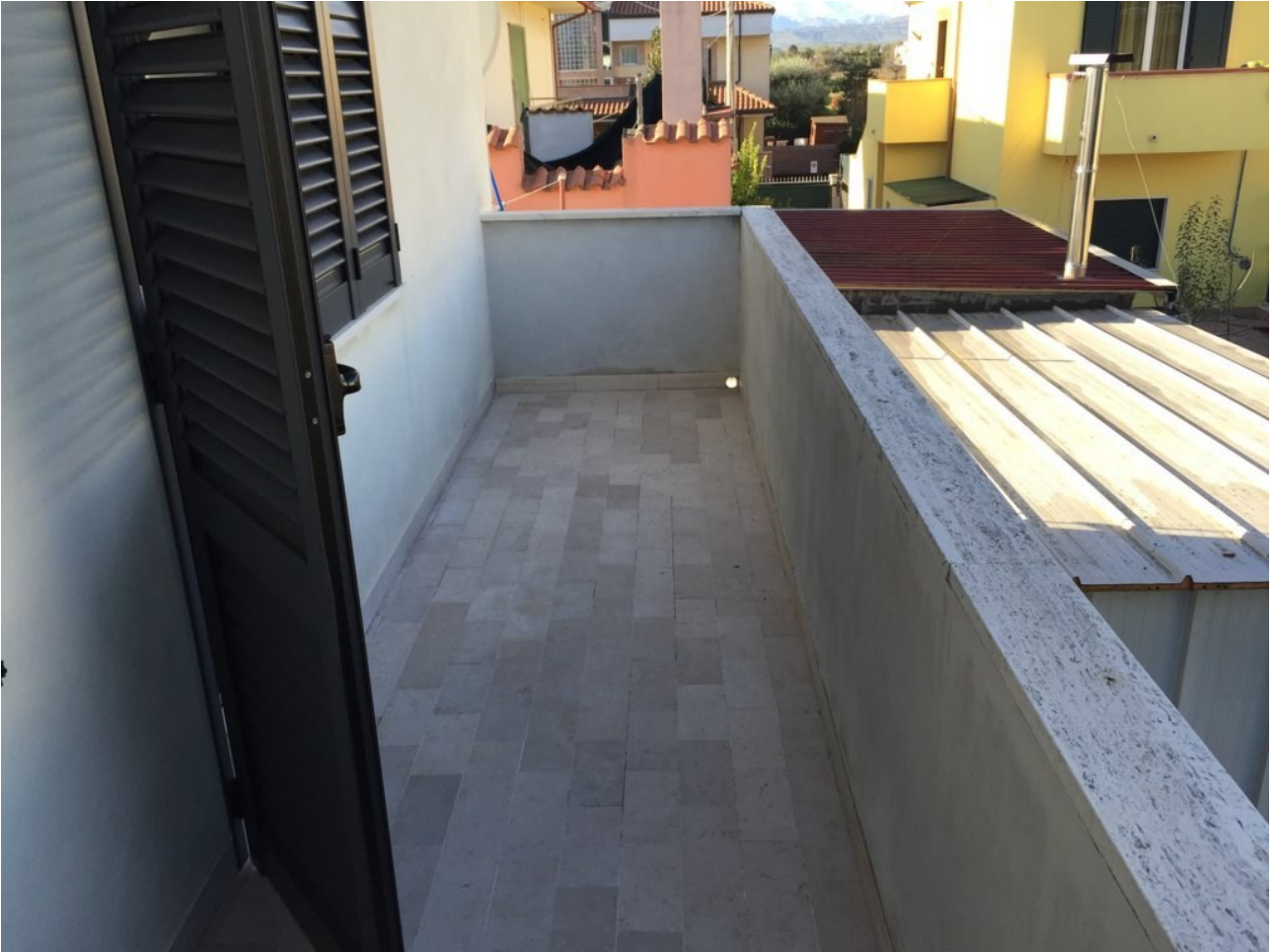
Foto 13 – Balcone lato Nord Piano Primo
