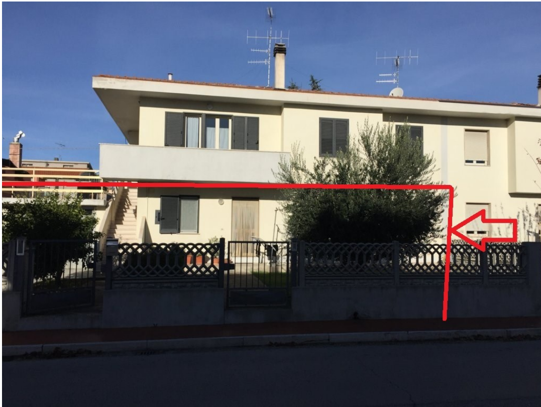
Foto 01 – Individuazione unità immobiliare Piano Terra
