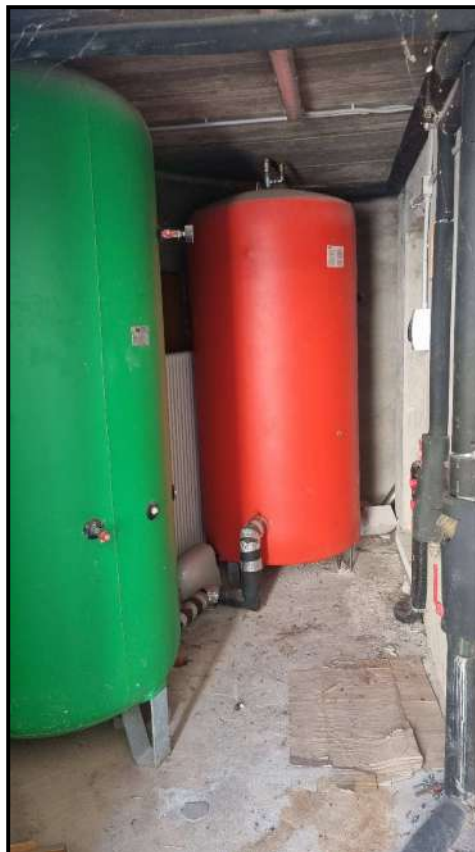
LOCALE TECNICO – piano terra
