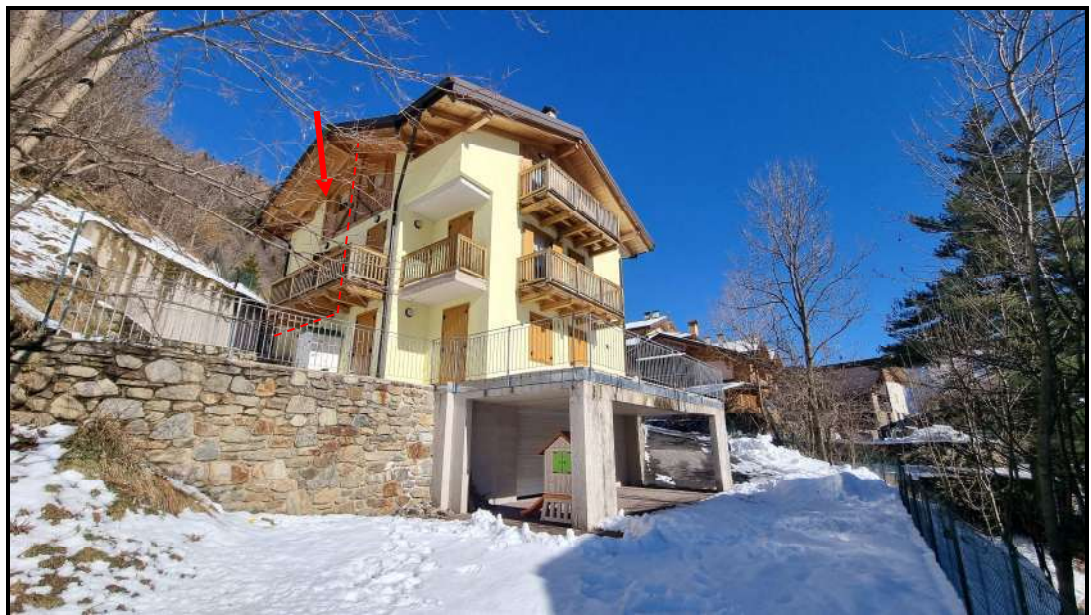
VISTA PROSPETTO SUD - OVEST E ANDITO COMUNE EDIFICIO P.ED. 513 (LOTTO 3)
