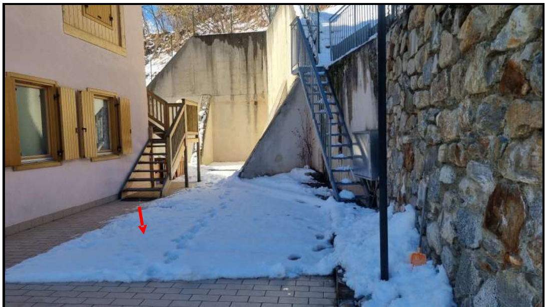
VISTA ANDITO NORD DI PROPRIETA' E COMUNE P.ED. 513 (LOTTO 2) N.B. la scala a sx è a servizio di altra unità abitativa non oggetto di pignoramento Vedasi planimetria piano divisione materiale
