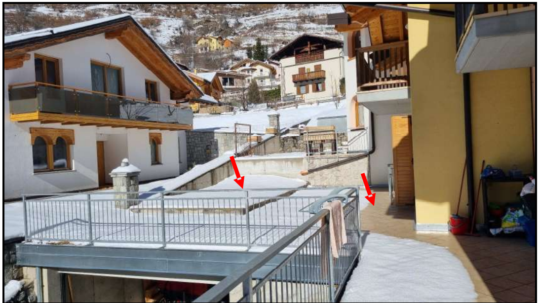
VISTA ANDITO OVEST DI PROPRIETA' P.ED. 1294 C.C. VERMIGLIO
