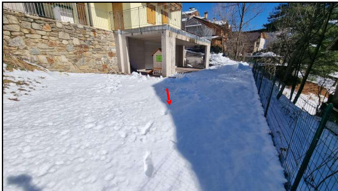
VISTA ANDITO SUD COMUNE DI ACCESSO GARAGE P.ED. 513 (LOTTO 3)
