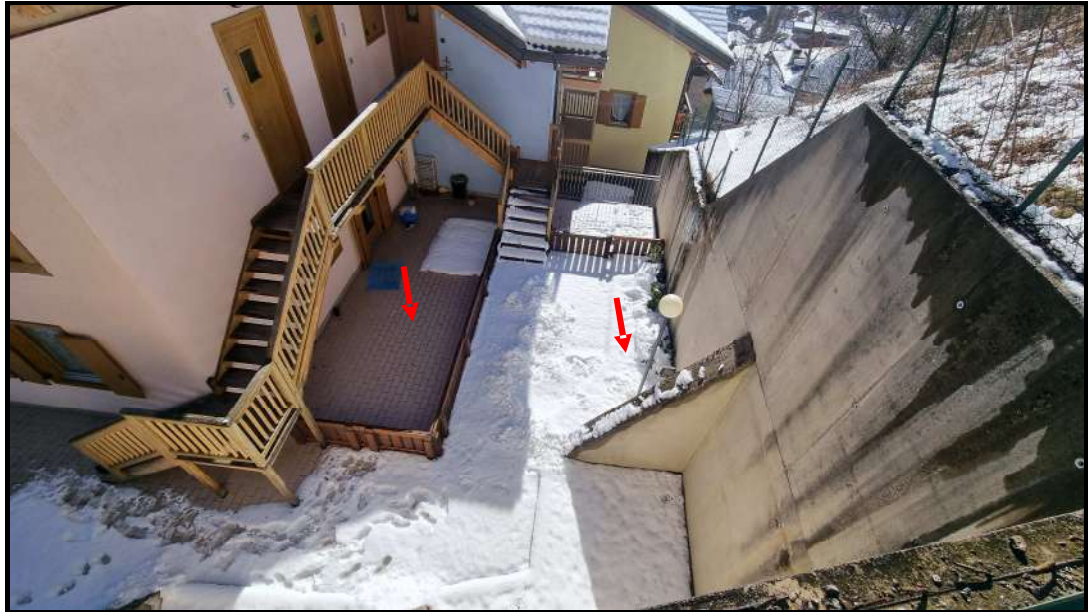
VISTA ANDITO OVEST DI PROPRIETA' E COMUNE P.ED. 513 (LOTTO 2) N.B. la scala è a servizio di altra unità abitativa non oggetto di pignoramento Vedasi planimetria piano divisione materiale
