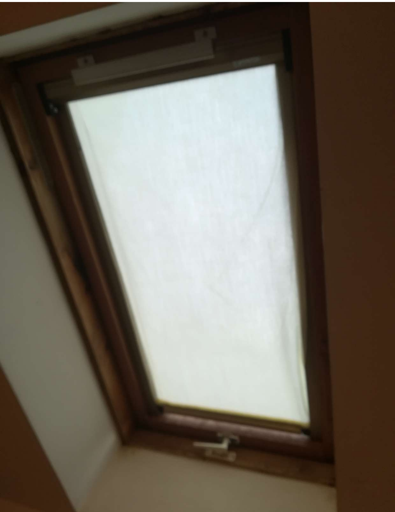
Soffitta al piano secondo sottotetto - p.r.f. 7
