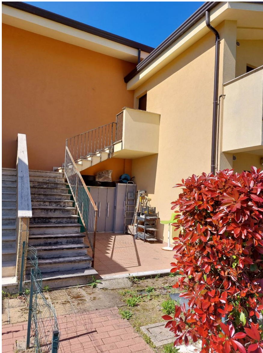
Foto N.9: Sub.4_ Prospetto fabbricato Est
