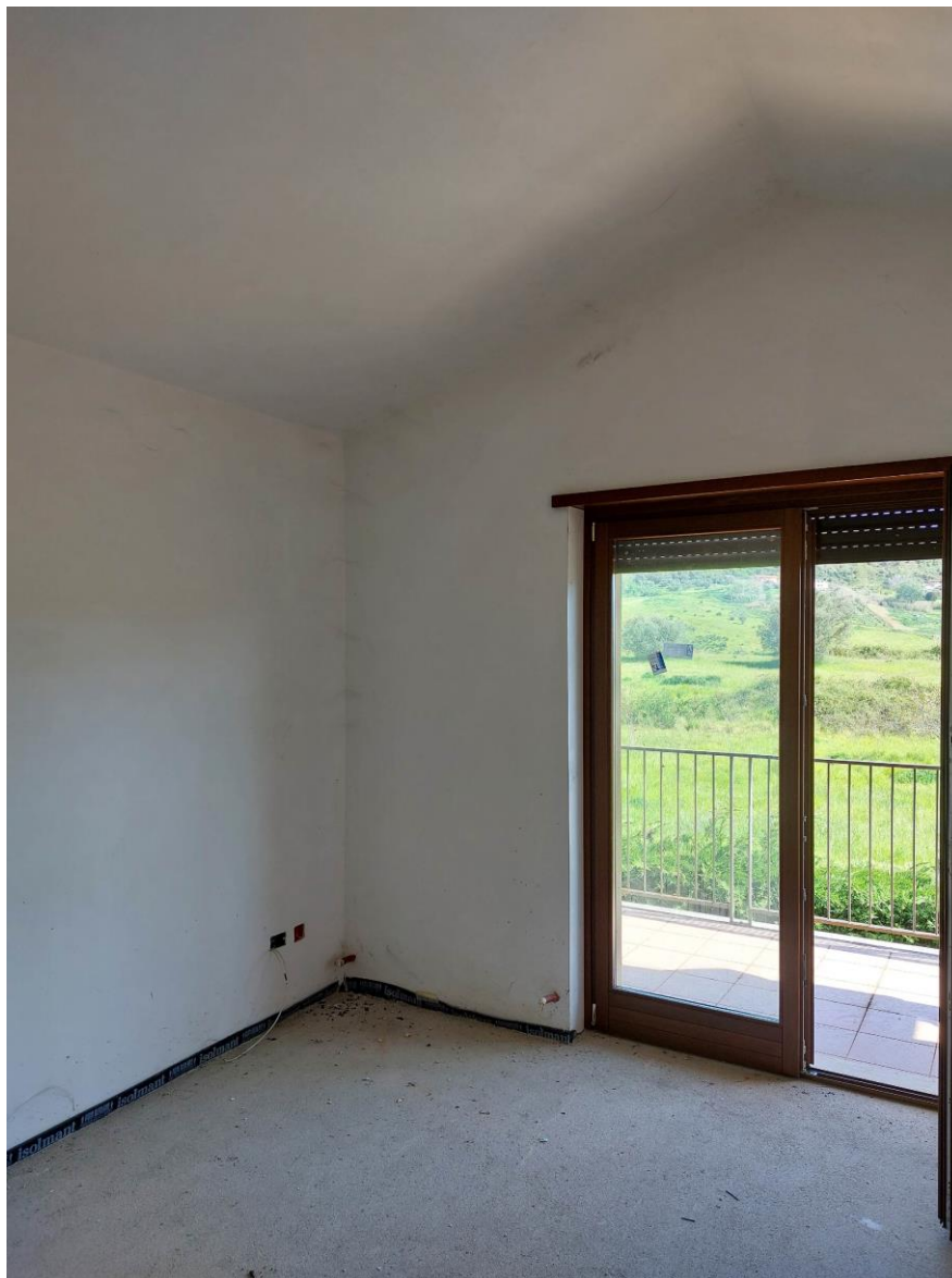
Foto N.12: Sub.4_cucina con balcone
