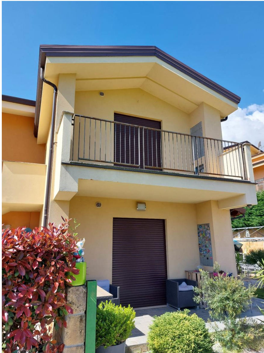
Foto N.8: Sub.4_ Prospetto fabbricato Nord
