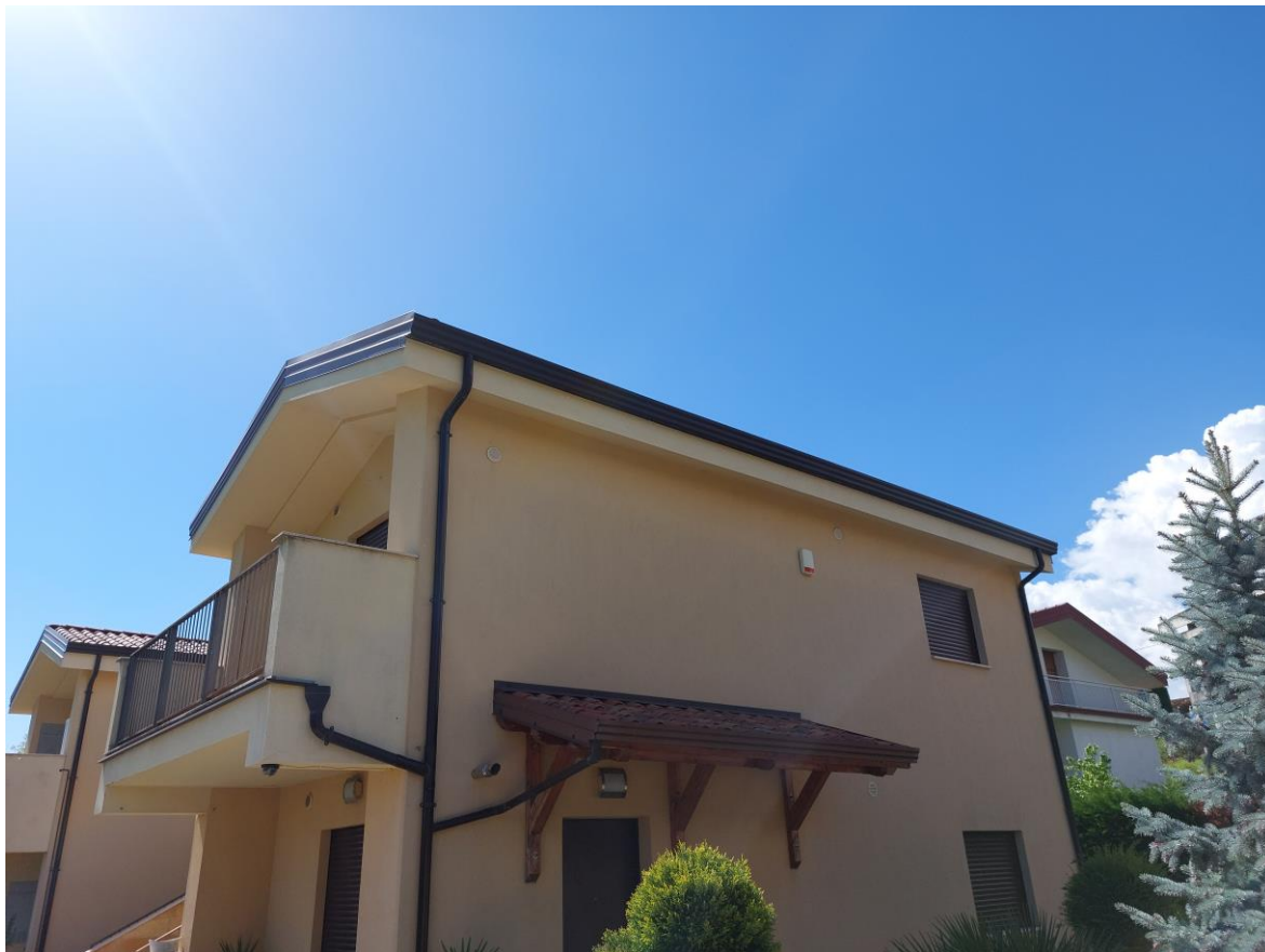
Foto N.10: Sub.4_ Prospetto fabbricato Ovest
