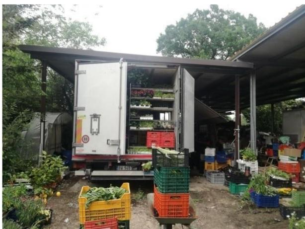
La tettoia (foto accanto) è una struttura elementare realizzata in acciaio e copertura a pannelli. Impegna 270 mq con altezza di 3,5 e 3,9 metri.
