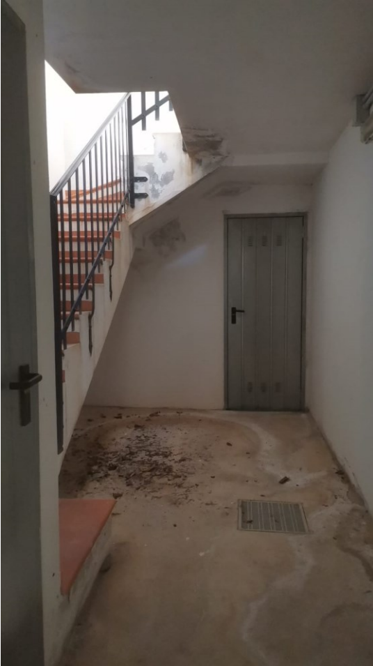
FIGURE 30: A) SCALA DI ACCESSO ALL'INTERRATO;
