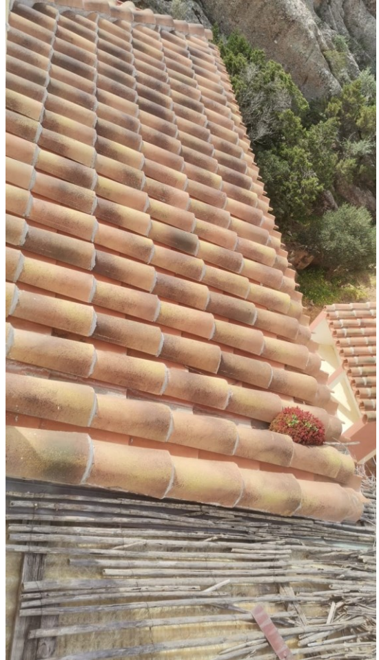
B) STATO ATTUALE DELLA COPERTURA
