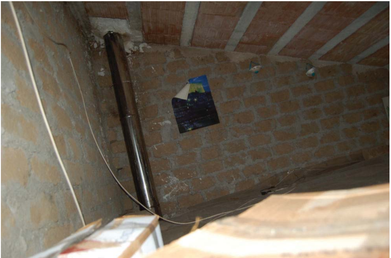
Foto 35 - Vista dell'ambiente sottotetto
