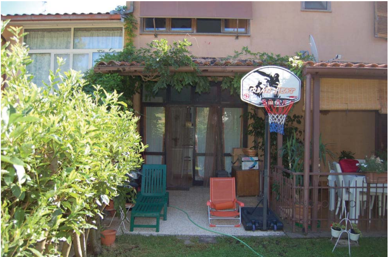
Foto 11 – Vetrata d'accesso all'unità immobiliare (cucina)
