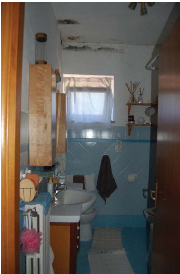
Foto 30 - Bagno zona notte (piano primo)
