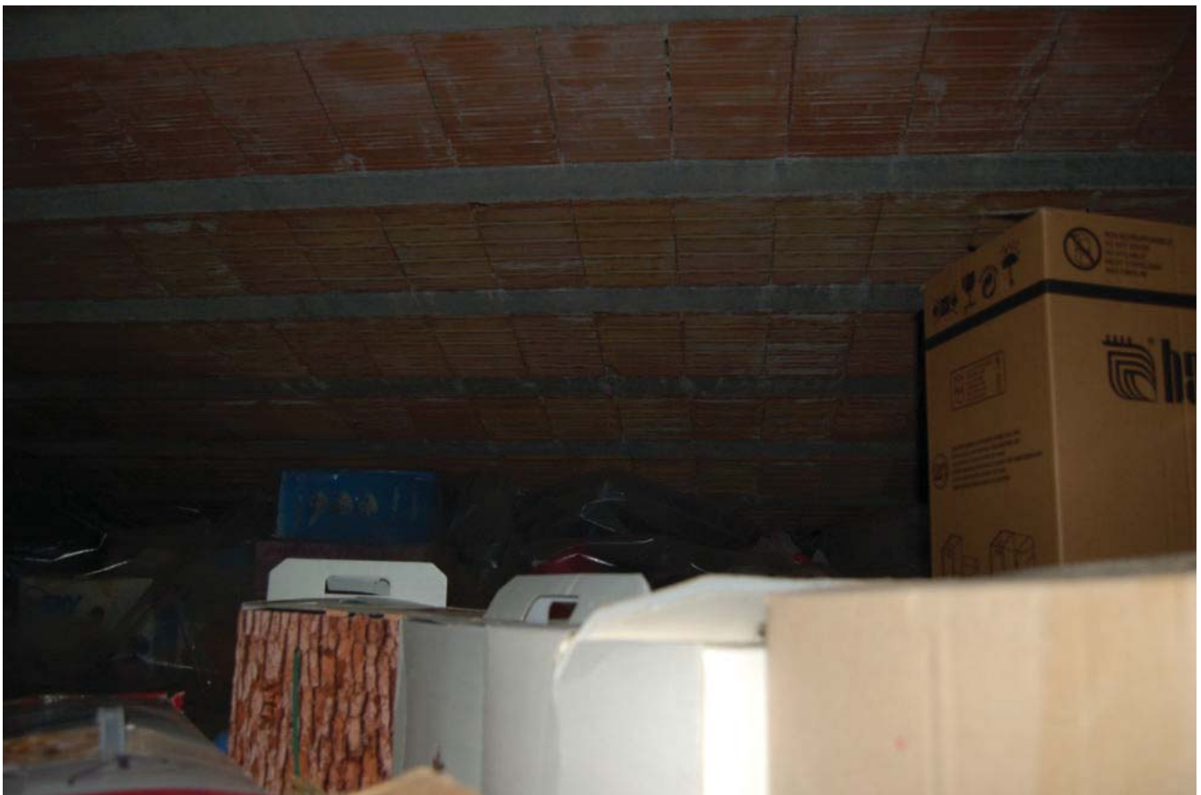
Foto 36 - Vista dell'ambiente sottotetto
