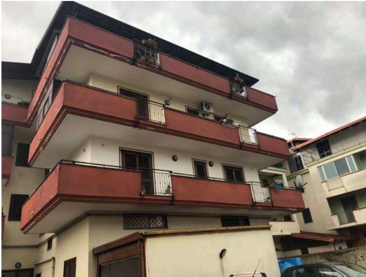
PROSPETTO INTERNO AL CORTILE
