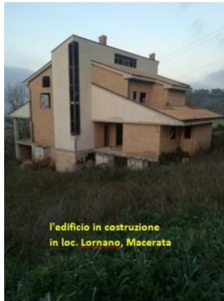
g) Edificio in costruzione in c.da Lornano, valore 275.000 euro seminativo di ha 2,14 valore 54.000 euro
