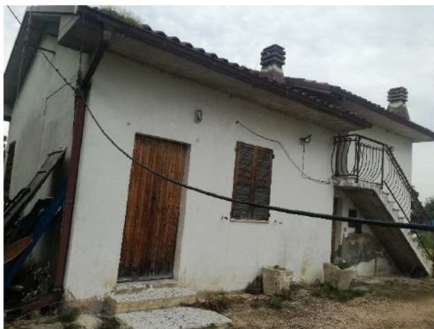
Comune di Pollenza, loc. Potenza Edificio residenziale che insiste sulla particella 84 del foglio 2
