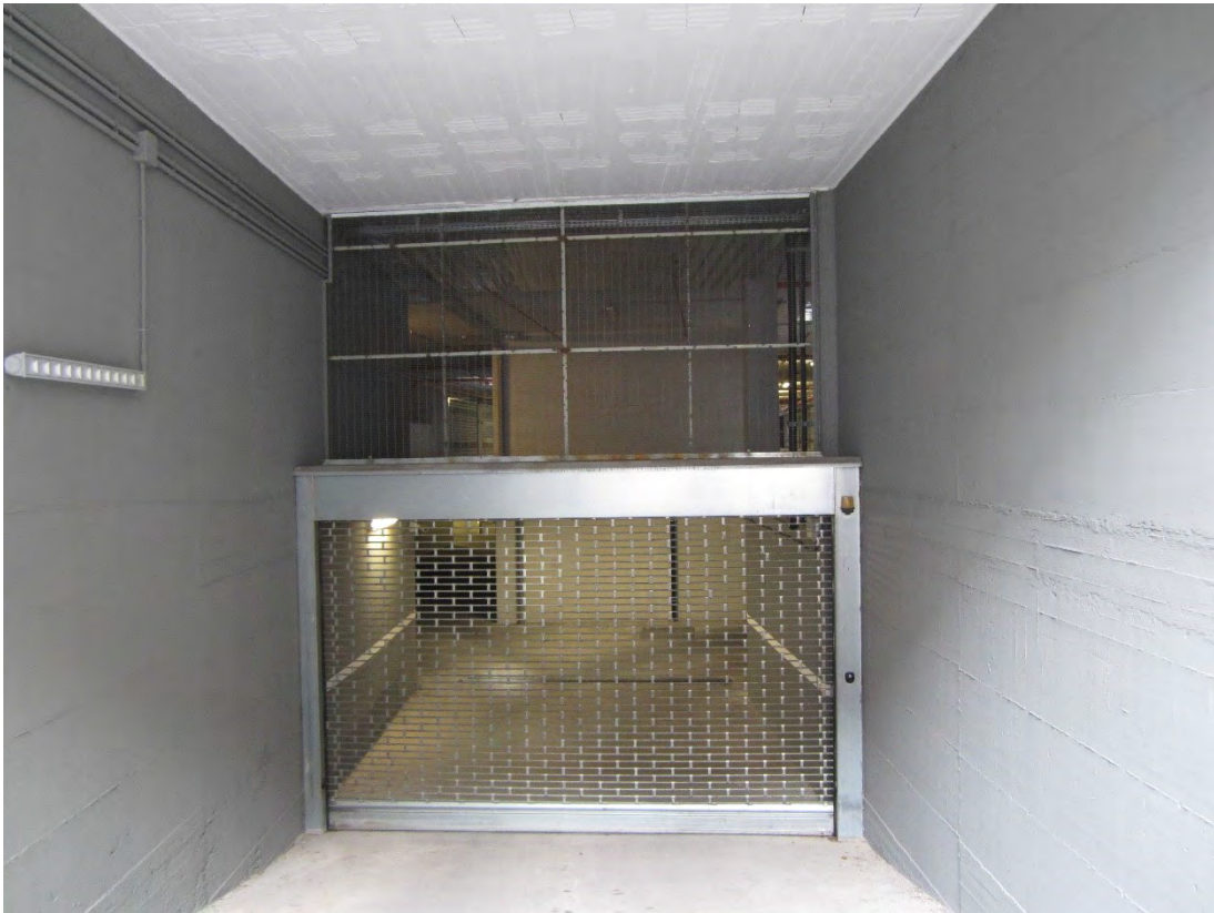
Foto 28: il cancello automatizzato da cui si accede al primo livello cantinato, dove si trova il locale box identificato, nel foglio 30, dalla particella 2515 sub. 164
