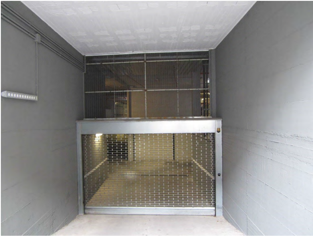
Foto 46: il cancello automatizzato da cui si accede al primo livello cantinato, dove si trova il locale box identificato, nel foglio 30, dalla particella 2515 sub. 310
