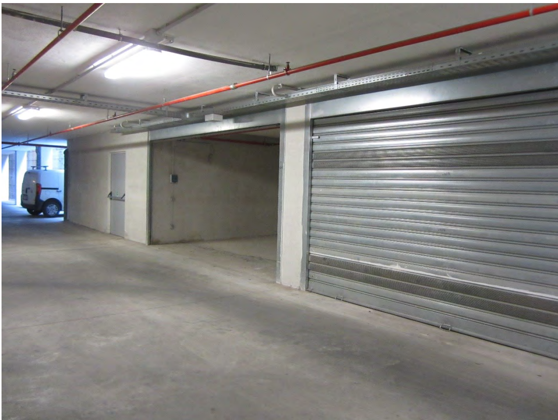
Foto 56: l'ingresso al locale box identificato, nel foglio 30, dalla particella 2515 sub. 315, attraverso una serranda avvolgibile metallica
