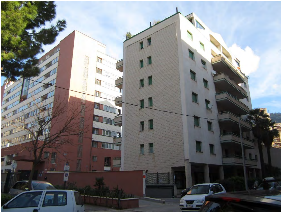
Foto 44: inquadratura, dalla via Sacra Famiglia, dell'edificio in cui insiste, al primo livello cantinato, il locale box, identificato, nel foglio 30, dalla particella 2515 sub. 310
