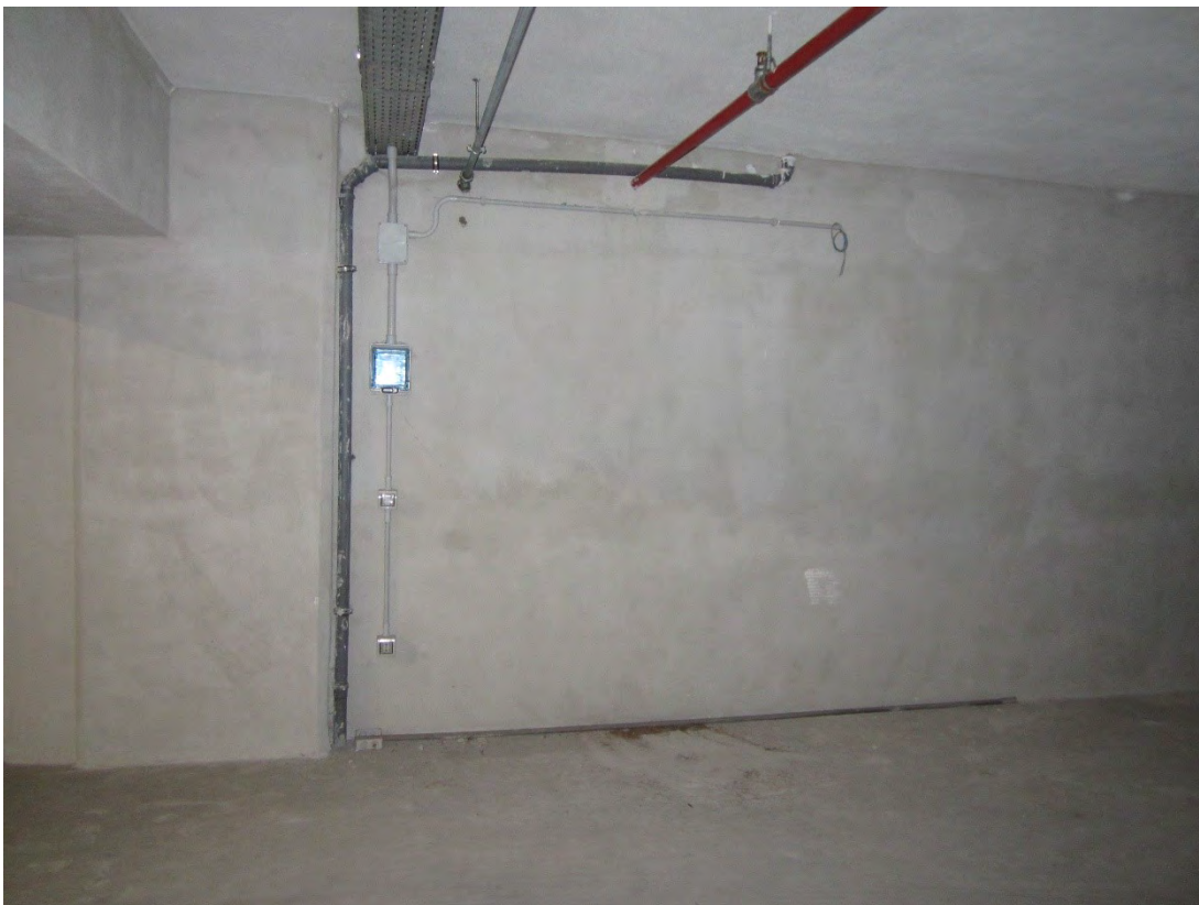
Foto 76: altra panoramica del locale box identificato, nel foglio 30, dalla particella 2515 sub. 322
