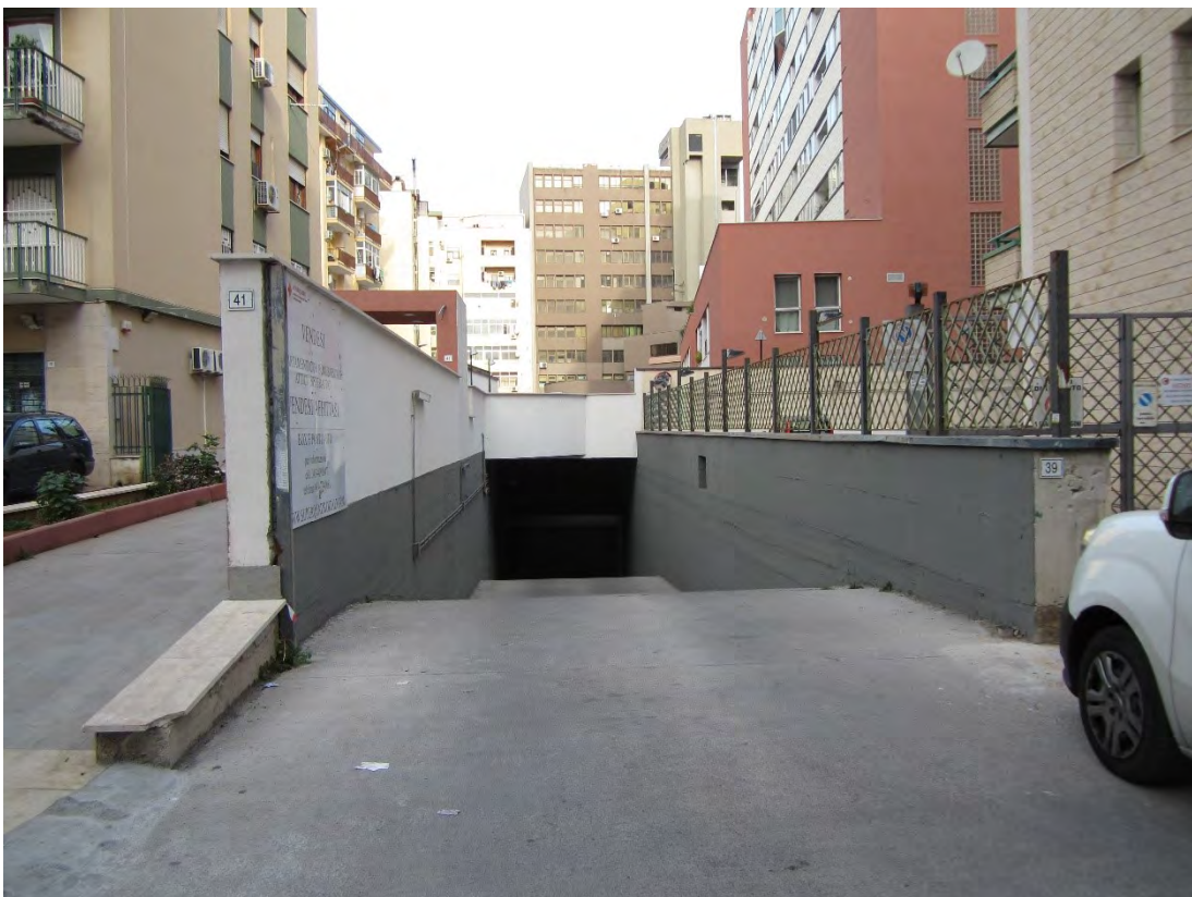
Foto 81: la rampa che, dal civico 39 della via Sacra Famiglia, consente di raggiungere il primo livello cantinato, dove si trova il locale sgombero/cantina, identificato, nel foglio 30, dalla particella 2515 sub. 388
