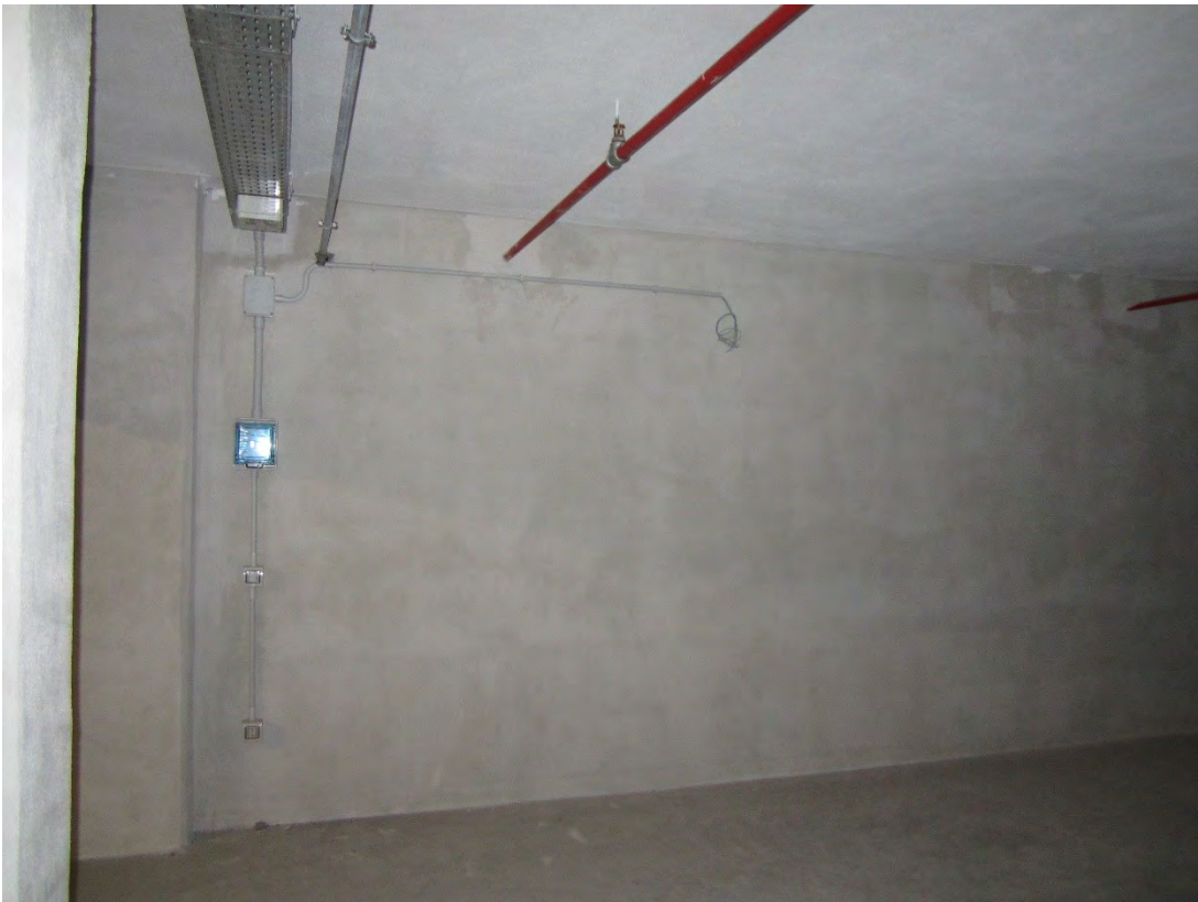
Foto 67: altra panoramica del locale box identificato, nel foglio 30, dalla particella 2515 sub. 321
