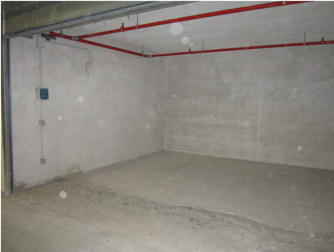
Foto 57: panoramica interna del locale box identificato, nel foglio 30, dalla particella 2515 sub. 315
