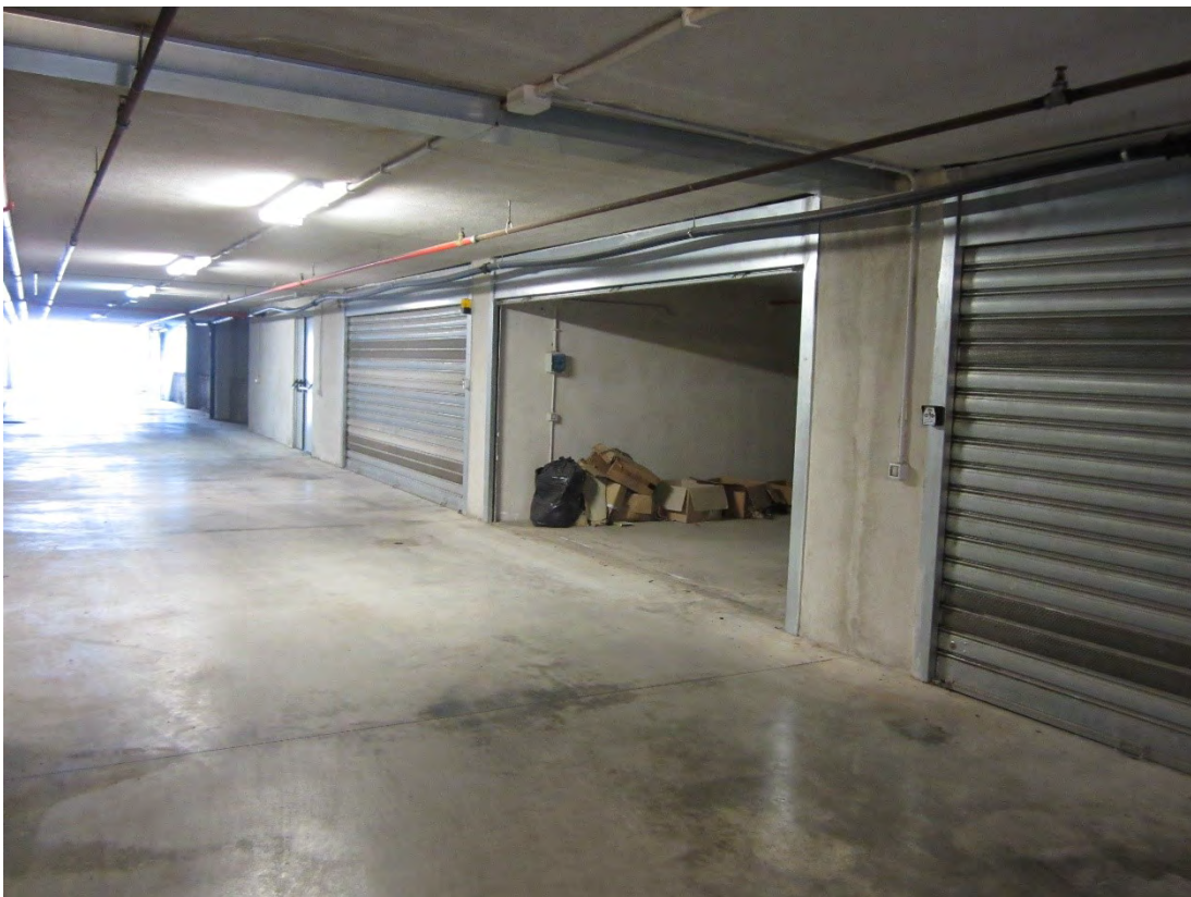
Foto 47: l'ingresso al locale box identificato, nel foglio 30, dalla particella 2515 sub. 310, attraverso una serranda avvolgibile metallica
