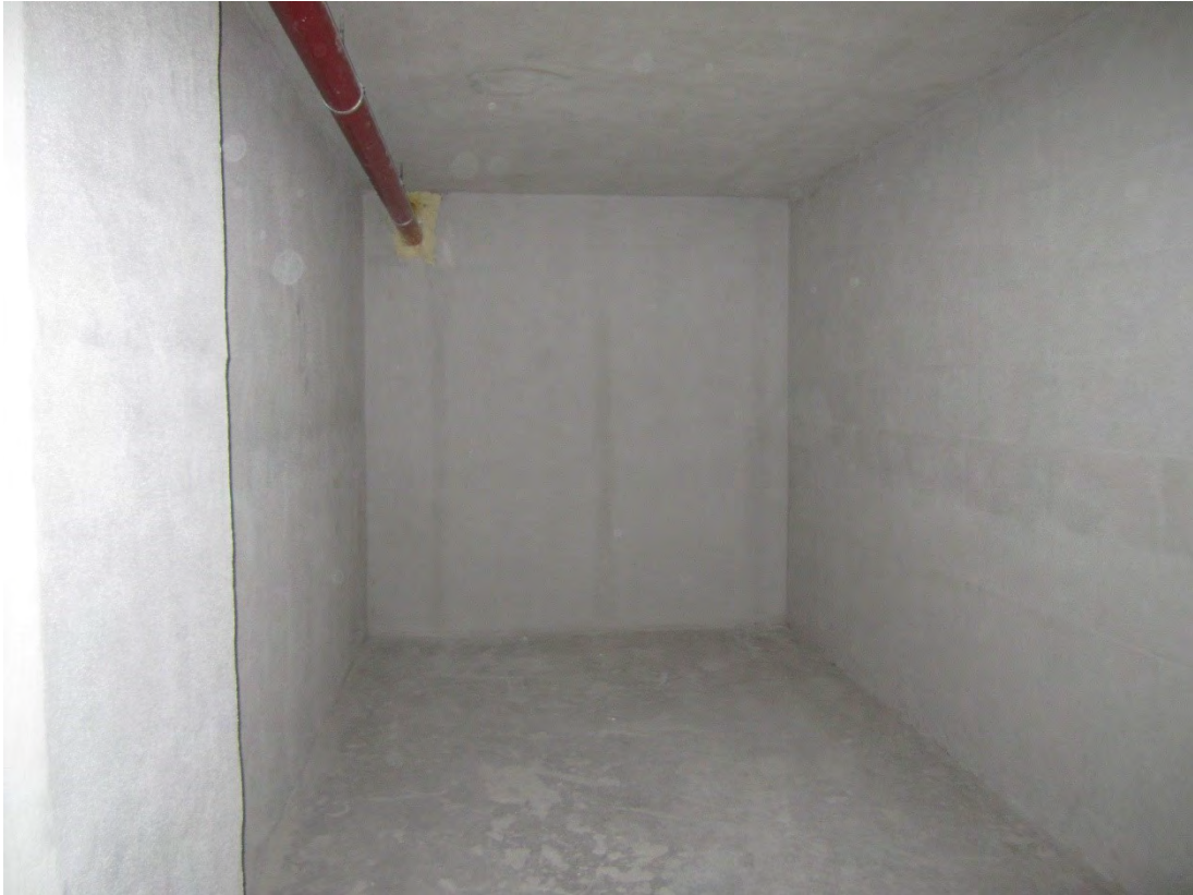
Foto 84: panoramica del locale sgombero/cantina identificato, nel foglio 30, dalla particella 2515 sub. 388
