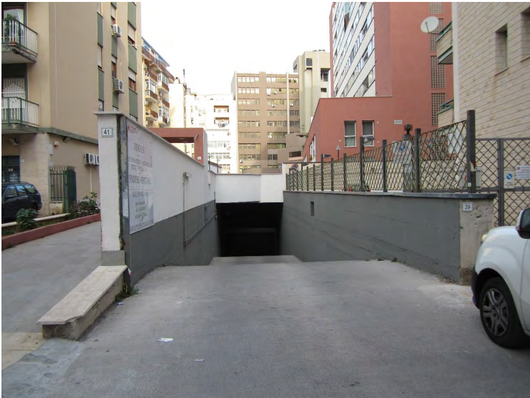
Foto 54: la rampa che, dal civico 39 della via Sacra Famiglia, consente di raggiungere il primo ed il secondo livello cantinato, dove si trova il locale box, identificato, nel foglio 30, dalla particella 2515 sub. 315
