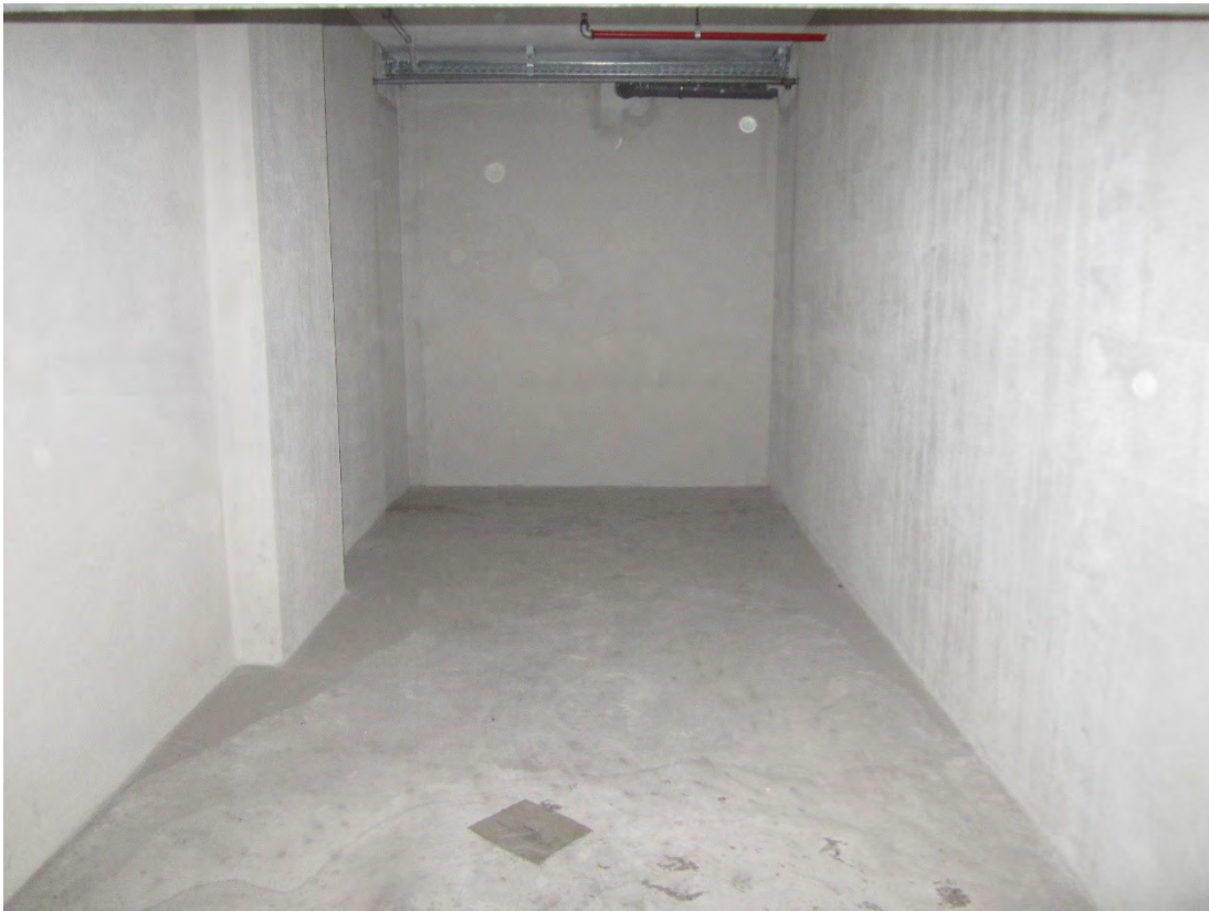
Foto 39: panoramica del locale sgombero/box identificato, nel foglio 30, dalla particella 2515 sub. 224
