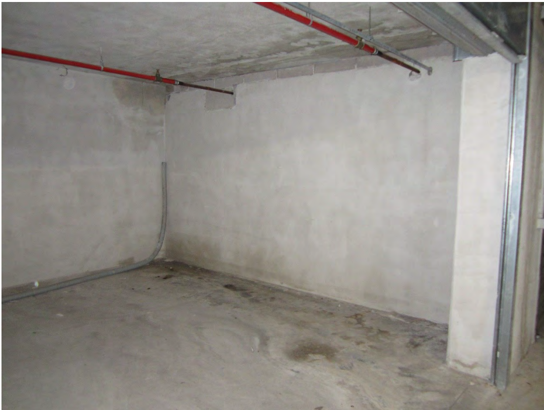
Foto 49: altra panoramica del locale box identificato, nel foglio 30, dalla particella 2515 sub. 310
