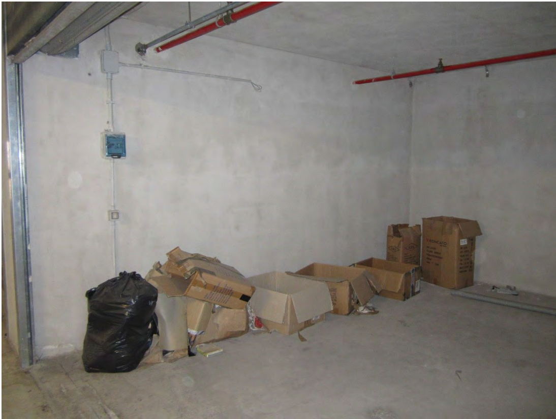
Foto 48: panoramica del locale box identificato, nel foglio 30, dalla particella 2515 sub. 310
