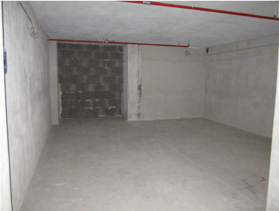
Foto 66: panoramica del locale box identificato, nel foglio 30, dalla particella 2515 sub. 321
