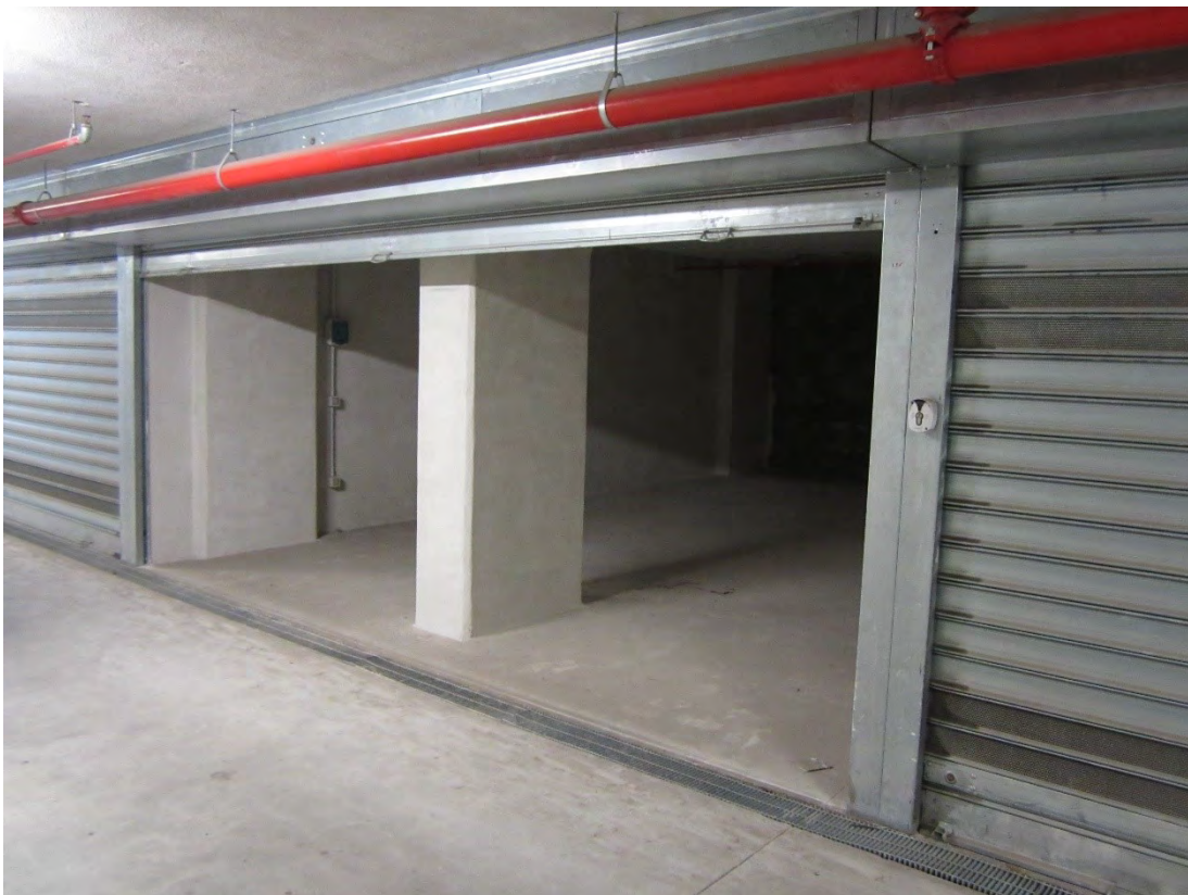
Foto 65: l'ingresso al locale box identificato, nel foglio 30, dalla particella 2515 sub. 321, attraverso una serranda avvolgibile metallica; un pilastro separa in due il vano d'accesso
