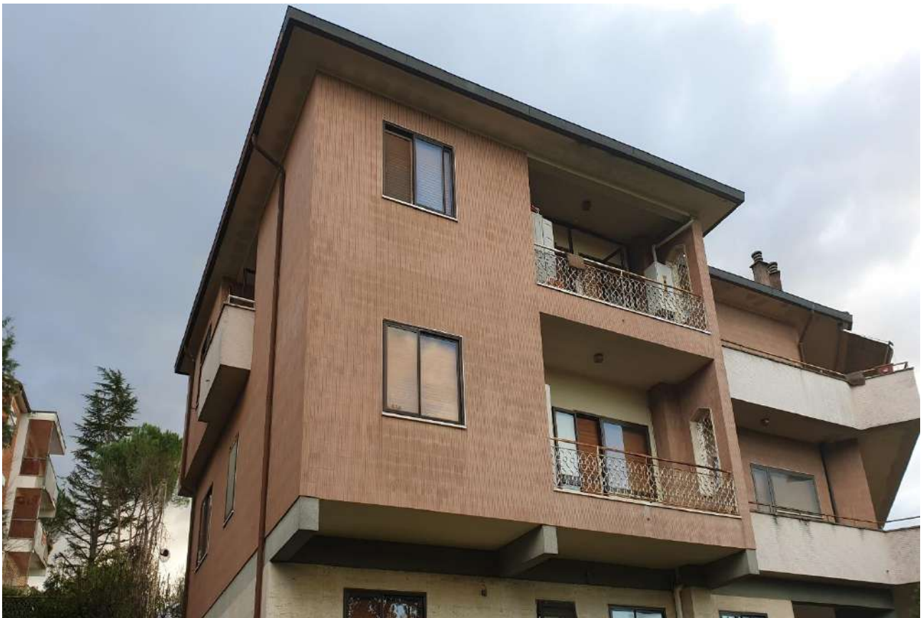
FOTO 2: Veduta prospettica lato Sud-Est
