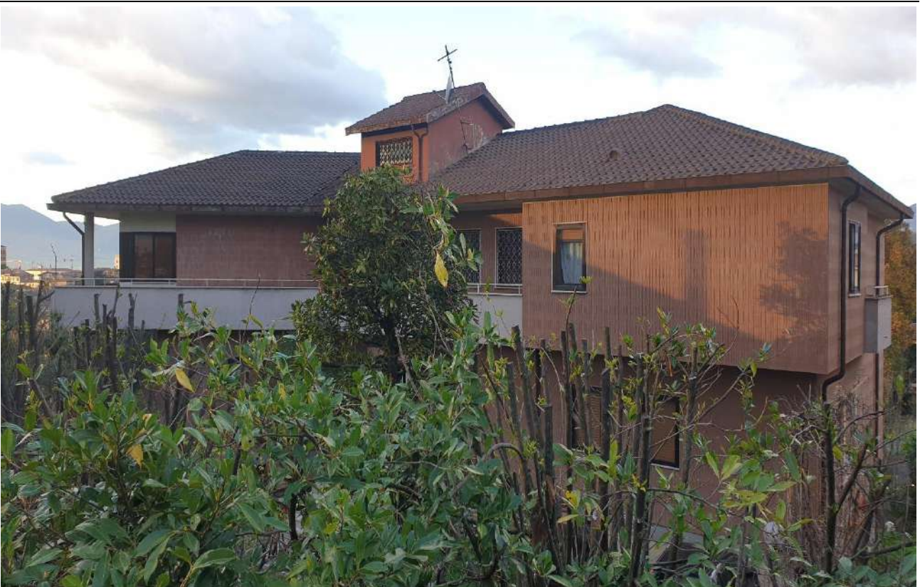
FOTO 1: Veduta prospetto principale lato Sud
