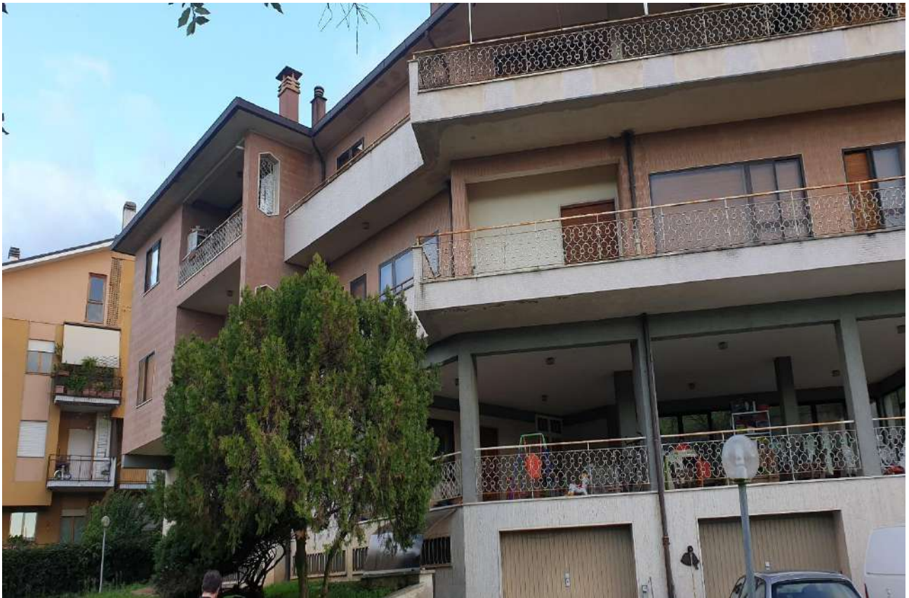
FOTO 3: Veduta prospettica lato Nord
