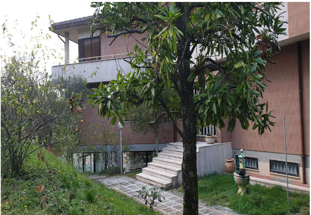
FOTO 4: Veduta prospettica lato Sud-Est
