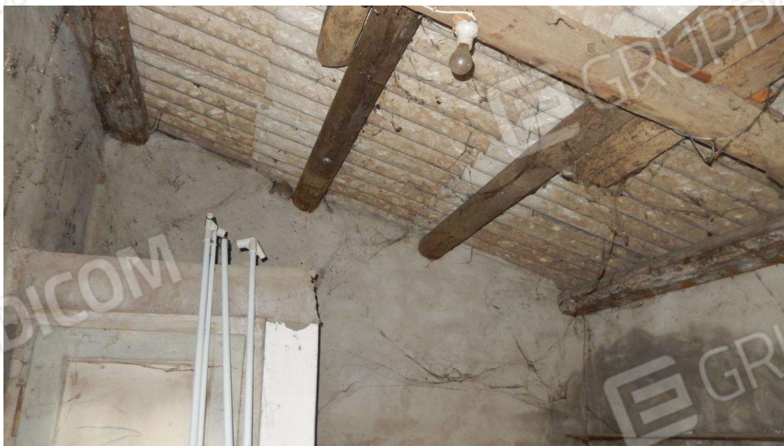
PARTICOLARE PROSERVIZIO I CON LATRINA
