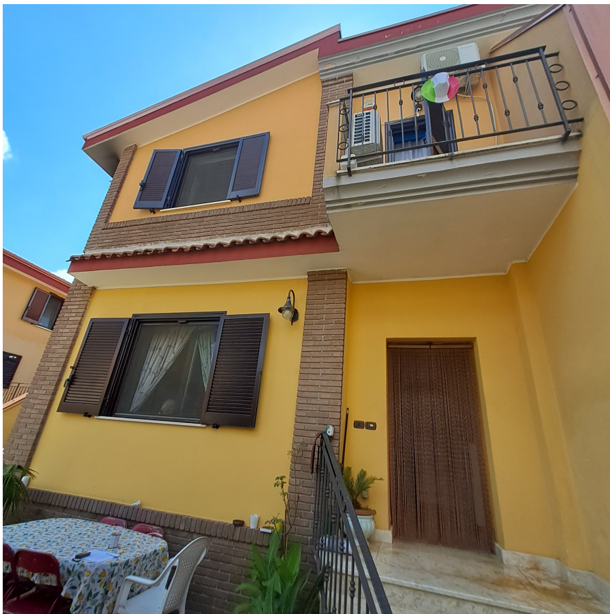
Accesso al piano terra dal cortile
