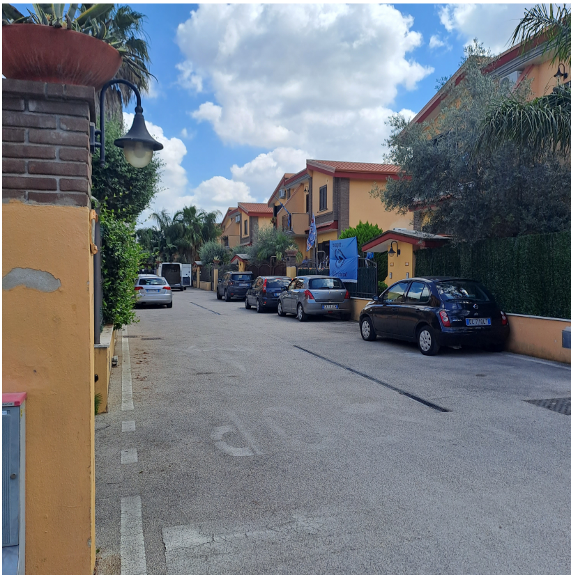
Viale di accesso al fabbricato
