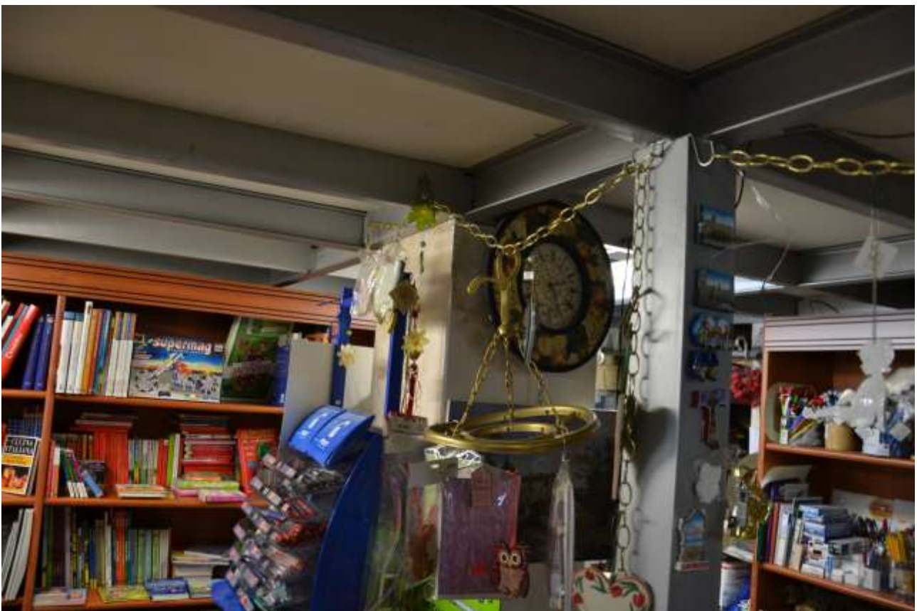
Vista interno - piano terra e struttura soppalco
