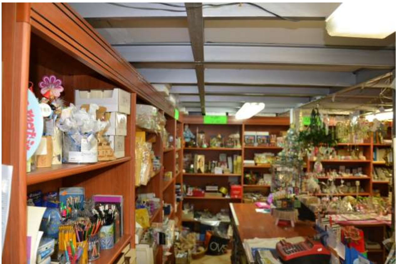
Vista interno - piano terra e struttura soppalco
