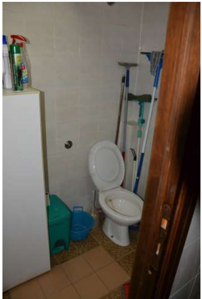
Vista bagno piano terra
