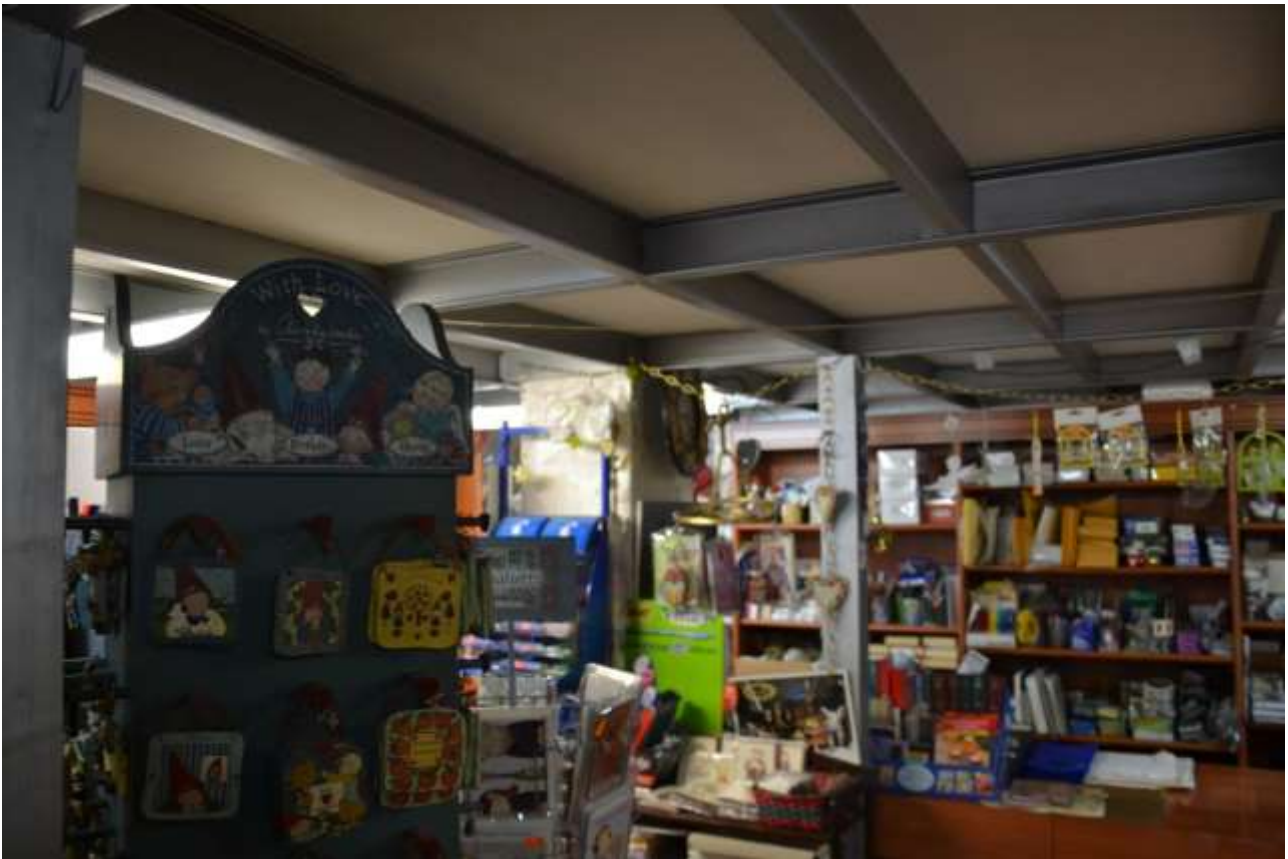
Vista interno - piano terra e struttura soppalco
