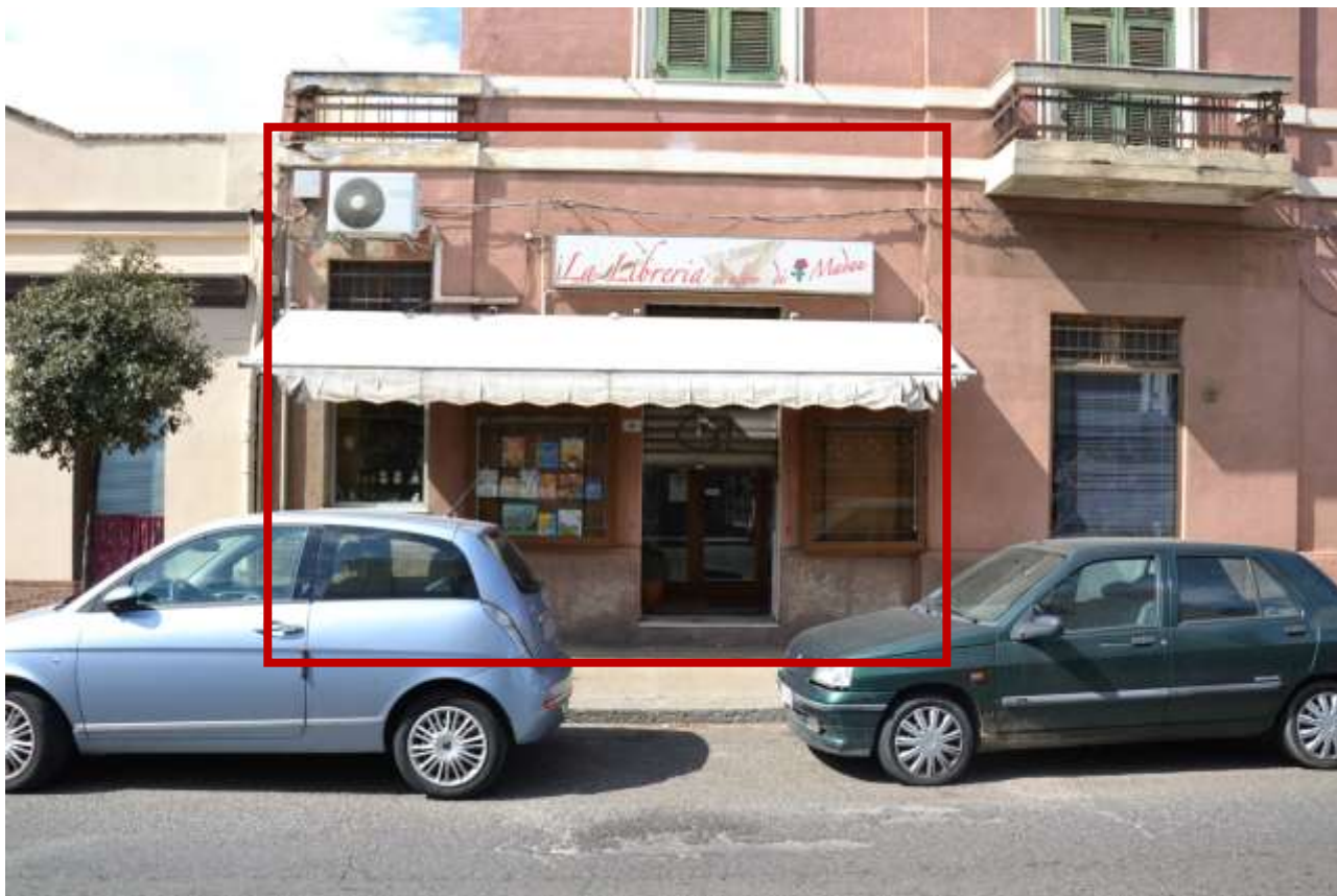
Vista immobile da Via Cattaneo
