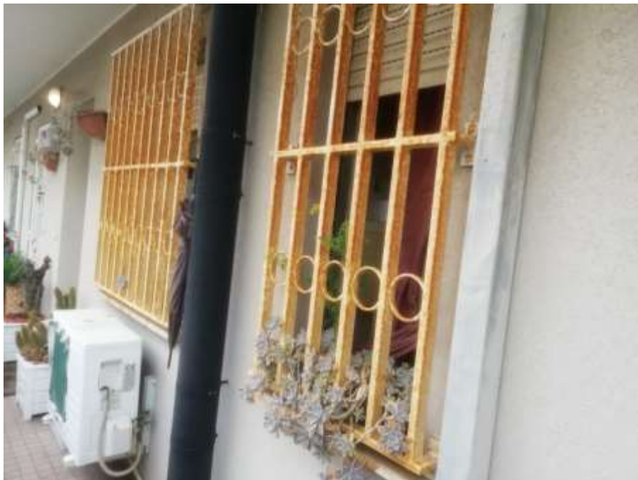
Foto n. 2 – Esterno – zona ingresso
